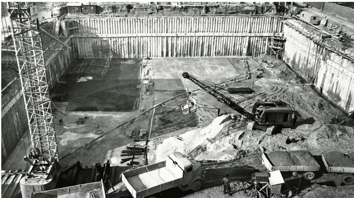
Abb. 2: Baugrube des Bayerischen Rundfunks (BR – Archiv, 2019)
