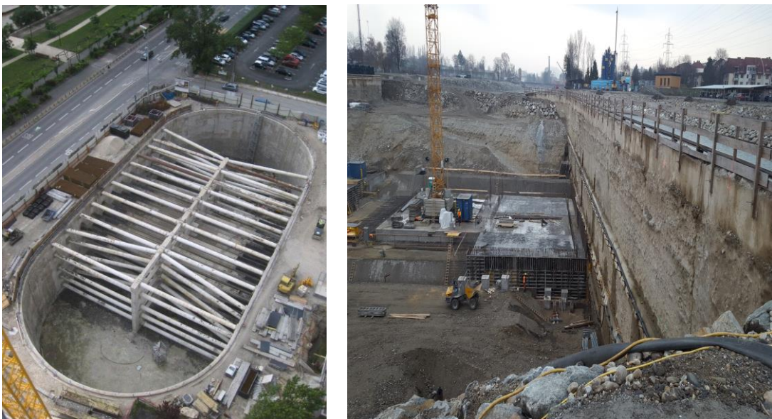
Abb. 1: Baugruben, links: ausgesteift (Bauer Spezialtiefbau 2019), rechts: geankert (IBG, 2019)
