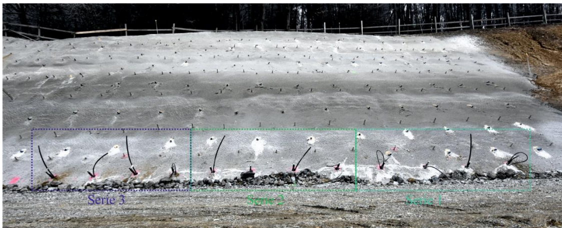
Abb. 8: Installierte Versuchskörper im Bereich der gesicherten Einschnittböschung Tunnel Rudersdorf
