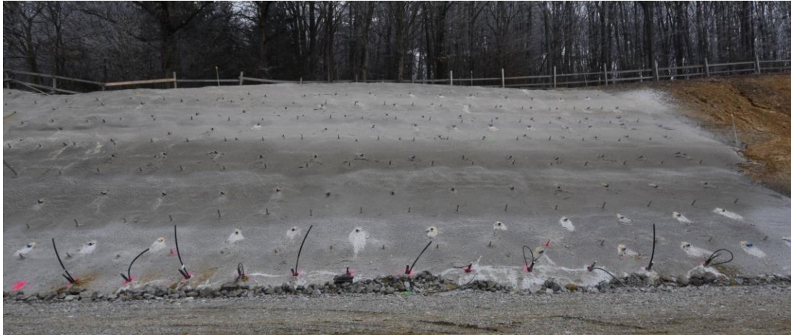
Abb. 34: Versuchsfeld mit eingebauten Ankern
