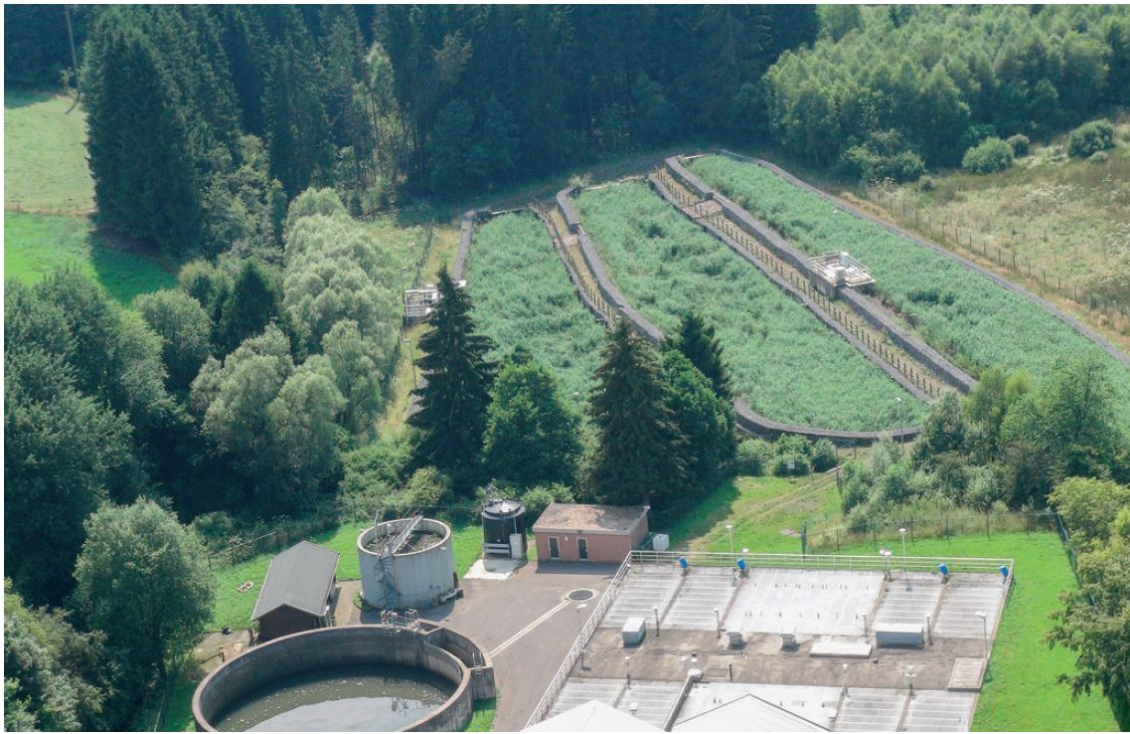
Abbildung 4-16: Retentionsbodenfilteranlage bei der ARA in Konzen (Grotehusmann et al., 2015)
