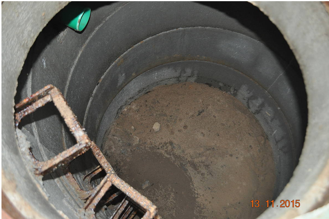
Abbildung 4-6: Sohle eines Versickerungsschachts (Matzinger et al., 2017)
