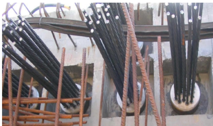
Abbildung 4-7: Spannanker von Litzenbündeln [37]
