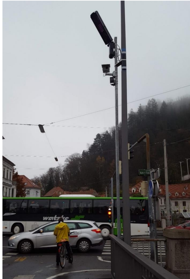
Abbildung 47: Messstelle Keplerbrücke – CITIX 3D
