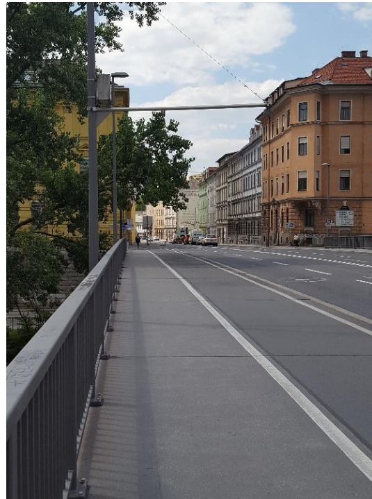
Abbildung 10: Zählstelle Stadt Graz – Keplerbrücke
