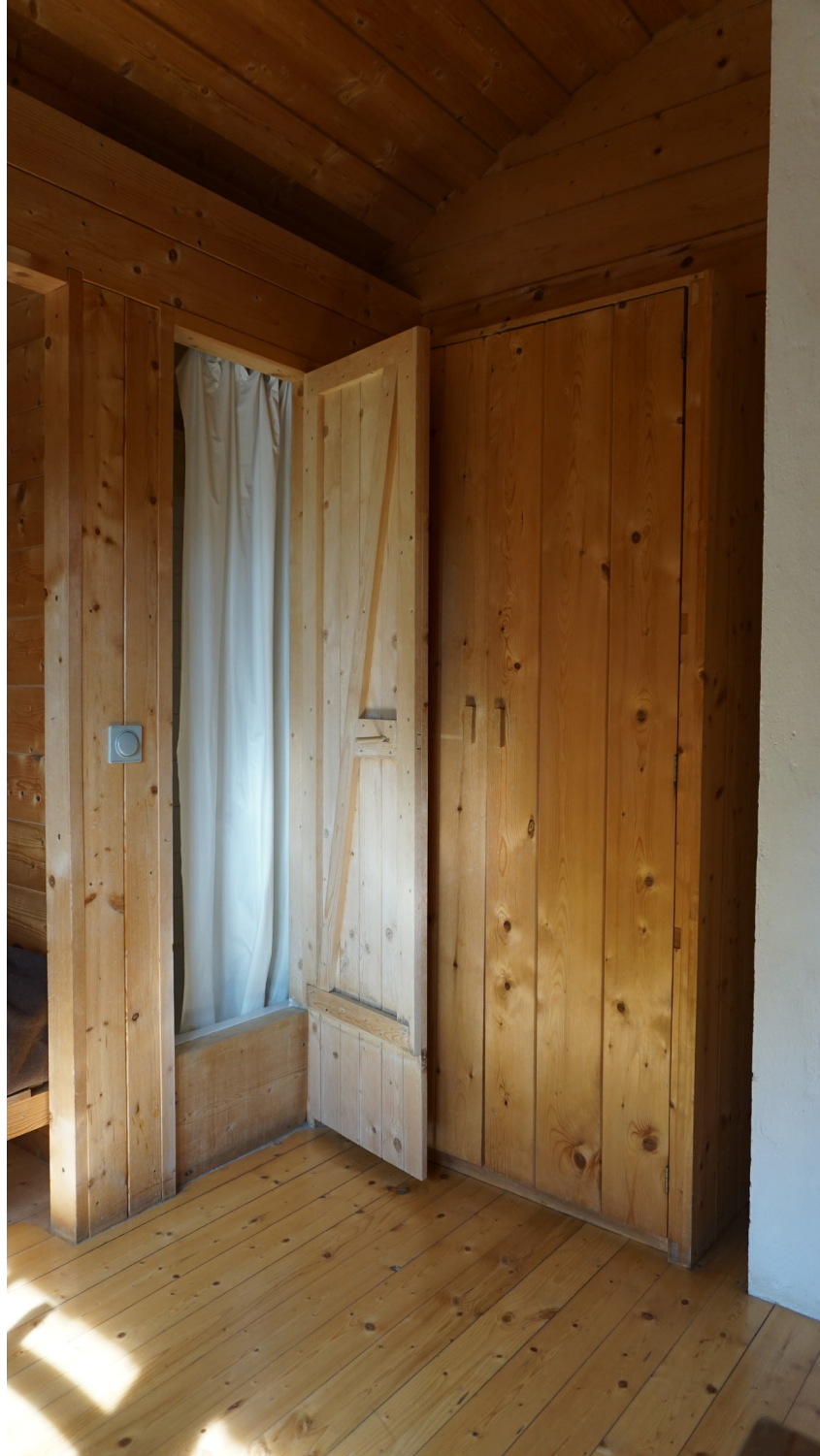
Abb.125: Wie die Toilettenzelle ist auch der kleine Waschraum der Eremitage in eine Nische eingebaut.
