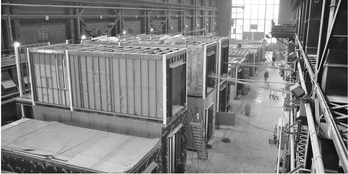
Abb.82: Der im Jahr 2016 fertiggestellte Carmel Place von nARCHITECTS, ein Wohngebäude welches sich aus loftartig übereinandergestapelte Wohnmodule ergänzt durch Gemeinschaftsfläche zusammensetzt.
