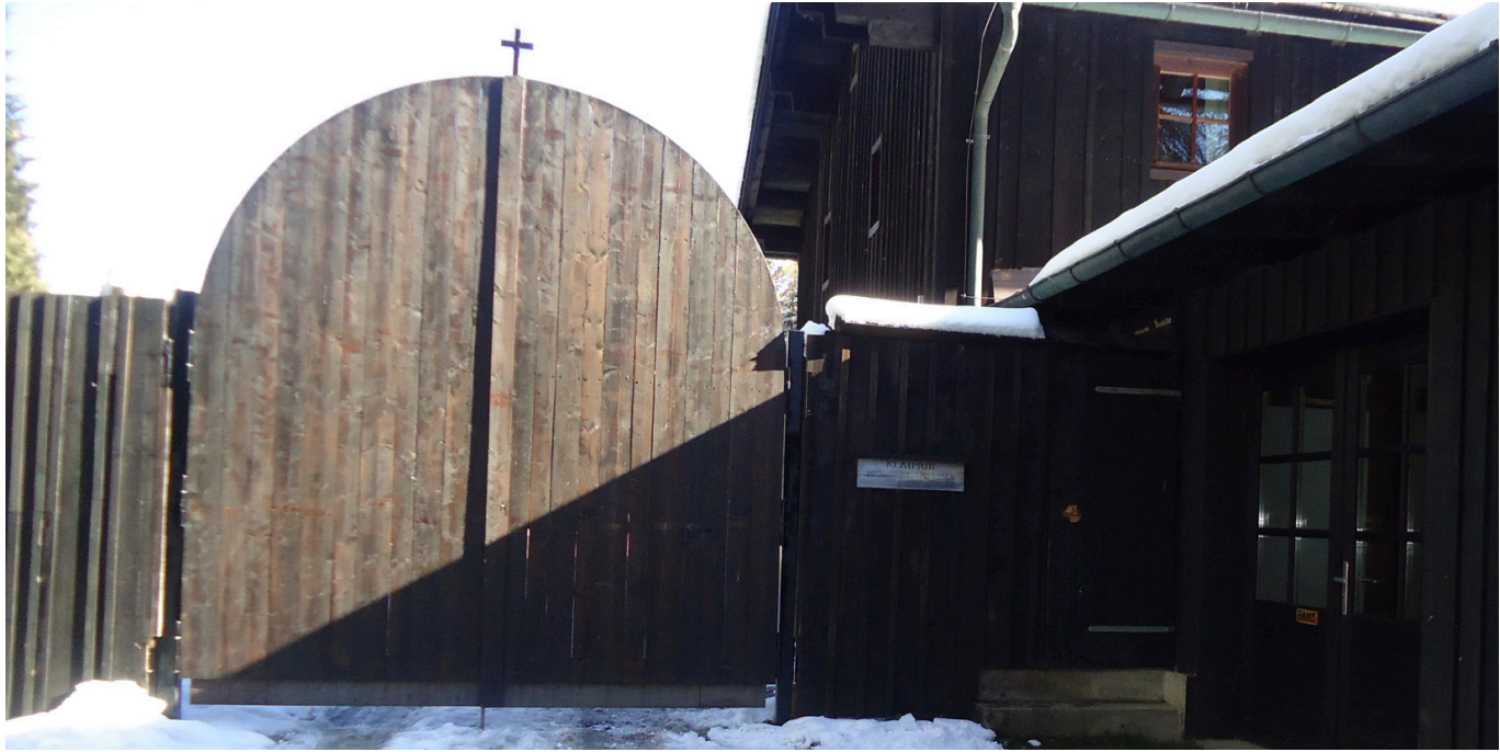
Abb.103: Die Eingangspforte in den Gästebereich des „Unteren Hauses“.
