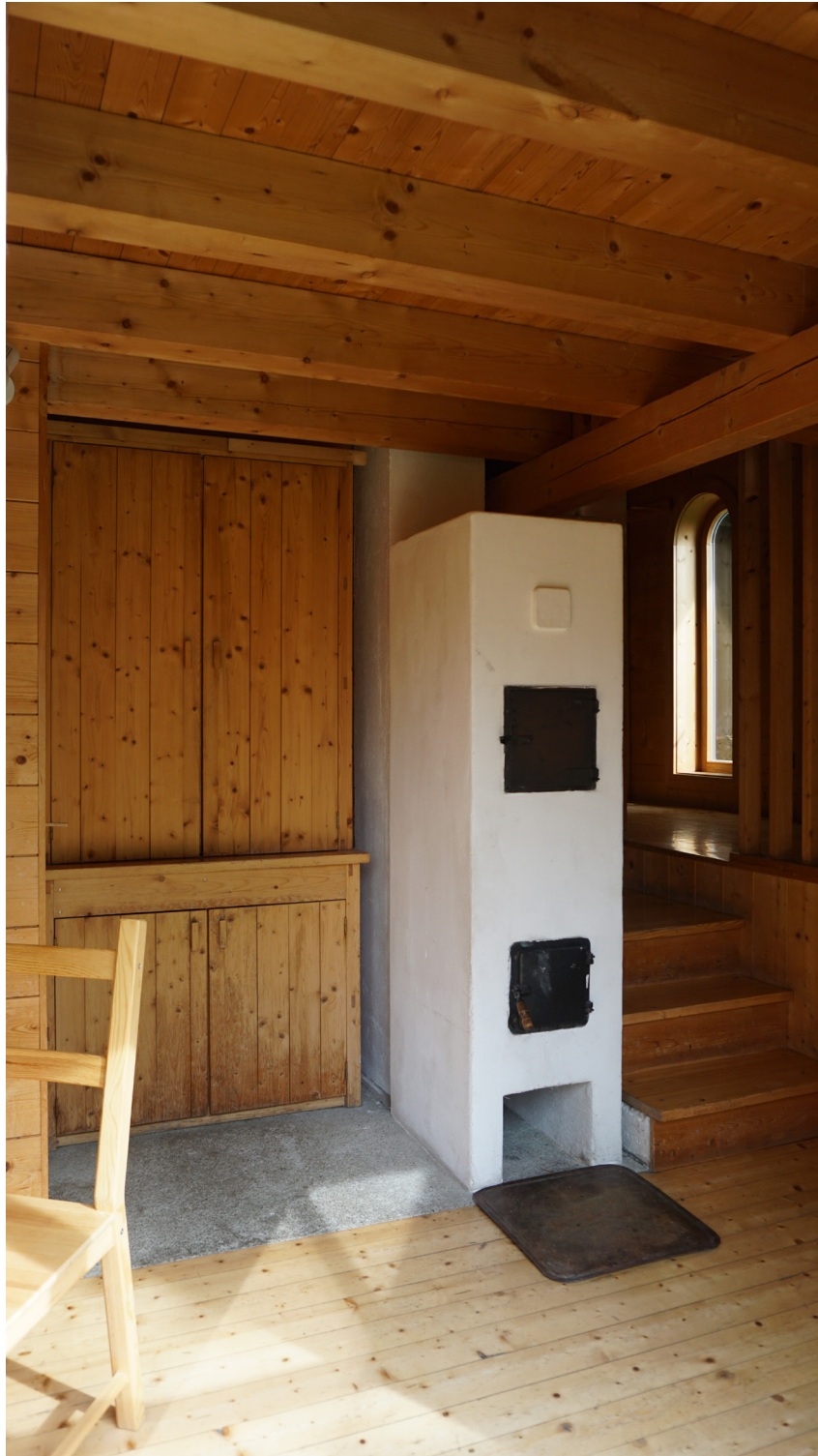
Abb.120: Beheizt wird die Eremitage im Winter über einen Ofen, Holz dafür wird im Garten oder in der Praecella gelagert.
