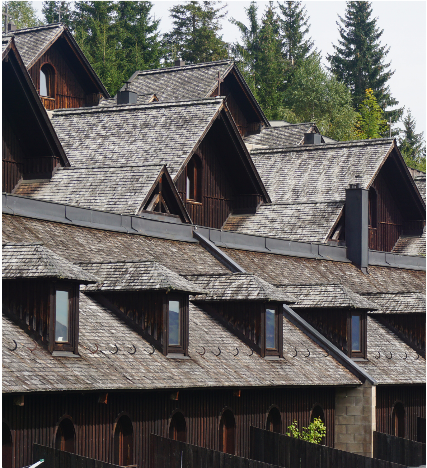
Abb.100: Der Ateliertrakt des „Oberen Hauses“.
