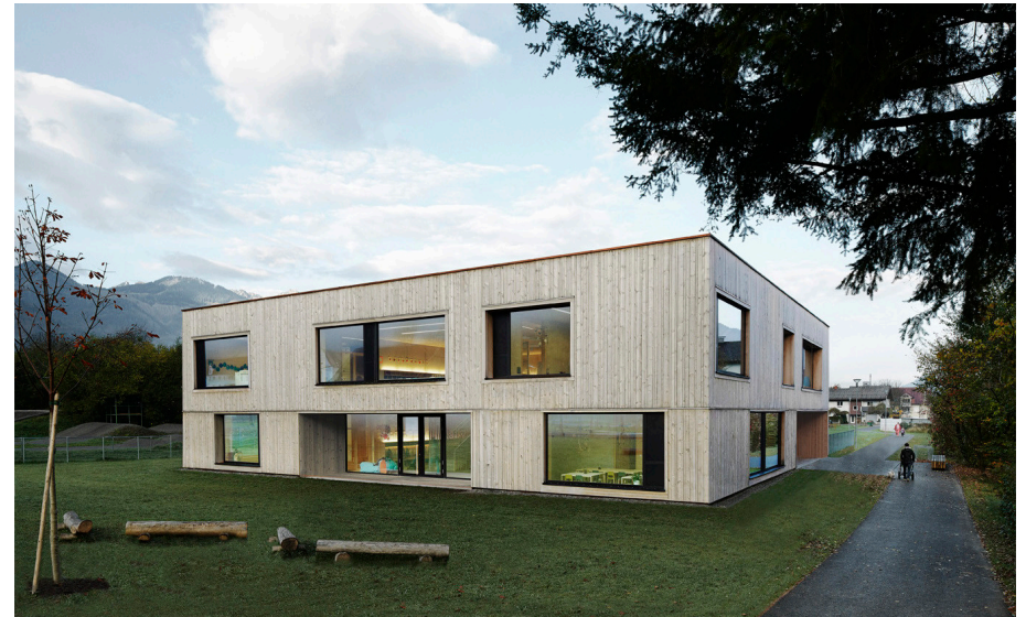
Abb. 13 Kindergarten Susi Weigel, Ansicht 2
