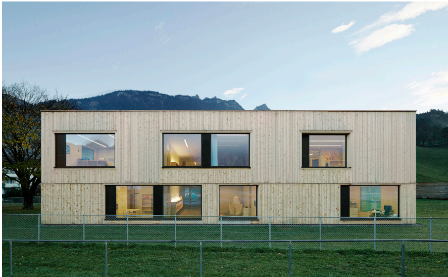
Abb. 12 Kindergarten Susi Weigel, Ansicht 1
