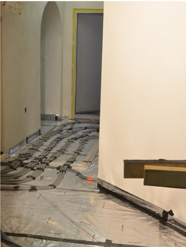
Abb.215. Gang: verputzt und gekalkt. Dampfbremse & Elektroleitungen
