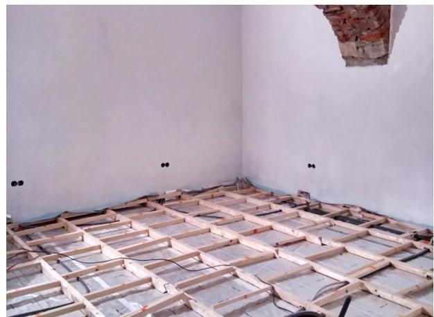
Abb.245. Verlegen der Bodenunterkonstruktion
