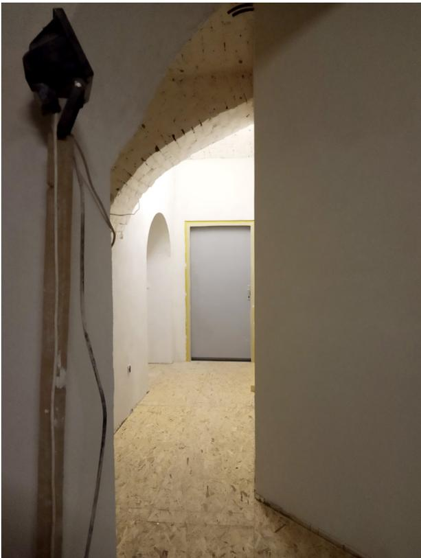
*Abb.219. Gang: fertiger Rohboden*
