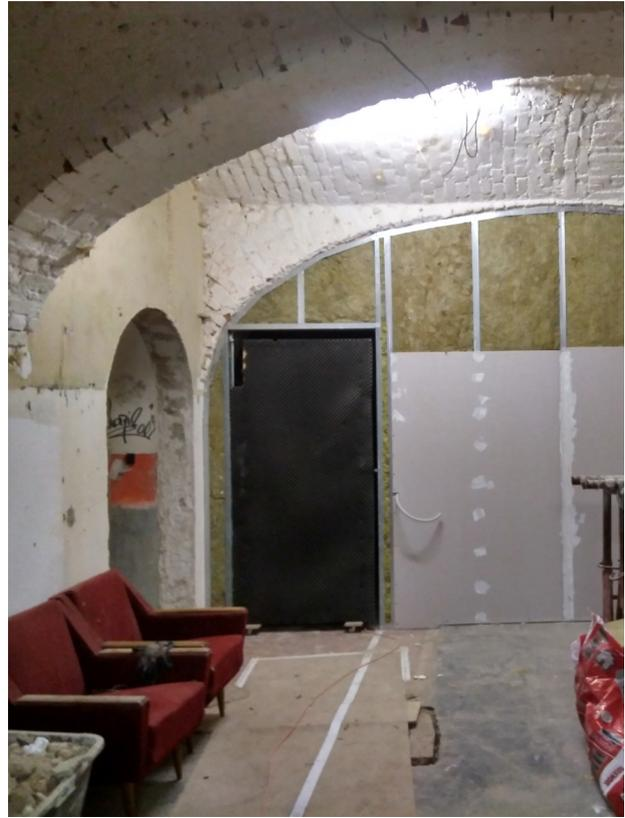
Abb.214. Gang: Errichtung Zwischenwand Proberaum 2
