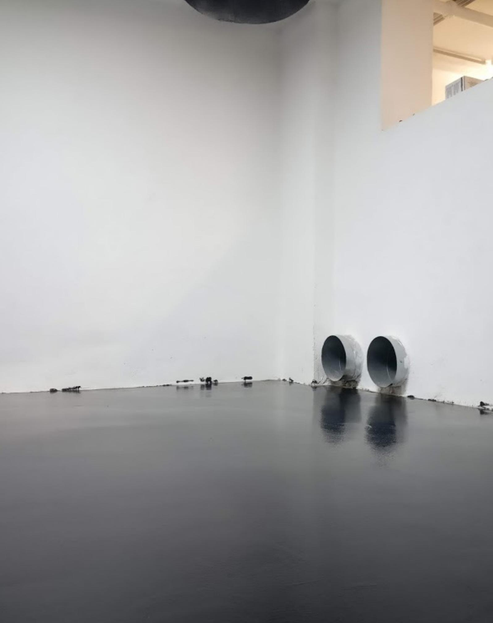
*Abb.210. Zwischenergebnis Werkstätten: Ausgegossener Boden mit erstem Anstrich*
