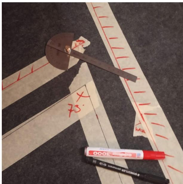
Abb.187. Position der Deckenkassetten auf Klebeband am Boden
