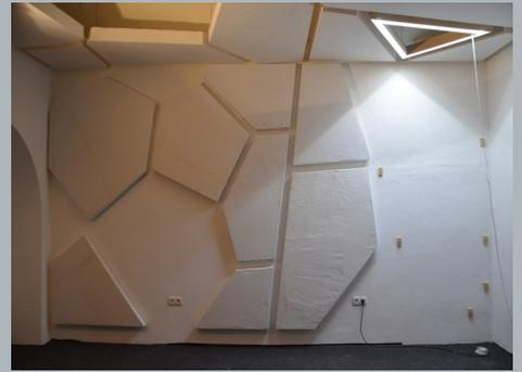
Bereits mit den ersten montierten Paneelen zeigte sich, dass die Befestigungsmethode funktionell eine wesentliche Verbesserung darstellte. Aufgrund der Materialeigenschaften der verwendeten OSB/3-Streifen stellten sich jedoch nach einigen Auf- und Abhängevorgängen erste leichte Verschleißerscheinungen am Rahmen ein. Der Verschleiß führte zu einem spürbaren Spiel und Vibration unter Bassbeschallung, was über kurz oder lang zu einem unerwünschten Mitschwingen führen konnte.
