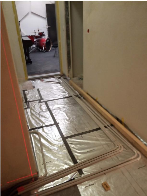
Abb.156. Verlegen der Dampfsperre mit Vlies und Verkleben der Stöße
