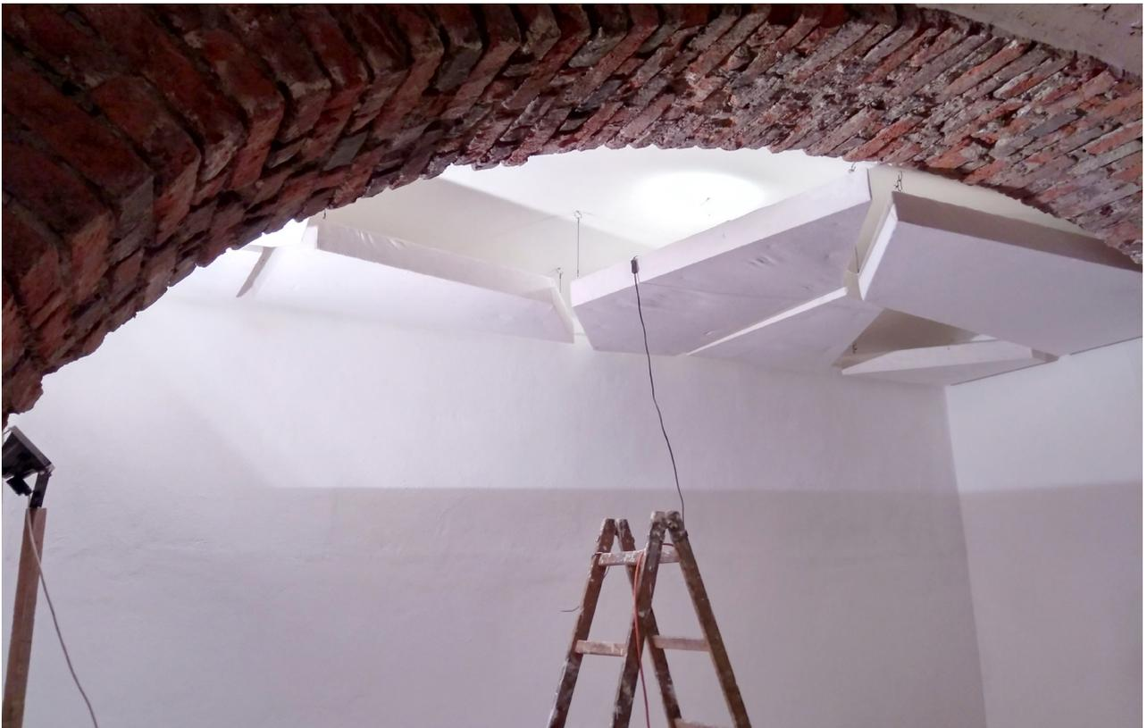
Abb.247. Prototypen Akustikpaneele - Hinterleuchtungsversuche für diffuse Gewölbebeleuchtung
