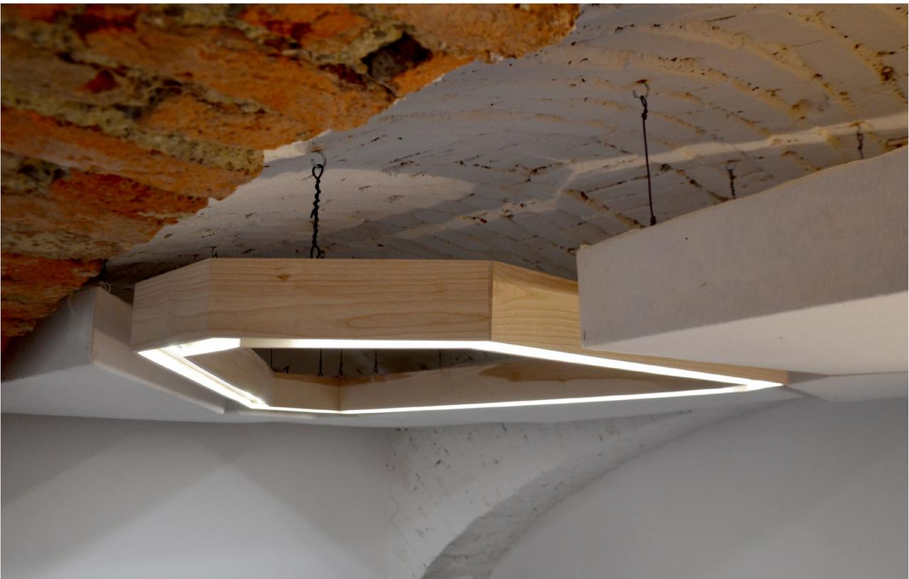
*Abb.249. Detail Polygonale Leuchte in der Deckenstruktur*
