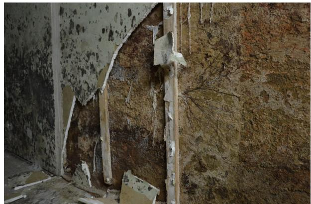
Abb.142. Fabrikationshalle, 2014: Ausgeprägter Pilzbefall
