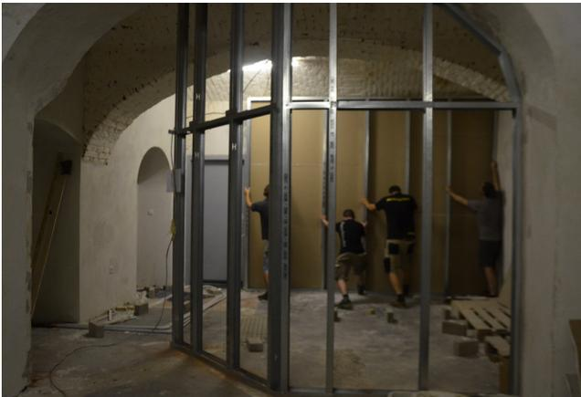
Abb.153. Aufstellen des Bauteiles hinter anlaufender Wand
