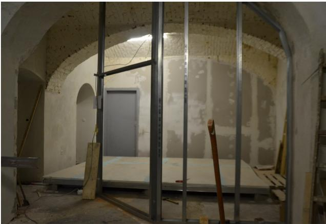
Abb.152. Liegendes Bauteil, rückseitig beplankt und verspachtelt
