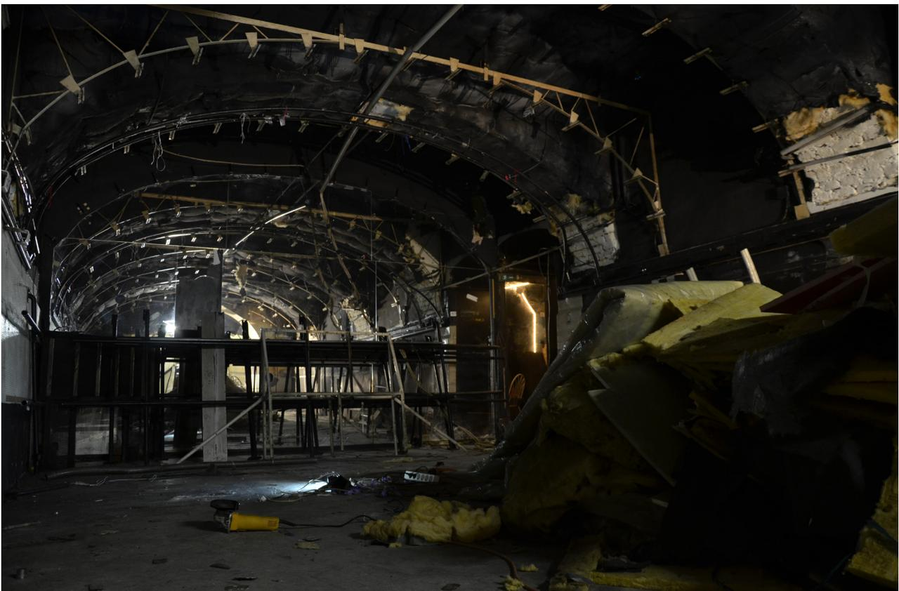
*Abb.138. Galtunnelhalle Altkeller: Rückbau der Unterkonstruktion und Innendämmung*
