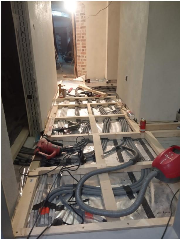
Abb.160. Nebenraster und Verdübelung des Haupttrasters im Boden
