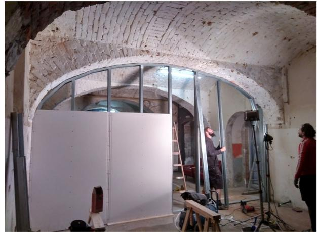
Abb.241. Beplankung Zwischenwand
