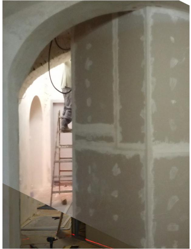
*Abb.218. Gang: nach Errichtung der Trockenbauwand Proberaum 3*
