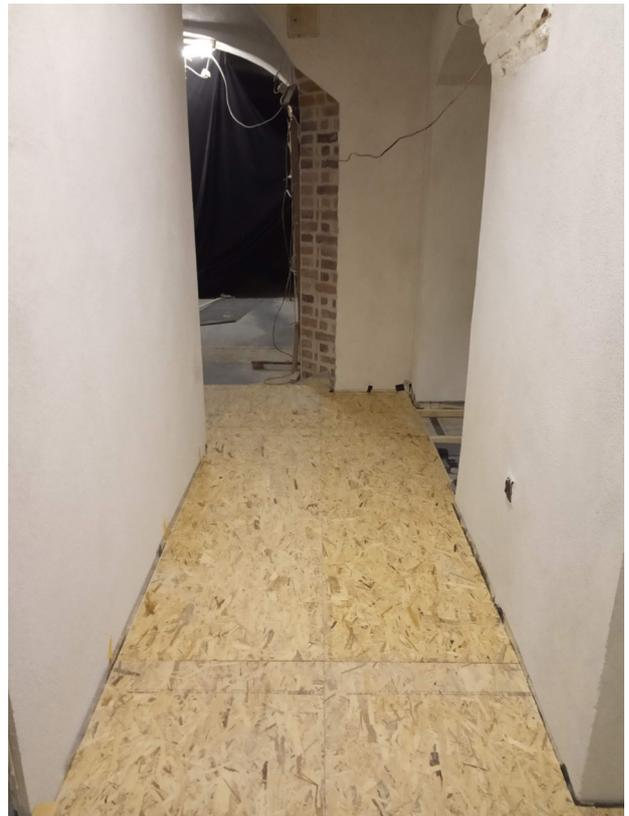
Abb.161. Plattenbelag der Unterkonstruktion mit OSB/3-Platten
