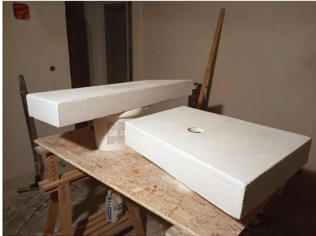
Abb.204. Verputzte und gekalkte Deckenkassetten am Gang
