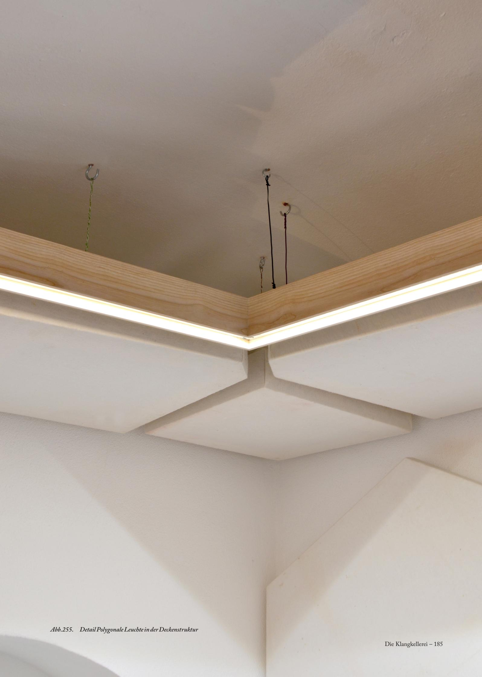
*Abb.255. Detail Polygonale Leuchte in der Deckenstruktur*
