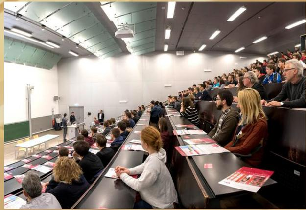
Abb.81. Hörsaal der TU Graz in der Inffeldgasse mit angewinkelten Reflektorplatten an der Decke
