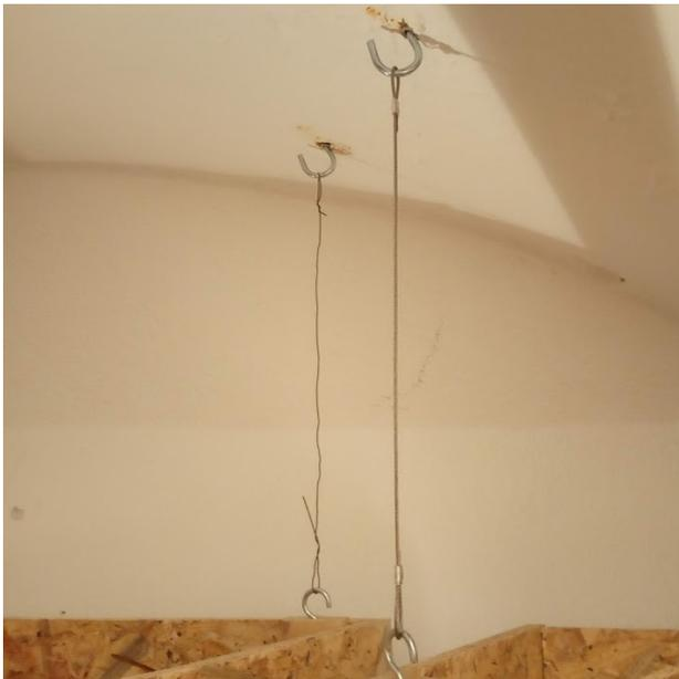
Abb.190. Hängepunkte mit Provisorium (hinten) und Stahlseilen (vorne)
