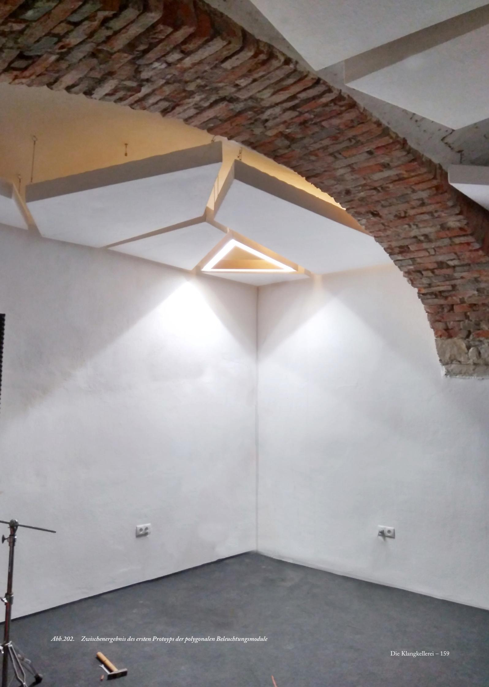
*Abb.202. Zwischenergebnis des ersten Protoyps der polygonalen Beleuchtungsmodule*
