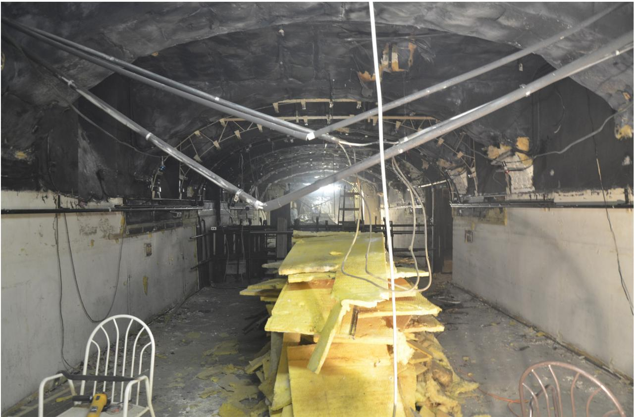
Abb.139. Glastunnelhalle im Altkeller, 2014: Demontage der Elektroleitungen
