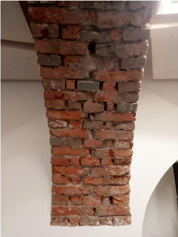
Abb.231. Mauerwerk des gedrückten Bogens
