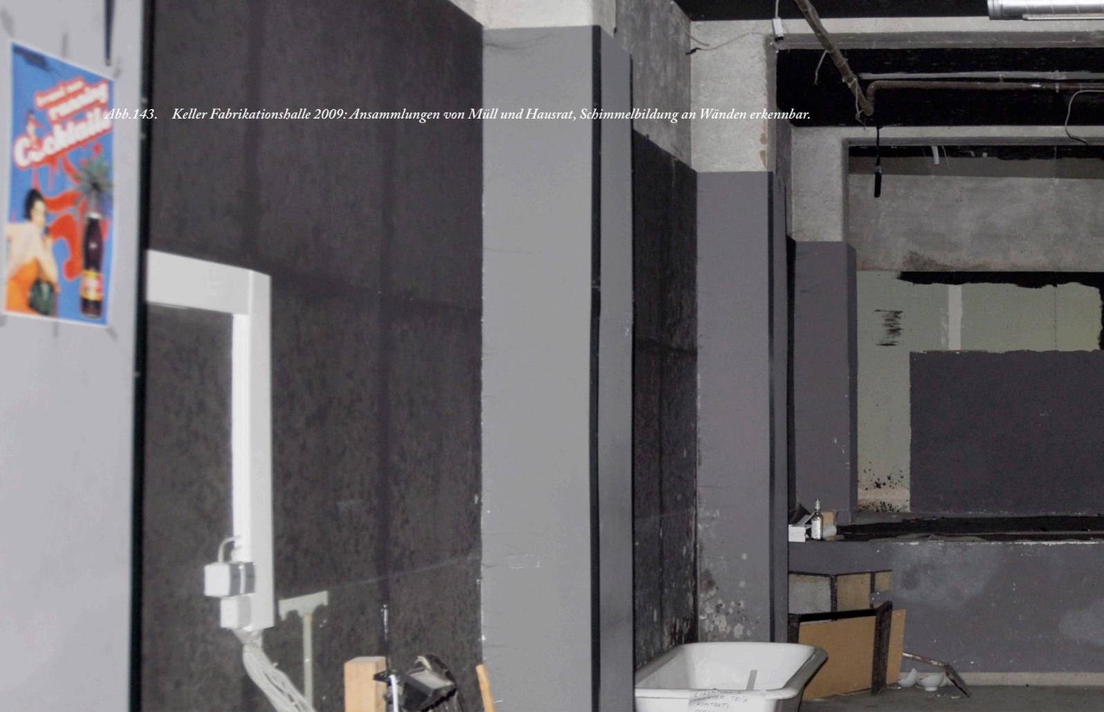
Abb.143. Keller Fabrikationshalle 2009: Ansammlungen von Müll und Hausrat, Schimmelbildung an Wänden erkennbar.
