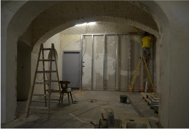
Abb.151. Einrichten und Vernieten des Ständerwerkes zu einem Bauteil
