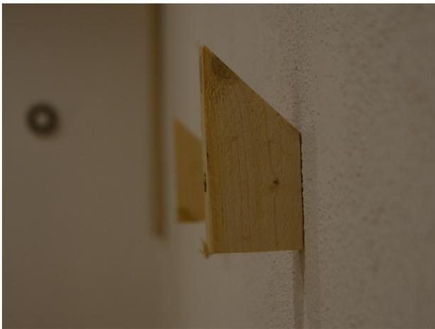
Abb.191. Holzblöcke zur Befestigung der Wandpaneele
