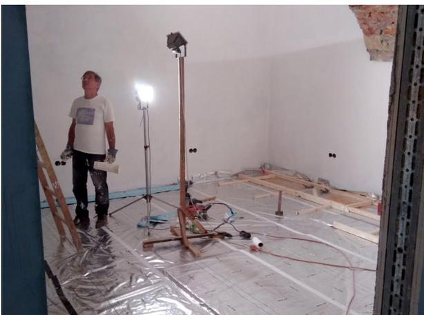
Abb.244. Verlegen der Dampfbremse nach Streichen
