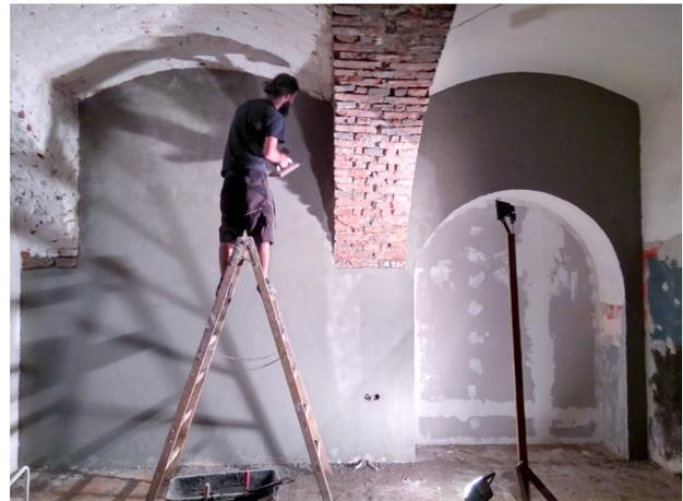
Abb.243. Verputzen der Innenwände
