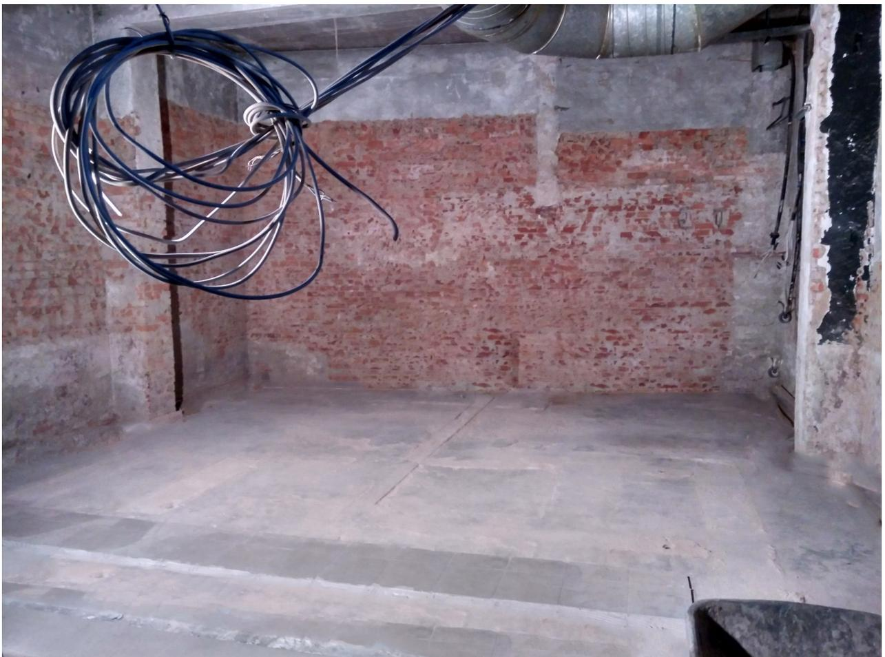
Abb.144. Fabrikationshalle, 2017: Leere Halle nach Abbruch der Innenausstattung und des Putzes, Abbruch der Bühne und nichttragenden Wände.
