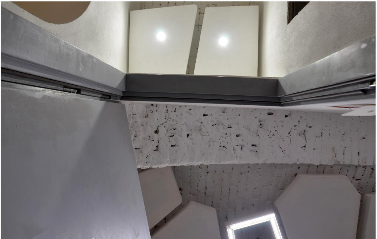
*Abb.230. Detail Decke: Tür Proberaum 2, Gangbeleuchtung (oben) sowie gedrückter Bogen und Akustik- bzw. Beleuchtungsmodule (unten)*
