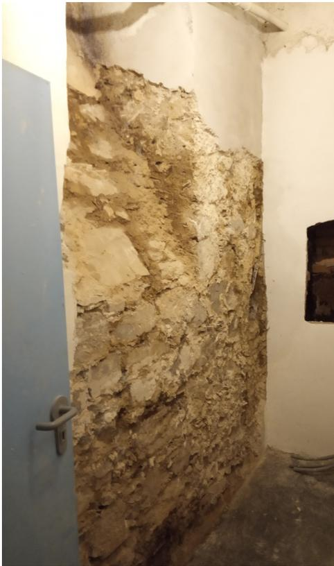
Abb.222. Wassereinbruch 2019: Abgetragener Putz
