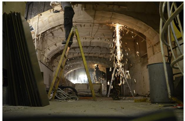
Abb.136. Glastunnelhalle, 2014: Demontage Stablunterkonstruktion
