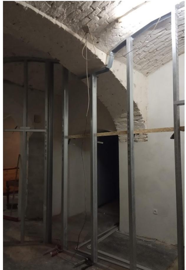
Abb.155. Verschneidung mit der Wand mit komplexer Gewölbegeometrie
