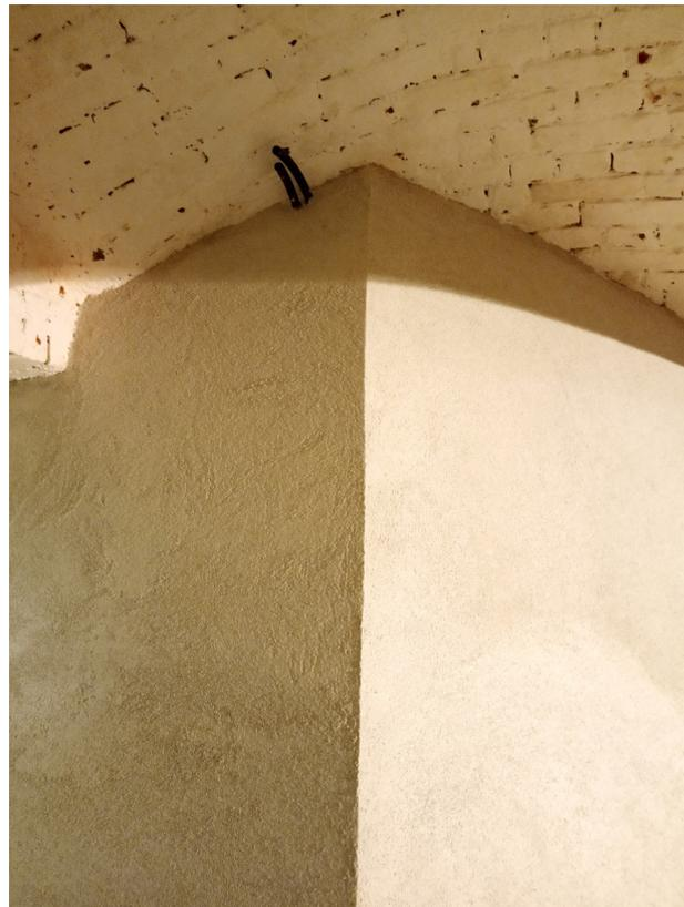
*Abb.227. Detail Trockenbauwand: Verschnitt mit dem Gewölbe*
