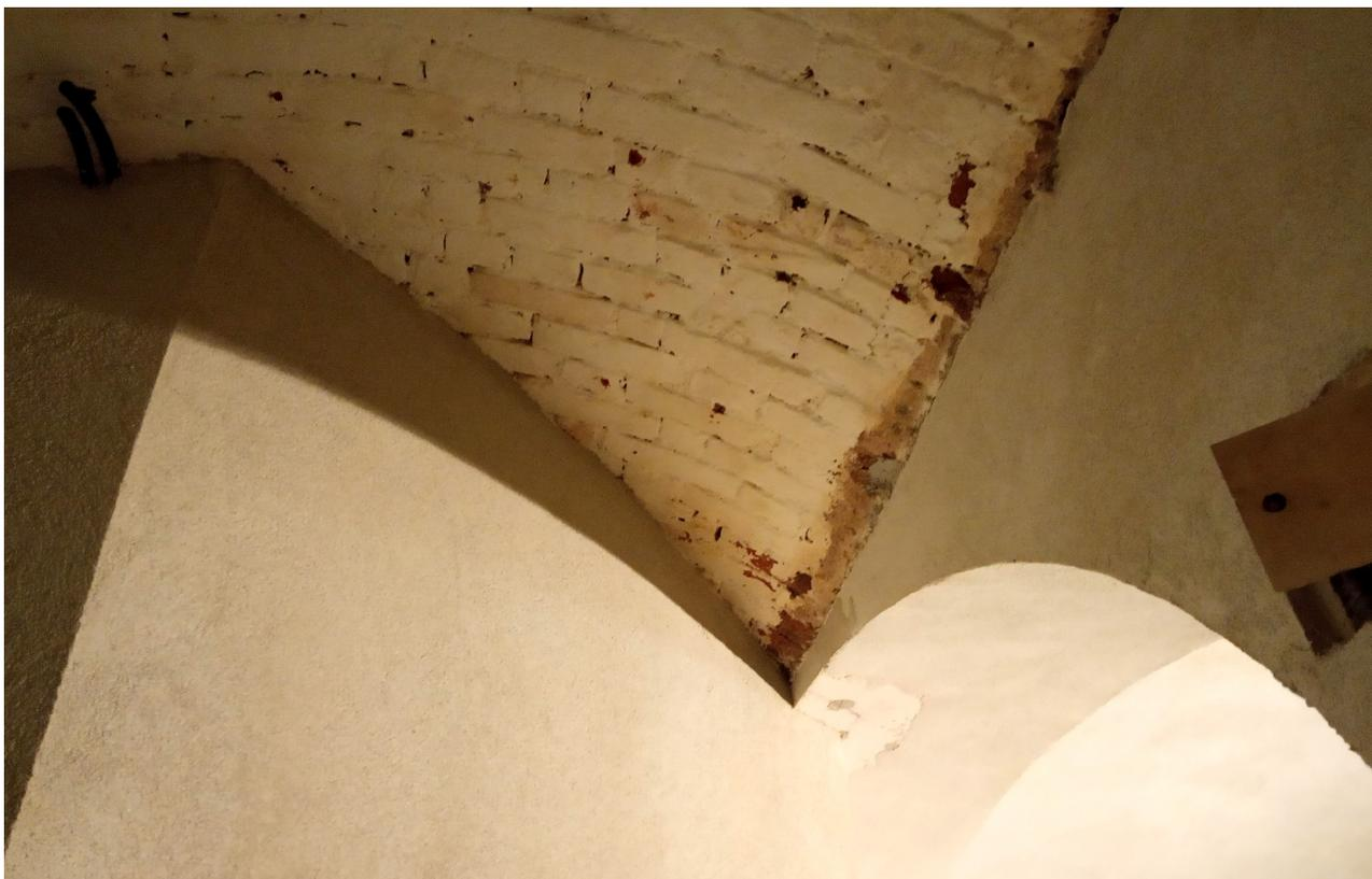
*Abb.228. Detail Trockenbauwand: Verschnitt mit dem Gewölbe*
