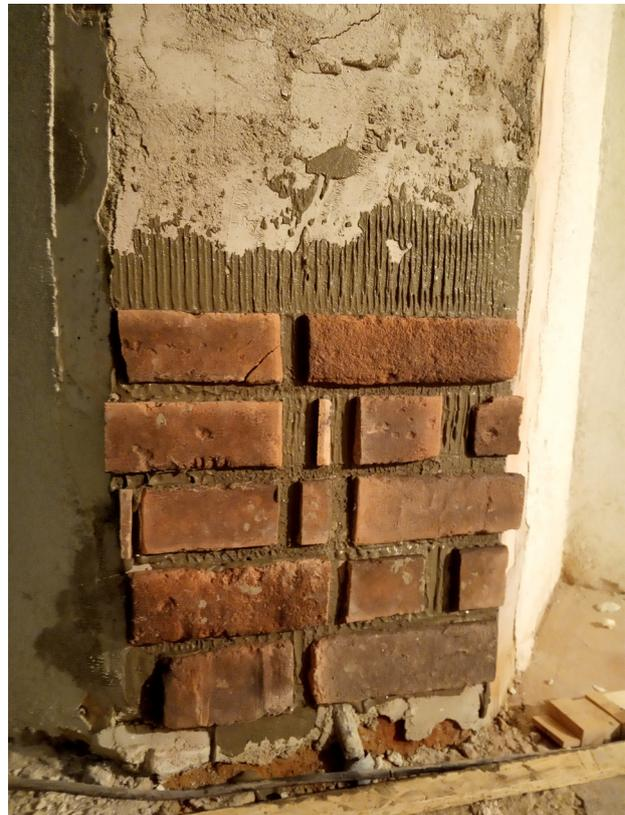
Abb.234. Aufbringen des Schnittmusters auf die Schnittfläche
