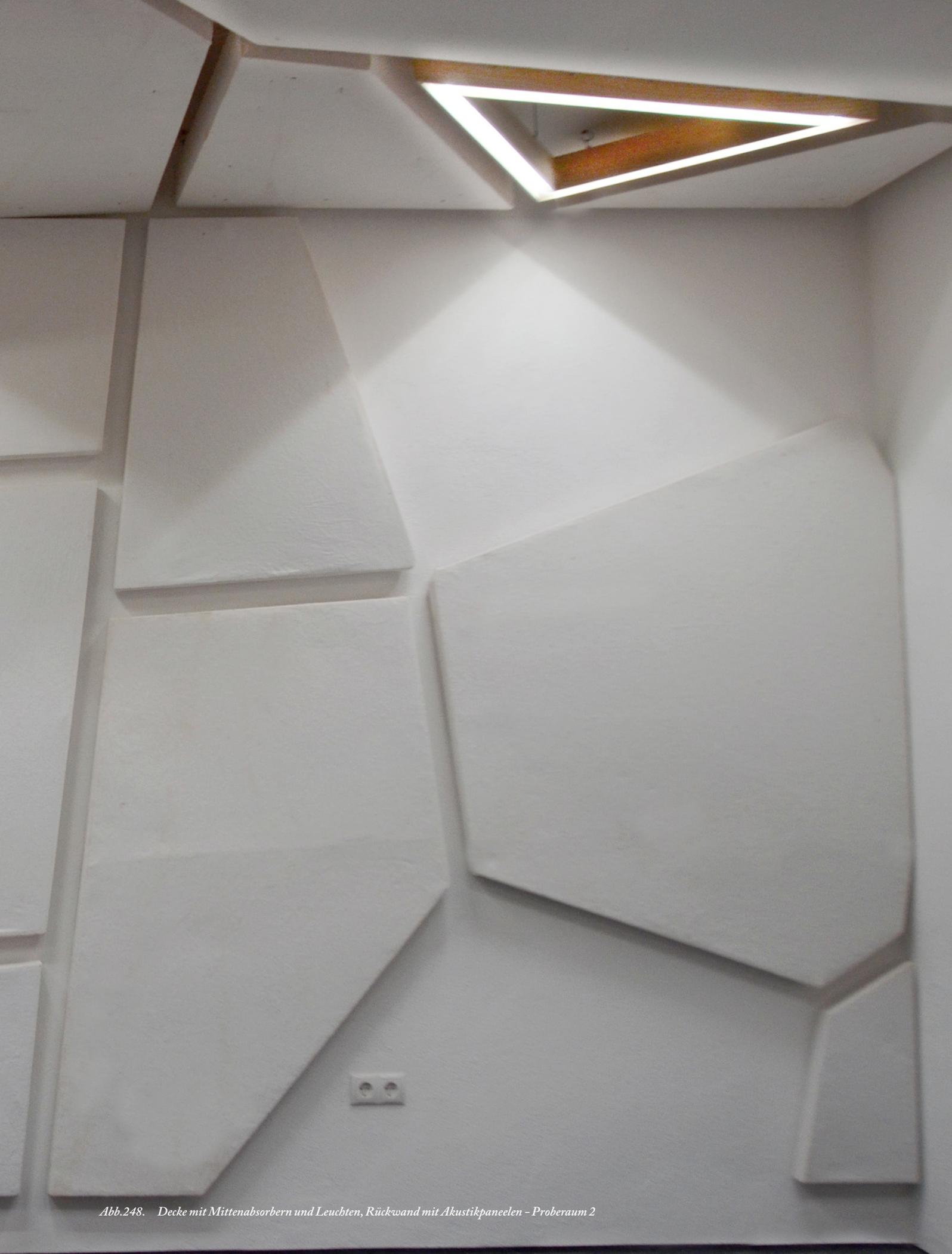
*Abb.248. Decke mit Mittenabsorbern und Leuchten, Rückwand mit Akustikpaneelen - Proberaum 2*
