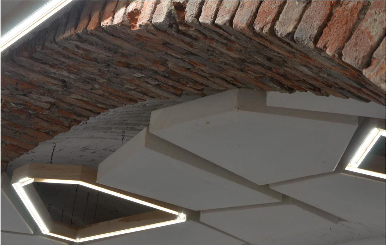
Abb.254. Deckenstruktur mit Ansicht des gedrückten Mauerbogens
