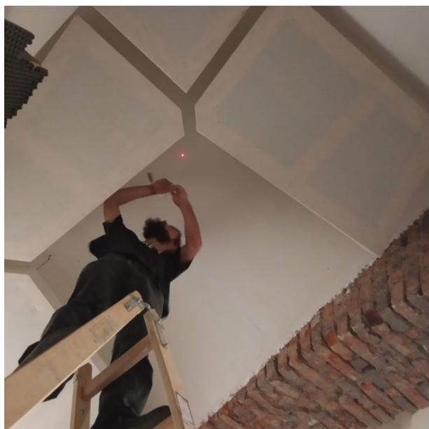
Abb.189. Projektion der Hängepunkte vom Boden in das Gewölbe
