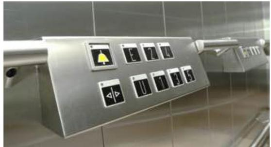
Abbildung 8: Bedienfeld eines Fahrstuhls nach dem Zwei-Sinne-Prinzip
