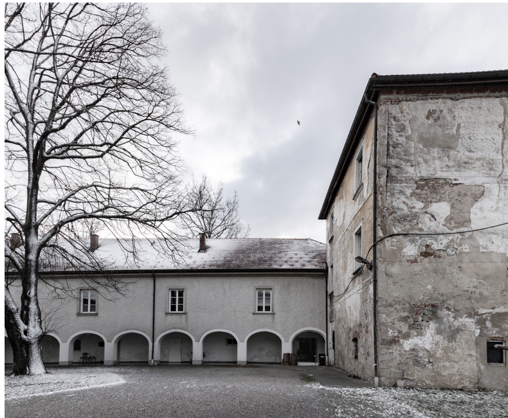
Innenhof mit Turmgebäude und Südtrakt
