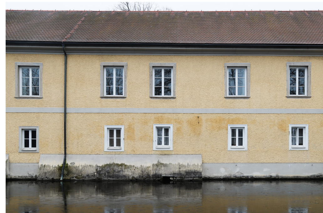
Südtrakt mit Schlossgraben
