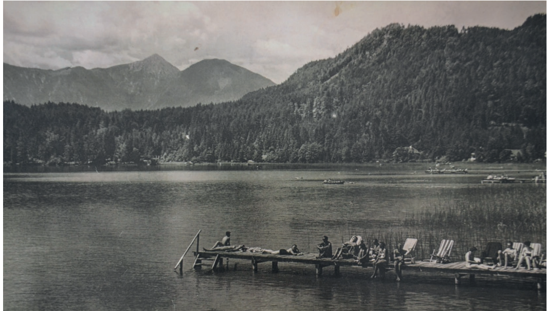
36 Historische Aufnahme 01: Blick auf Hochobier
