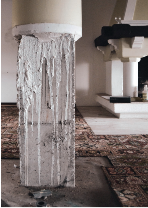
02 Freigelegte Betonstütze
