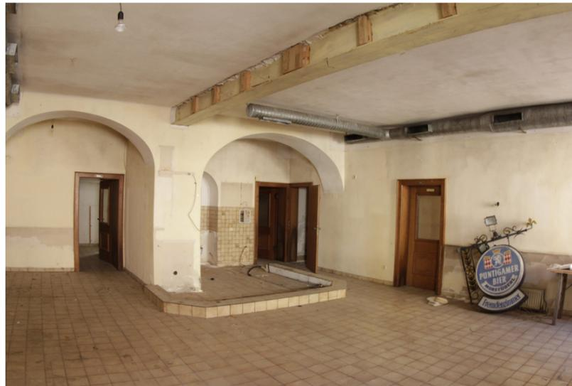
eine durchgesteckte Säulenhalle. Diese Vermutung wird auch dadurch bestärkt dass die Gewölbe in EG04 eindeutig weitergeführt werden. Außerdem ist eine weitere Säule in der Achse in EG05 erkennbar.
