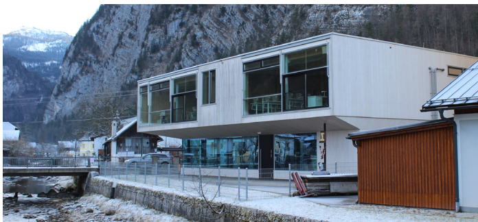
Abb. 46. Erweiterung HTL/HTBLA Zubau Stammhaus
