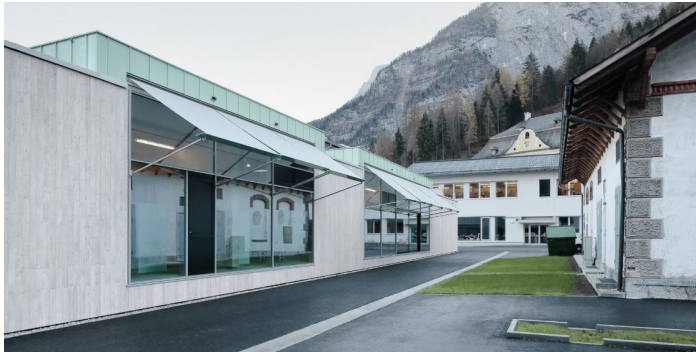
Abb. 43. Erweiterung HTL/HTBLA Holz- und Lacklager
