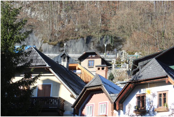
Abb. 49. Bestandsgebäude Ostansicht - Marktplatz
