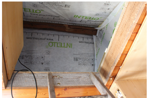
Abb. 58. Bestand Innenraum - ehem. Verkaufsraum
