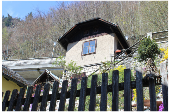
Abb. 50. Bestandsgebäude Ostansicht - Kirchenweg
