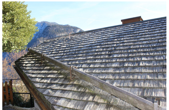
Abb. 28. Holzschindeldach Hallstatt
