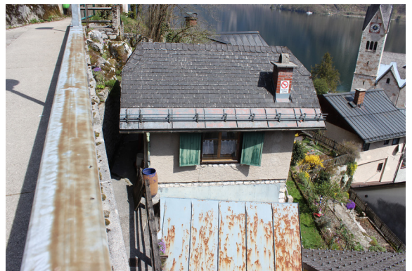
Abb. 52. Bestandsgebäude - Obere Parkterrasse
