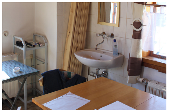
Abb. 60. Bestand Innenraum - ehem. Verkaufsraum
