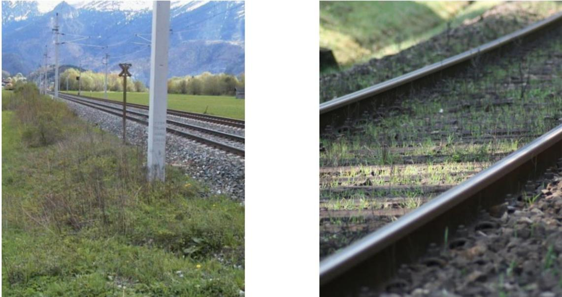
Abb. 6: Verwachsener Entwässerungsgraben und Gleisschotter (Holzfeind, TU Graz)
