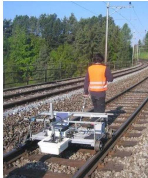
Abb. 9: Montage der Georadarantennen (©Staccone, Ground Control)
