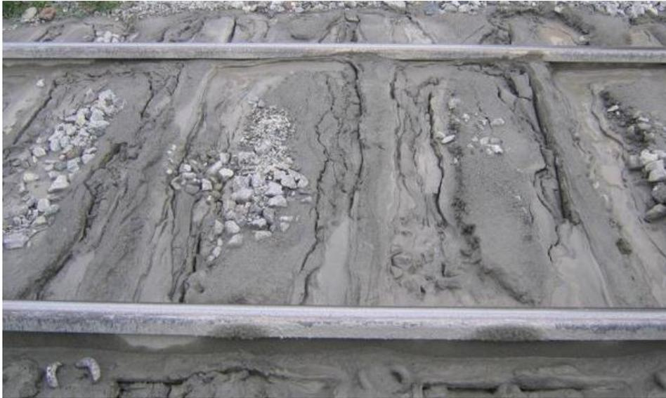
Abb. 2: Schlammstelle im trockenen Zustand (aus Skriptum GB&I, EBW TU Graz)
