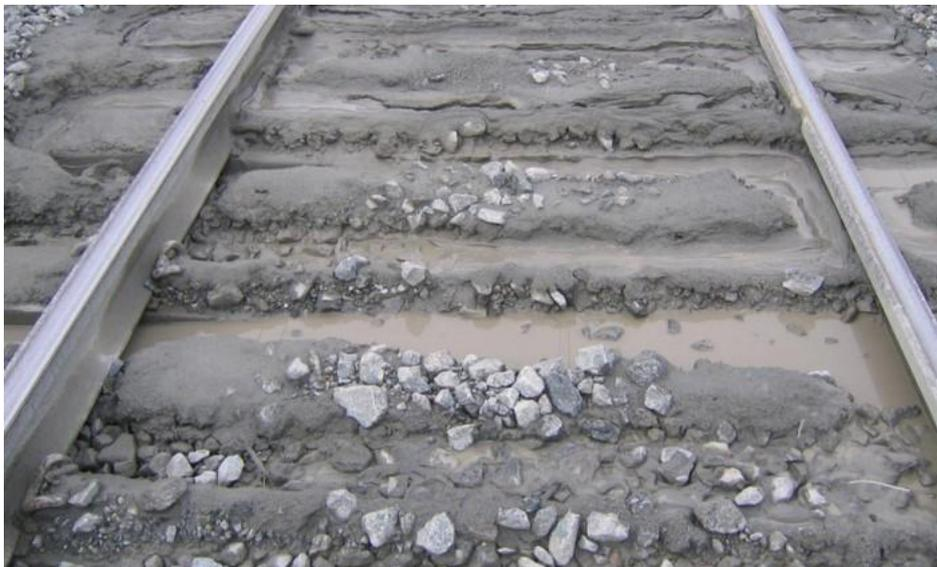
Abb. 1: Schlammstelle im nassen Zustand (aus Skriptum GB&I, EBW TU Graz)
