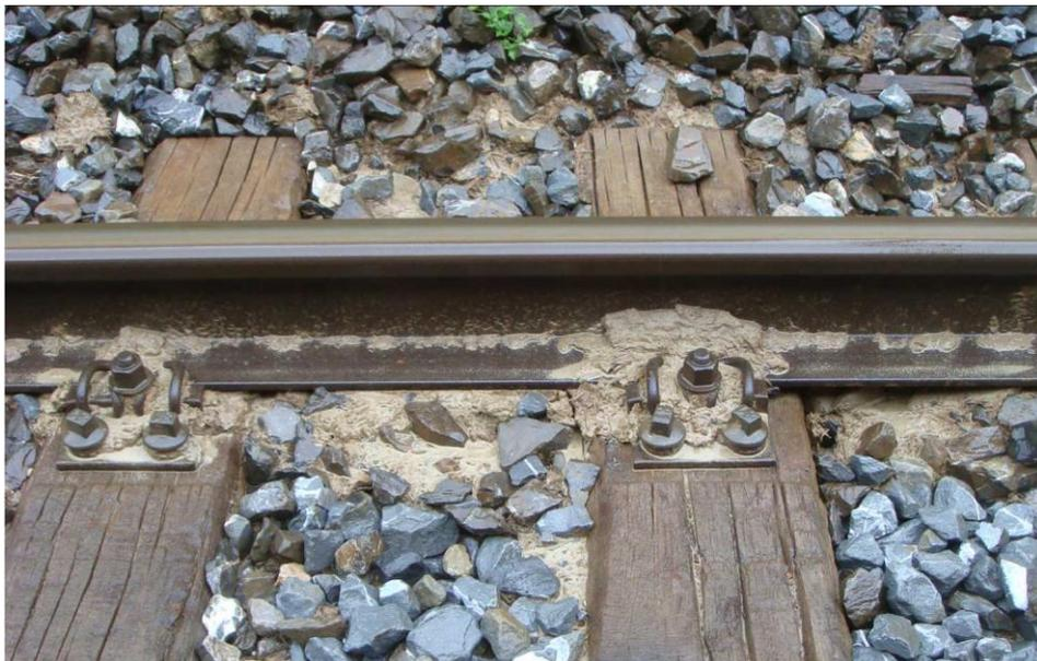
Abb. 3: Suspension mit Feinteilen aus dem Unterboden (Niklaus, SBB)
