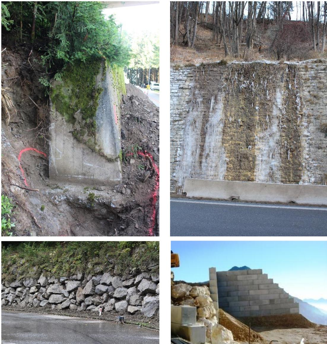
Abb. 2: Arten von Gewichtskonstruktionen; Links oben: Gewichtskonstruktion aus Massenbeton; Rechts oben: Gewichtskonstruktion mit Vorsatzschale; Links unten: Steinstützkörper; Rechts unten: Betonfertigteile für Gewichtskonstruktionen (Rohrdorfer)
