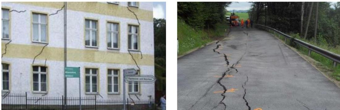
Abb. 11: Schadensbilder; Links: Risse an einem Bauwerk (Meichsner, 2015); Rechts: Risse in einem Fahrbahnbelag (Steinbacher, 2014)
