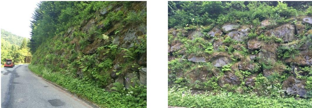
Abb. 20: Links: Steinschichtung mittlere Höhe, unmittelbar neben der Straße; Rechts: Detailaufnahme Bewuchs der Steinschichtung
