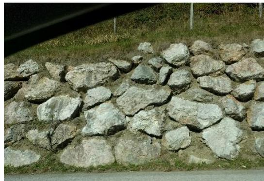
Abb. 19: Links: Steinschlichtung, geringe Höhe; Rechts: Detail Steinschlichtung
