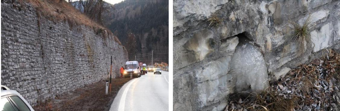
Abb. 22: Links Gewichtskonstruktion mit Vorsatzschale; Rechts: Detailbild der Entwässerung im Fußpunkt
