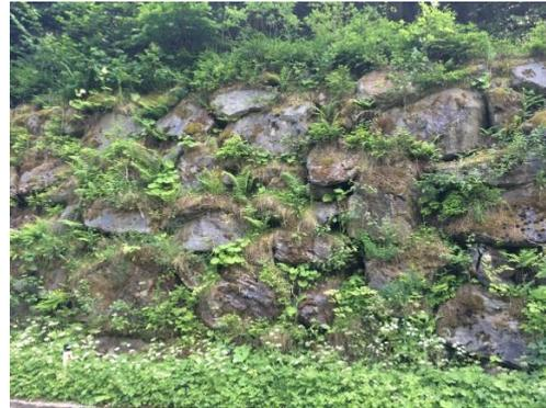
Abb. 21: Links: Steinschichtung mittlere Höhe, unmittelbar neben der Straße; Rechts: Detailaufnahme Bewuchs der Steinschichtung
