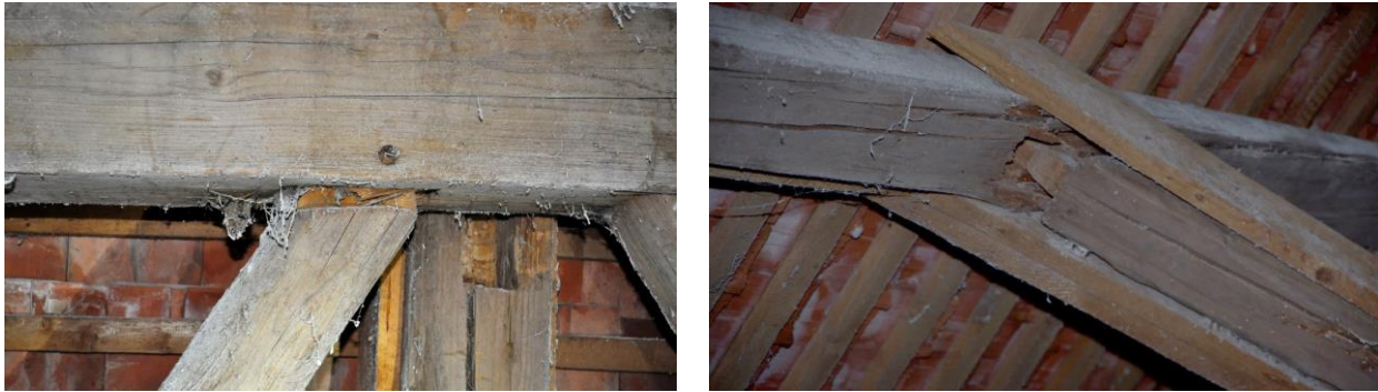
Abbildung 3.51 links: klaffendes Kopfband, rechts: nicht fachmäßig instandgesetzte Verbindung
