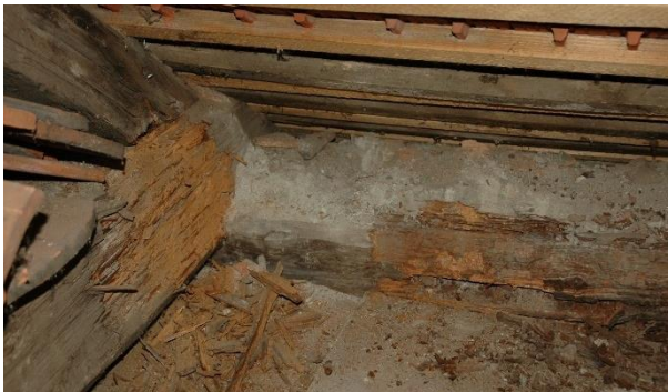
Abbildung 3.11 Infolge von Pilzbefall geschädigte Mauerbank und Sparrenfußpunkte
