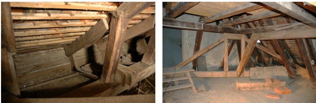
Abbildung 3.23 Tragwerk im Bereich der Walmdachfläche zur Herrengasse.
