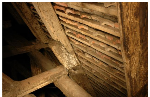
Abbildung 3.39 Geschädigte Sparren, Rechts: Sparrenstoß mit liegendem Blatt (keine Tragfähigkeit für Biegemomente).
