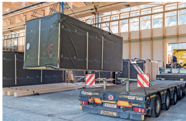
Abbildung 4.7 links: Zwischenlager [36], rechts: Verladen der Raumzellen [34]
