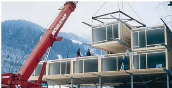
Abbildung 4.10 Montage Raumzelle, Hebekonstruktion [31]
