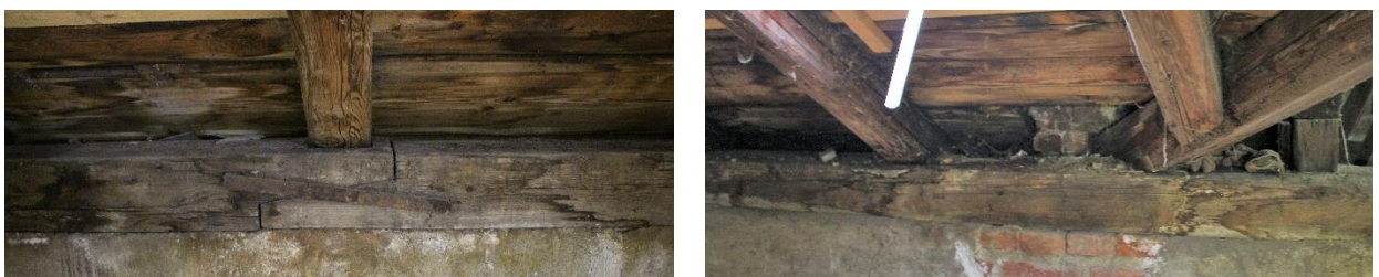
Abbildung 3.54 links: saubere Fußpfette, rechts: verschmutzte Fußpfette
