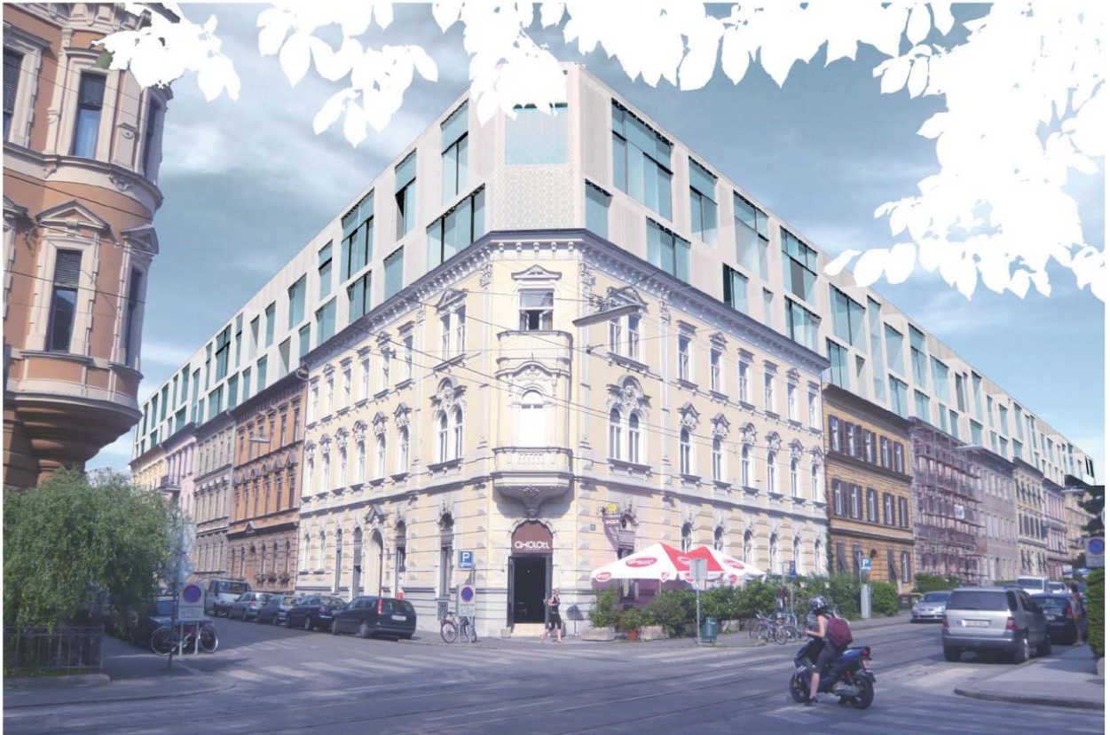
Abbildung 4.31 Aufstockung Ecke Schillerstrasse/Nibelungengasse [45]
