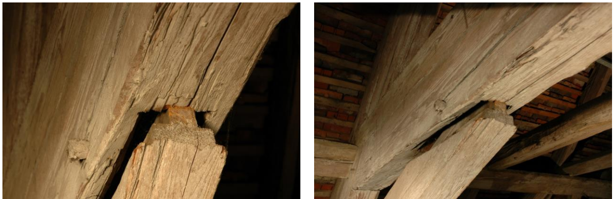
Abbildung 3.34 Klaffende Kopfbandverbindungen
