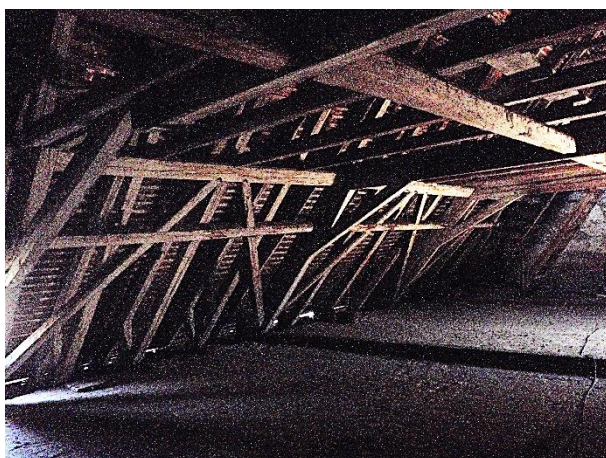
Abbildung 3.60 links: Kehlbalkendach mit liegenden Stuhl, rechts: Kehlbalkendach mit stehenden Stuhl
