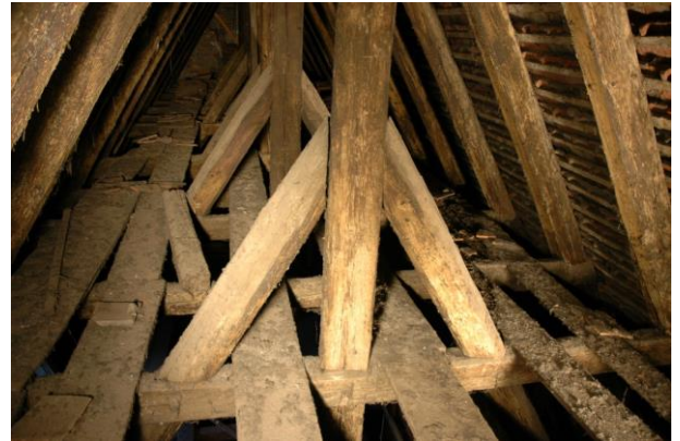
Abbildung 3.37 links: die Mauerbank ist infolge von Innenfäule zerstört (siehe Eindringtiefe des Lattenhammers). rechts: Verschmutzung des Tragwerks
