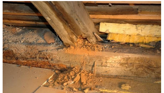
Abbildung 3.11 Infolge von Pilzbefall geschädigte Mauerbank und Sparrenfußpunkte
