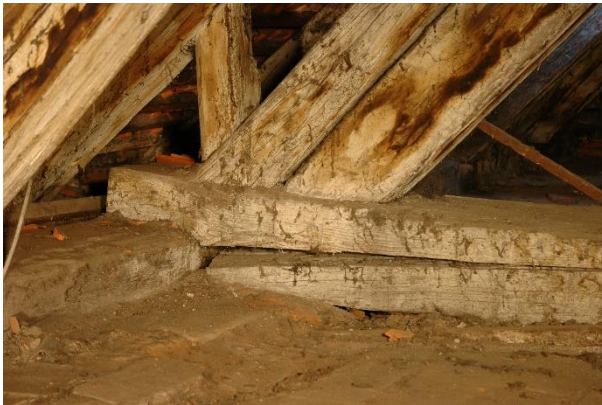
Abbildung 3.43 Quersugversagen des Bundtrams, rechts: Abstützung auf Dippelbaumdecke
