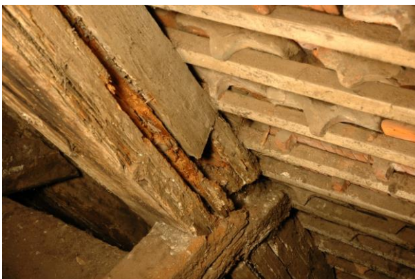
Abbildung 3.39 Geschädigte Sparren, Rechts: Sparrenstoß mit liegendem Blatt (keine Tragfähigkeit für Biegemomente).
