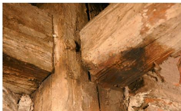
Abbildung 3.7 links: klaffende Verbindung an Stuhlwand; rechts: gekappte Streben
