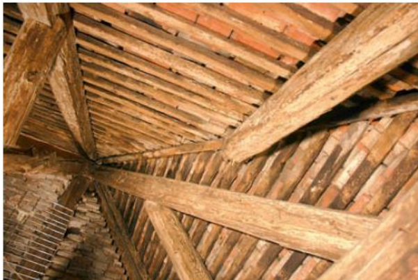
Abbildung 3.6 links: fehlender Gratsparren; rechts: eingemauerte Hölzer der Stuhlwand
