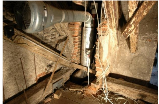
Abbildung 3.30 links: Schwächung des Bundtrams, rechts: eingebaute Haustechnikanlage
