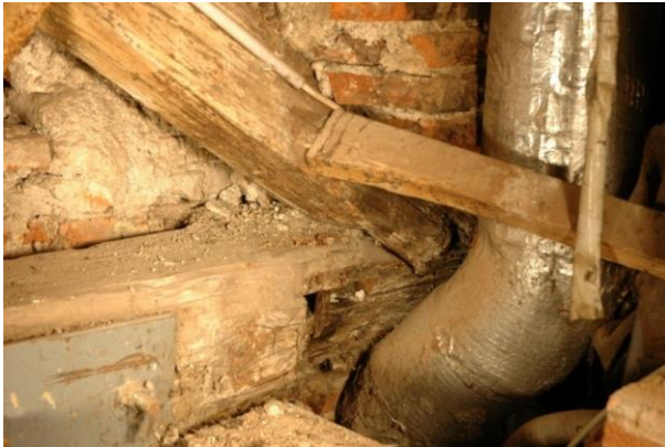
Abbildung 3.30 links: Schwächung des Bundtrams, rechts: eingebaute Haustechnikanlage
