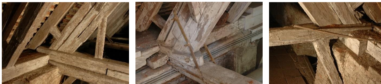
Abbildung 3.19 verschiedene Stuhlsäulen- und Sparrenfußpunkte.
