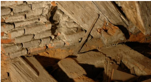
Abbildung 3.31 links: geschädigter Stuhlsäulen-Fußschwelle-Bundtram-Knoten, rechts: geschädigter Aufschiebling
