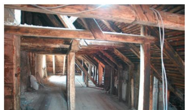
Abbildung 3.7 links: klaffende Verbindung an Stuhlwand; rechts: gekappte Streben
