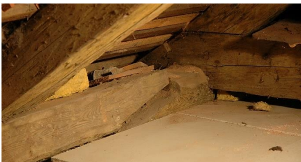
Abbildung 3.12 links: klaffende Mauerbankverbindung, rechts: klaffende Sparren-Mauerbank-Verbindungen
