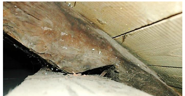
Abbildung 3.12 links: klaffende Mauerbankverbindung, rechts: klaffende Sparren-Mauerbank-Verbindungen
