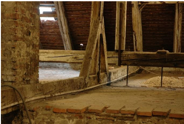
Abbildung 3.44 links: Verformung eines Bundtrams, rechts: Verzerrung der Stuhlwand.
