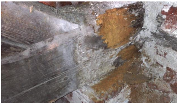
Abbildung 3.56 links: Im Zuge der Bauarbeiten gefundener schadhafter Bundtramkopf; Osttrakt, [28] rechts: abgeklungener Nagekäferbefall; Südtrakt
