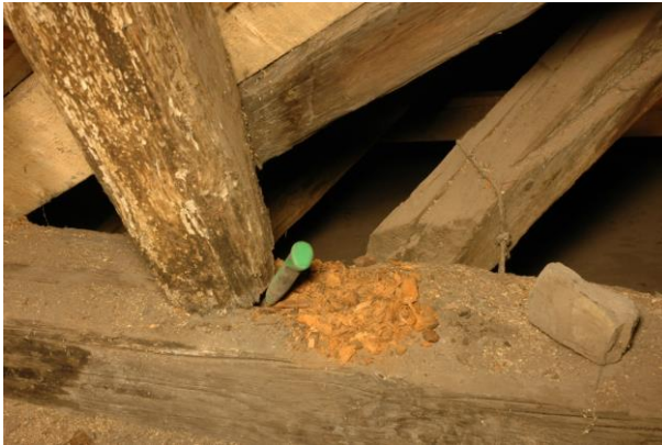
Abbildung 3.37 links: die Mauerbank ist infolge von Innenfäule zerstört (siehe Eindringtiefe des Lattenhammers). rechts: Verschmutzung des Tragwerks
