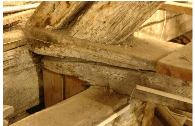
Abbildung 3.43 Quersugversagen des Bundtrams, rechts: Abstützung auf Dippelbaumdecke
