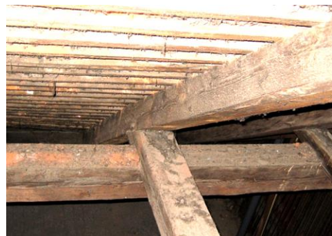
Abbildung 3.59 links: Mittelpfette in Stuhlwand zwischen Stuhl 3 und 5, Blick Richtung Nordost. rechts: Verformung des Sparren 12' (Blick vom First nach unten). [29]
