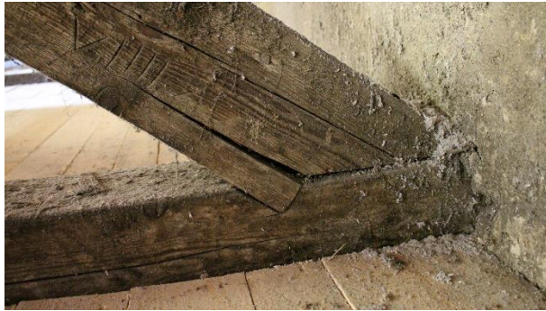
Abbildung 3.55 Querzugrisse an Fersenversätzen
