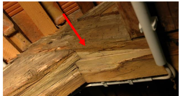
Abbildung 3.10 links: Große Verformungen an ehemaliger Kamindurchdringung, rechts: auf Rollschub versagte Verbindung
