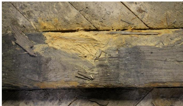
Abbildung 3.56 links: Im Zuge der Bauarbeiten gefundener schadhafter Bundtramkopf; Osttrakt, [28] rechts: abgeklungener Nagekäferbefall; Südtrakt
