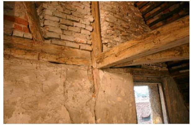
Abbildung 3.6 links: fehlender Gratsparren; rechts: eingemauerte Hölzer der Stuhlwand
