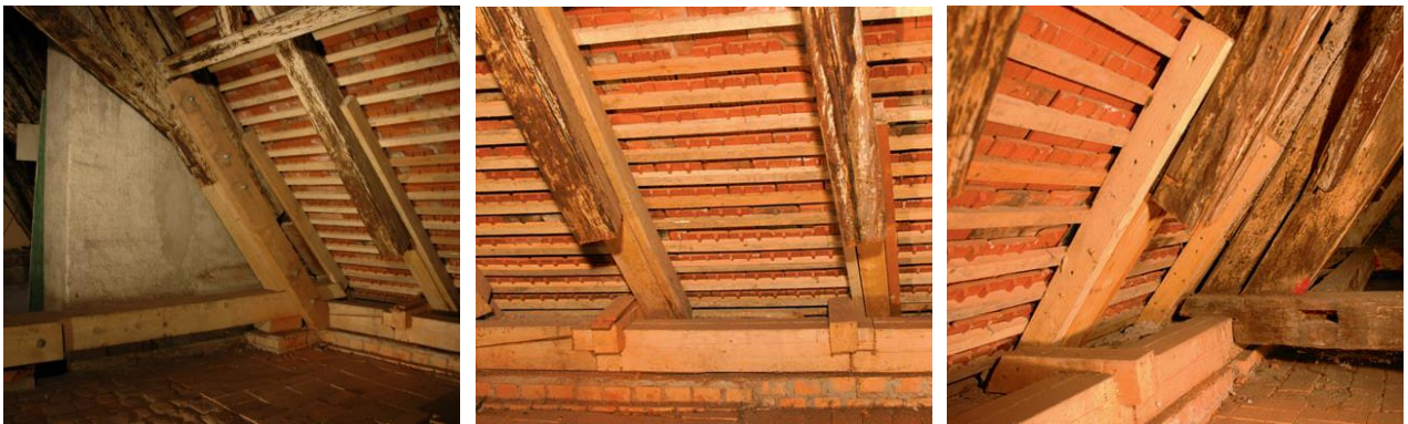
Abbildung 3.27 Instandsetzungen links: Hauptgespärre 4, mitte/rechts: Leergespärre 3.1 und 3.2
