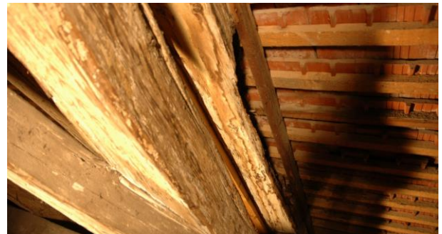
Abbildung 3.31 links: geschädigter Stuhlsäulen-Fußschwelle-Bundtram-Knoten, rechts: geschädigter Aufschiebling
