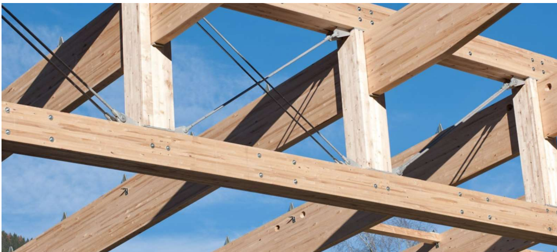
Abbildung 2-6: Darstellung des Birken-Fachwerks der NORITEC-Halle; aus [23]
