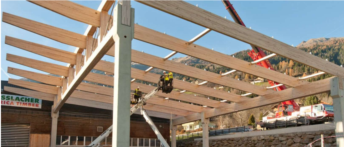
Abbildung 2-5: Montage der Industriehalle aus Birken-Brettschichtholz; aus [23]
