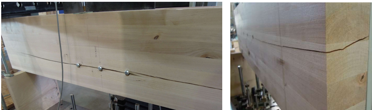
Abbildung 3-31: Durchriss bei einem Prüfkörper mit drei Stabdübel, links: Riss über die gesamte Länge, rechts: Rissverlauf im Querschnitt
