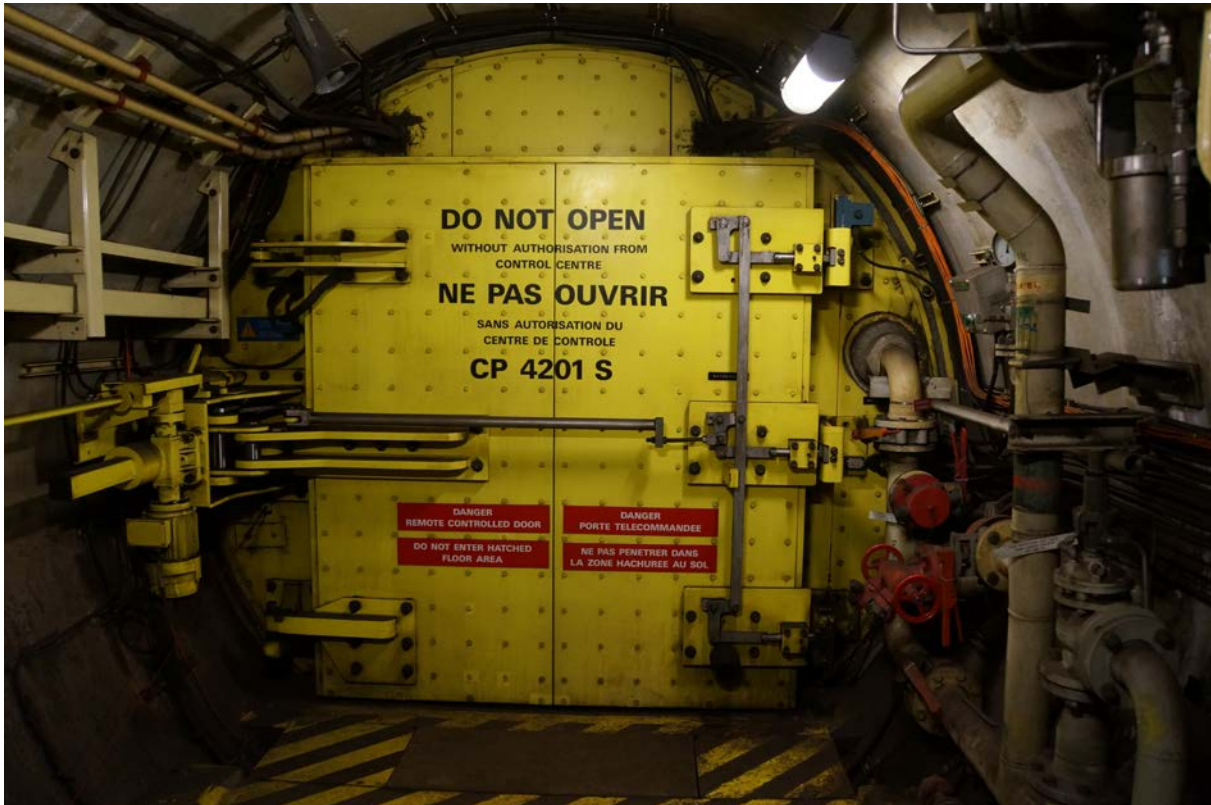
Abb. 35: Eurotunnel – Querschlagtüre
