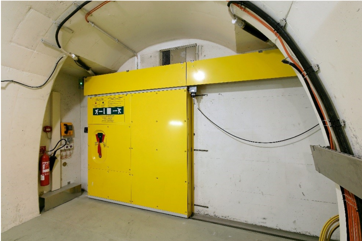
Abb. 28: Lötschberg-Basistunnel (CH) – Querschlagtor, Querschlag innen
