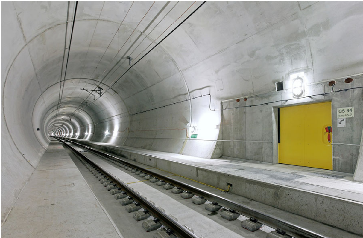
Abb. 27: Lötschberg-Basistunnel (CH) – Querschlagtor, Fahrtunnel
