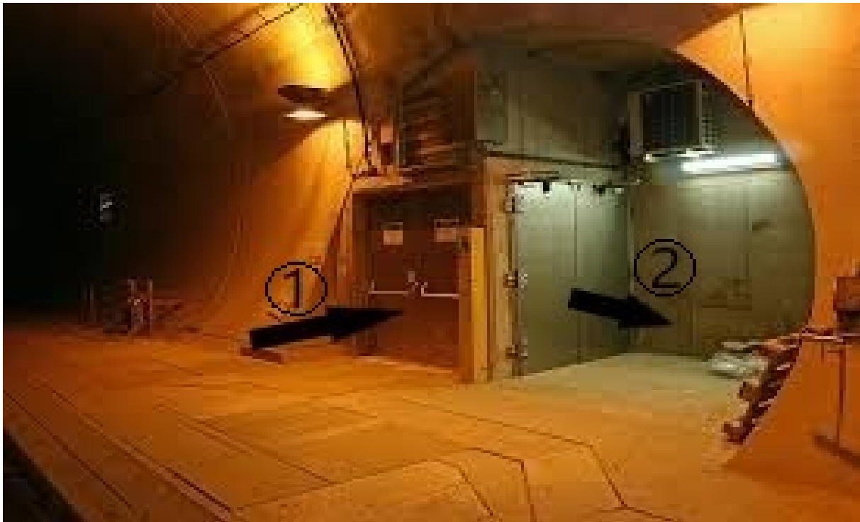
Abb. 23: Wienerwaldtunnel (A) – Querschlagtüren
