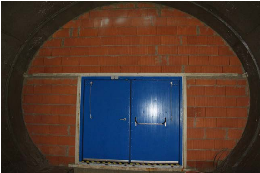
Abb. 64: Querschlagabschluss mit Pendeltür (Nordröhre)
