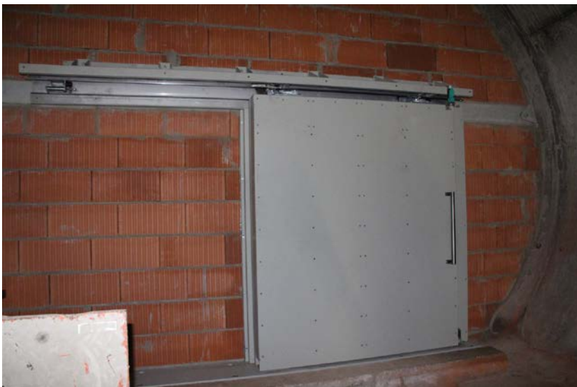
Abb. 65: Querschlagabschluss mit Schiebetür (Südröhre)
