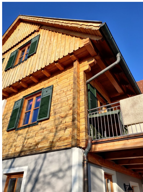
Abbildung 4.6: Südwestseite des Hauses
