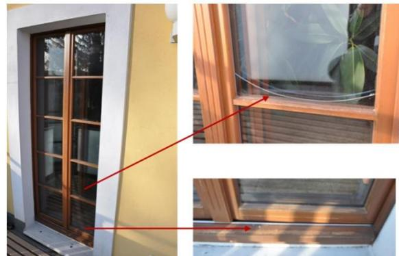
Abbildung 4: Kastenfenstertür Südseite ohne Verschattung, Riss in der äußeren Scheibe der außenliegenden WSV, Farbablagerungen der Dickbeschichtung [Conrad]
