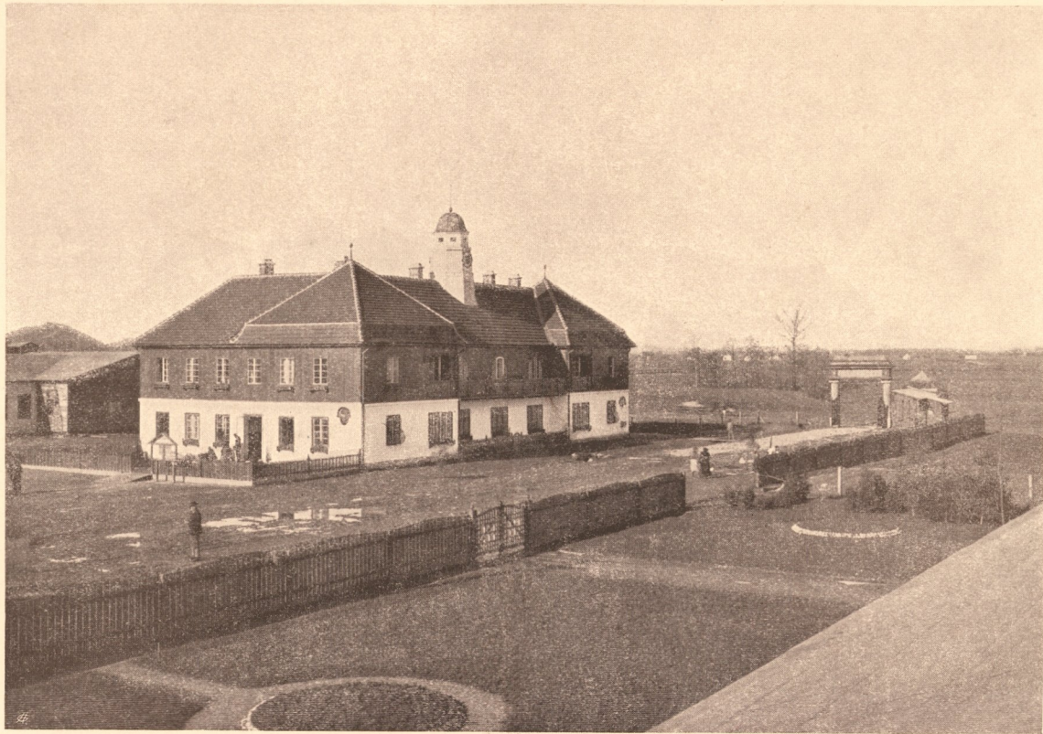
5. Gebäude der Barackenverwaltung.
