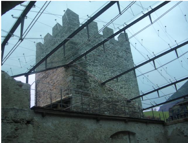
Abbildung 7: Dachkonstruktion Schloss Juval [E4]
