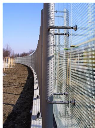
Abbildung 41: Herkömmliche Glas-Metall Schallschutzwand mit Punkthaltersystem [E5]
