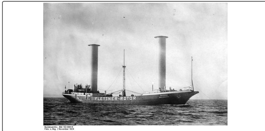
Abbildung 12: „Kiel. Das neue Windkraftschiff.“ Das von dem bekannten Ingenieur Anton Flettner erfundene Windkraftschiff, welches eine ungeheure Brennstoff-Ersparnis ermöglicht, bei einer Probefahrt in der Ostsee.
