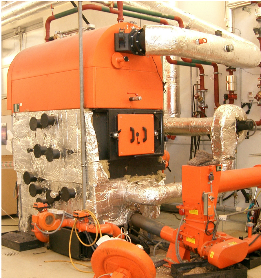
Abbildung 2.2 – Untersuchte Flachschubrost-Feuerungsanlage
