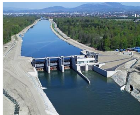
Abbildung 2-23: Das KW Gössendorf aus der Richtung Unterwasser [21]
