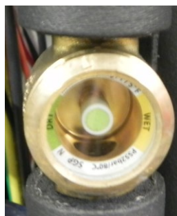
Abbildung 2-21: Schauglas mit Feuchtigkeitsindikator
