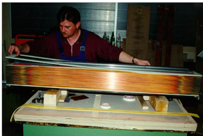
Abbildung 11: Montage des wellenseitigen, einteiligen Isolierrahmens (Andritz)
