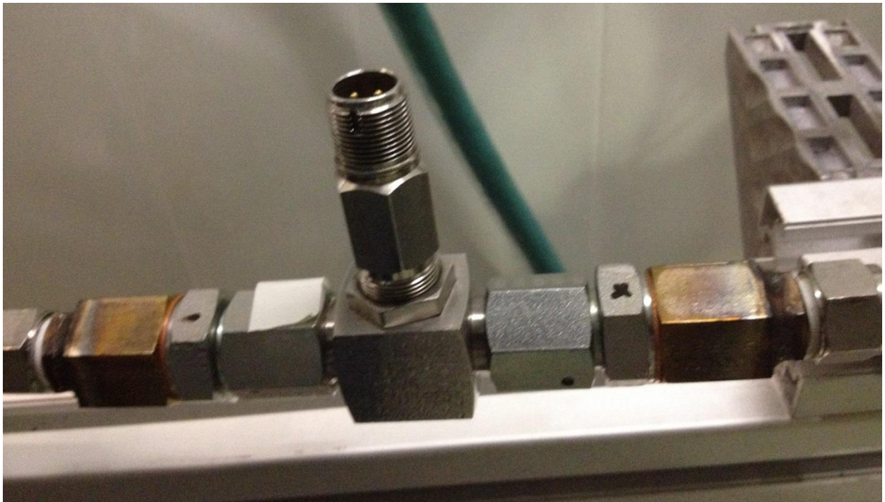
Abbildung 4-42 - Durchfluss - Messturbine FT4-8 vor dem EXV1
