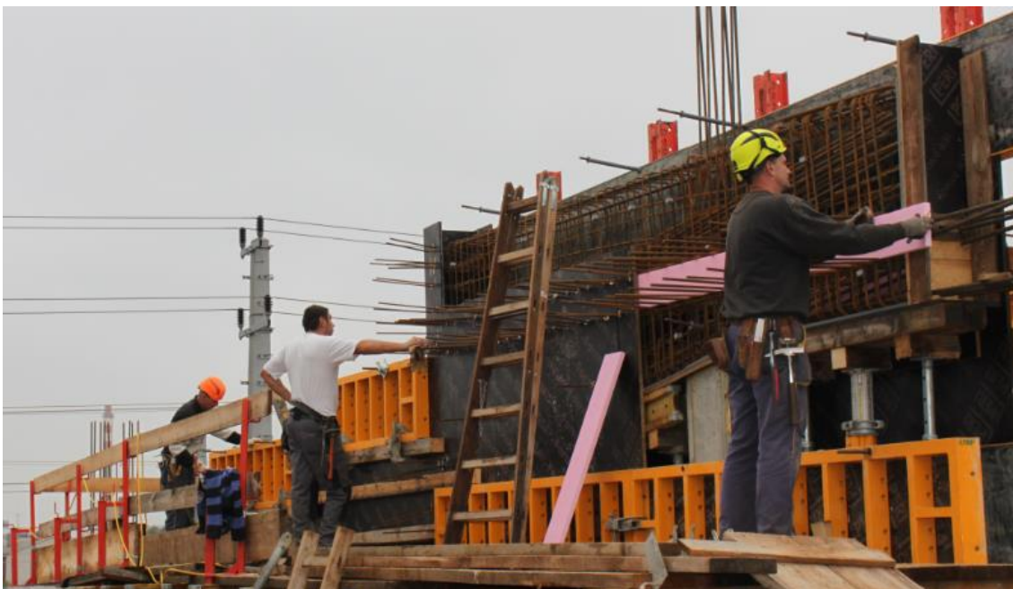
Abbildung 5-27: Schließen der Schalung beim Rampenträger
