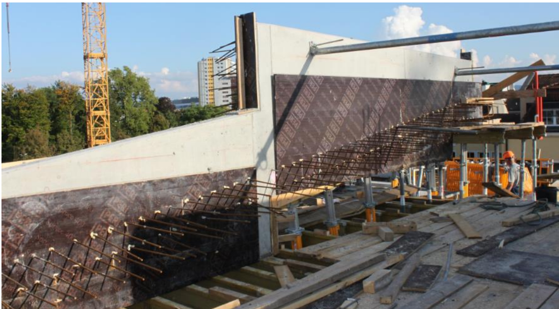
Abbildung 5-31: Ausschalen des Rampenträgers
