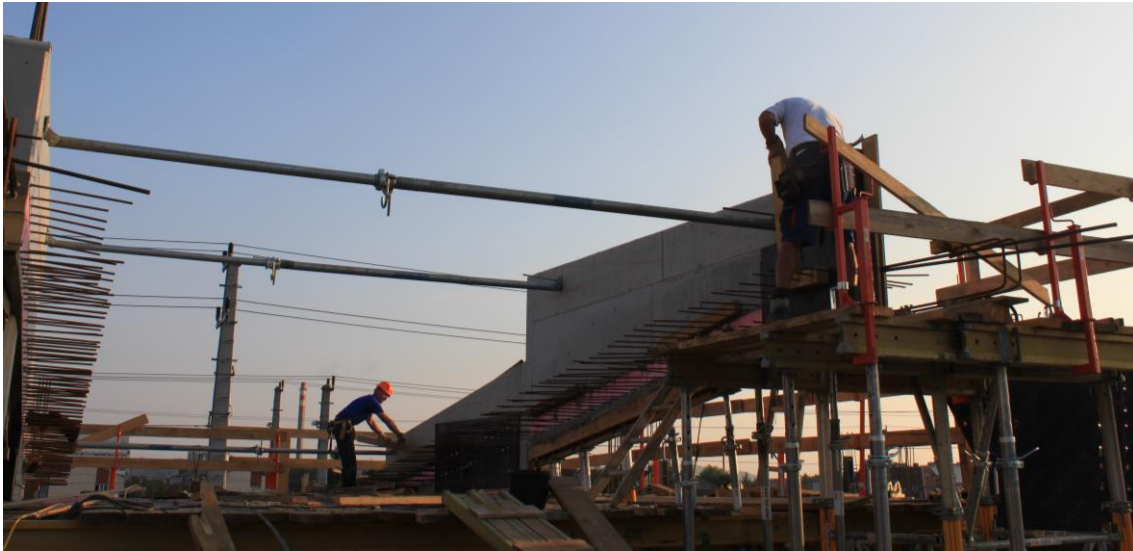
Abbildung 5-8: Befestigung von horizontalen Abspreizungen beim freitragenden Rampenträger
