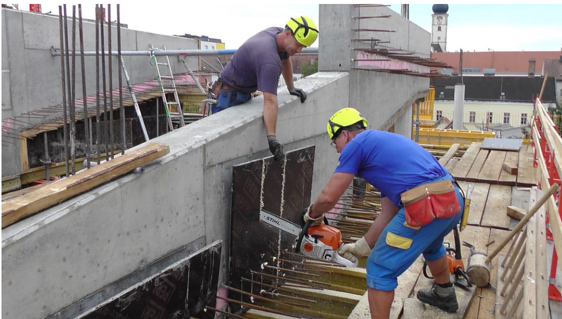
Abbildung 3-13: MZ - Zuschneiden von Schaltafeln, die sich beim Ausschalen verklemmt haben
