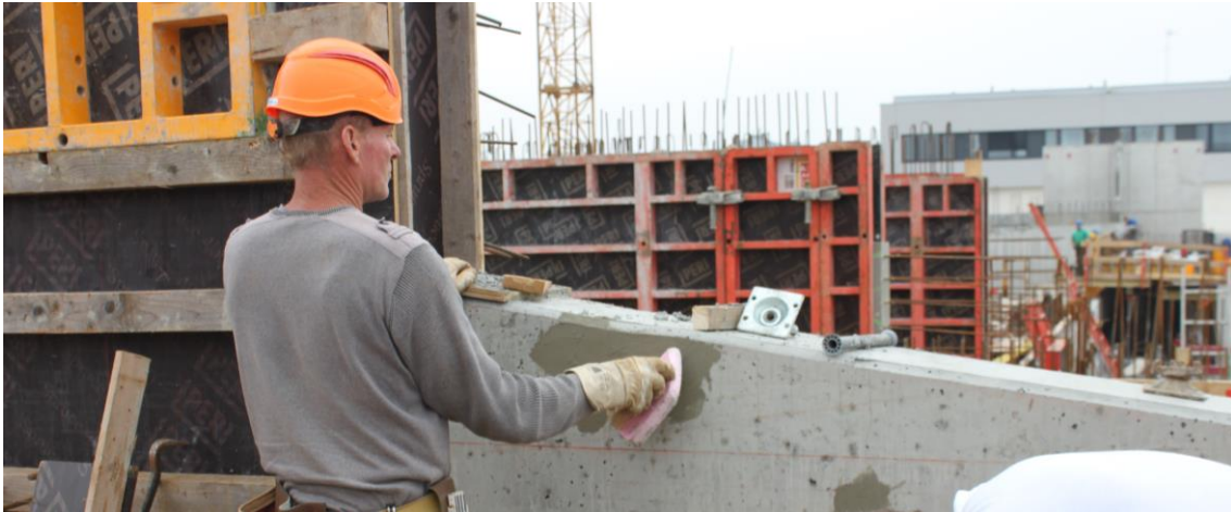
Abbildung 3-12: MZ - Ausbessern von Fehlstellen in der Betonoberfläche
