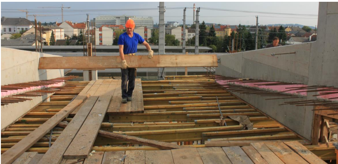
Abbildung 5-47: Abbau der Arbeitsbühne (09.09.2014)
