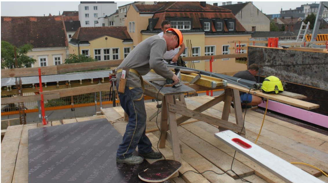
Abbildung 5-4: Herstellung der unteren Schalung des auf Stützen gelagerten Rampenträgers während die anderen AK Tätigkeiten beim freitragenden Rampenträger durchführen
