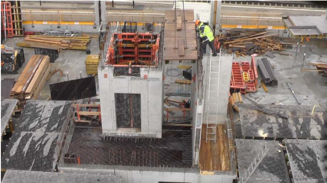
Abbildung 6-10: Einheben der Arbeitsbühne mit dem Kran beim Stiegenhaus: Kern mit T-Stück (23.09.2014)
