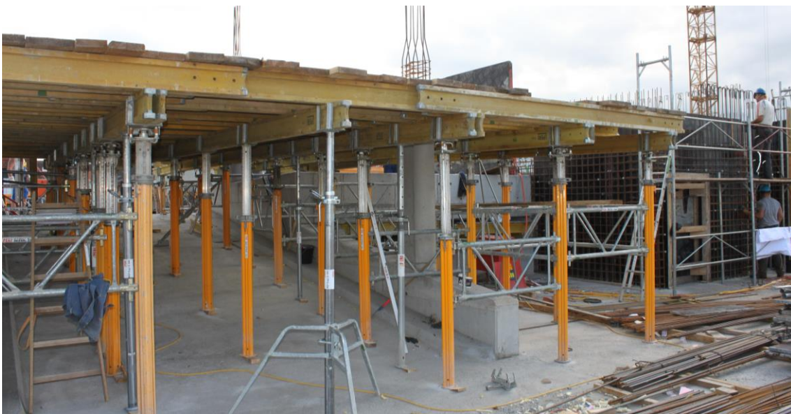
Abbildung 5-3: Arbeitsbühne für das Rampenträgerpaar
