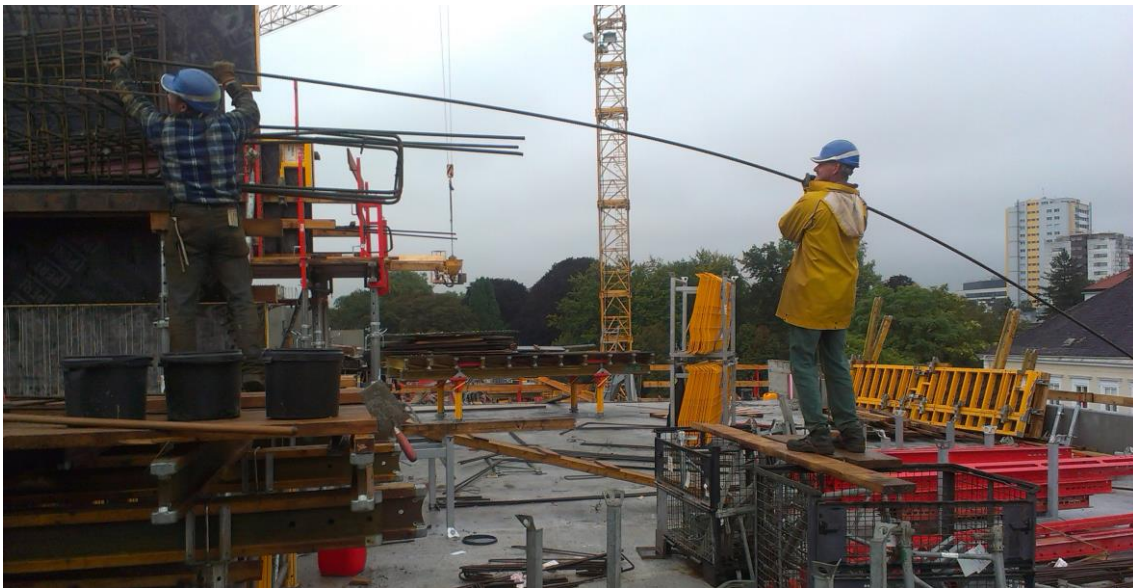
Abbildung 5-21: Einschleiben der Hauptbewehrung und der konstruktiven Längsbewehrung
