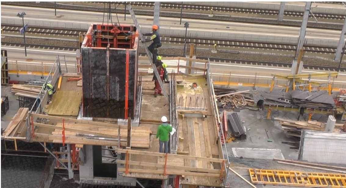
Abbildung 6-12: Einheben der Innenschalung des Kerns mit dem Kran beim Stiegenhaus: Kern mit T-Stück (25.09.2014)
