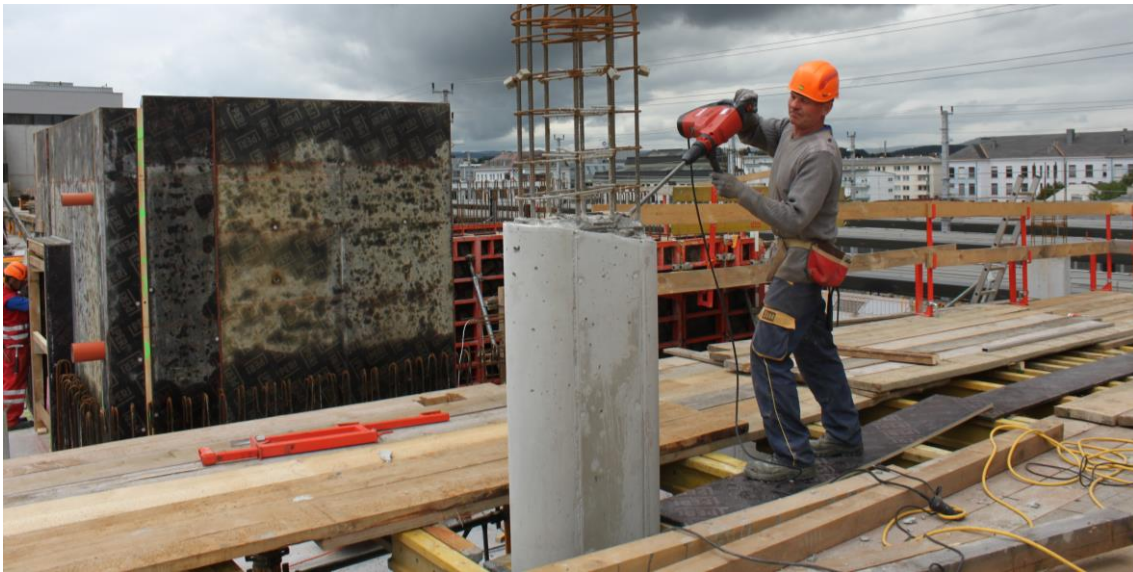
Abbildung 3-17: MX - Abschräumen der Stützenoberkante
