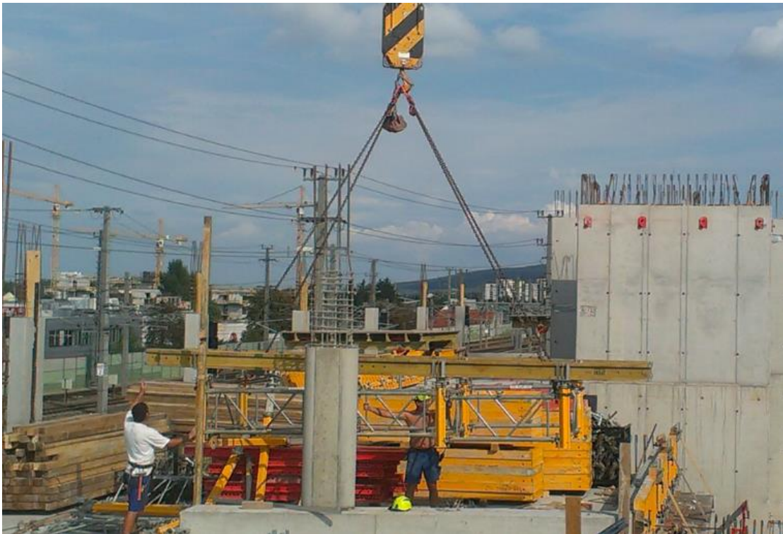
Abbildung 5-33: Versetzen ganzer Stützentürme mit dem Kran
