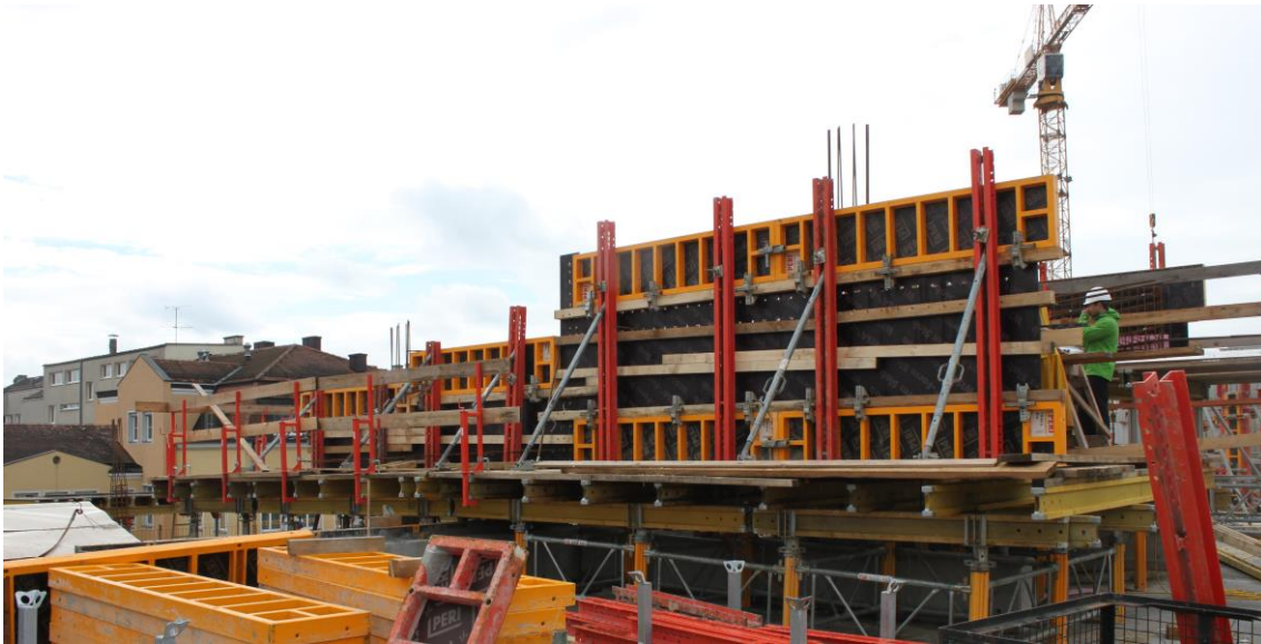
Abbildung 5-16: Abspreizungen auf der Außenseite des Rampenträgers angeordnet
