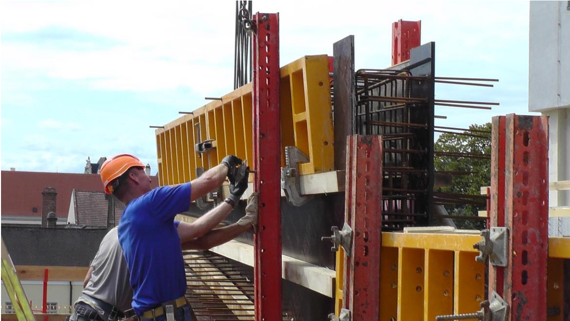
Abbildung 3-7: MH - Anbringen von Stahlriegeln und Befestigung der Anker
