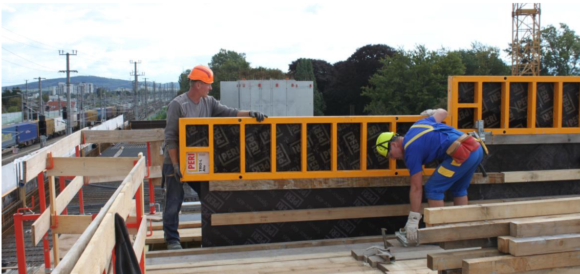
Abbildung 3-4: MH - Einbau der Seitenschalung der ersten Seite des Rampenträgers
