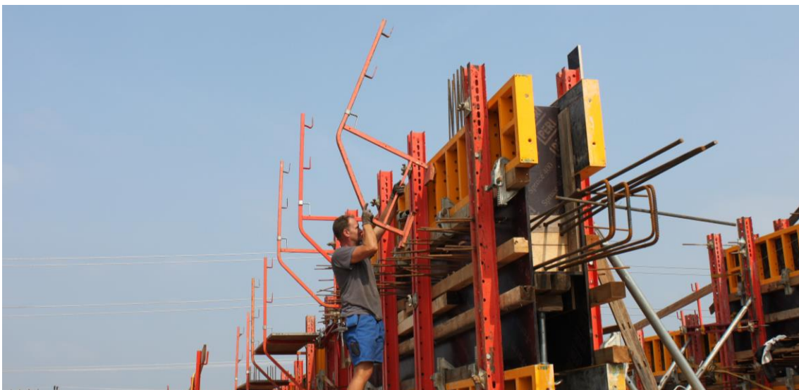
Abbildung 5-6: MN - Aufbau der Arbeitsbühne für die Betonierarbeiten
