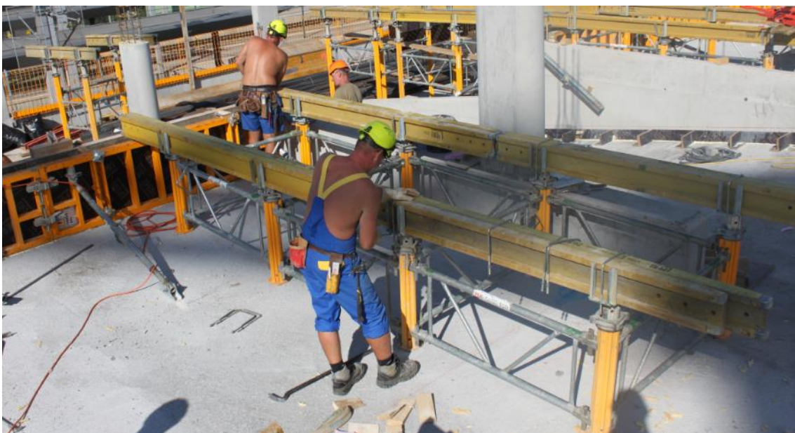
Abbildung 5-12: MN - Aufbau der Arbeitsbühne
