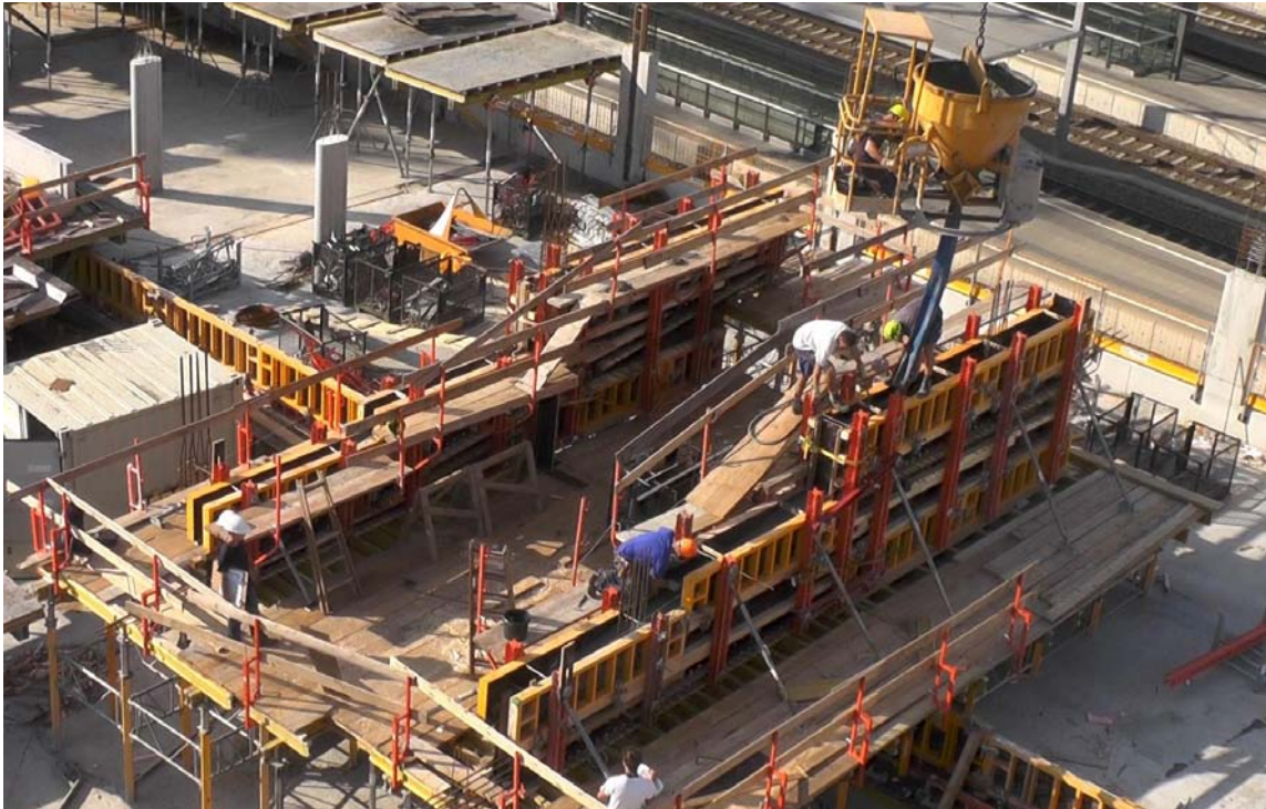
Abbildung 5-127: Betonierarbeiten beim Rampenträgerpaar 2 (16.09.2014)
