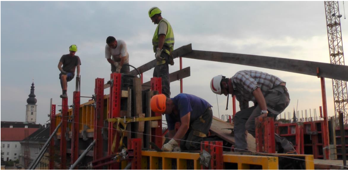
Abbildung 3-15: MA - Warten, weil bei diesem Arbeitsschritt nicht alle AK beschäftigt sind (Arbeitskraft in gelber Warnweste); MA – Warten auf Kran (Arbeitskraft in kurzer blauer Hose)
