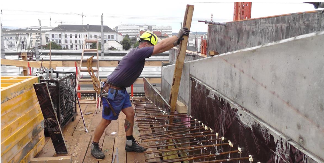
Abbildung 3-8: MH - Ausschalen der durchbohrten Schaltafeln beim Rampenträger
