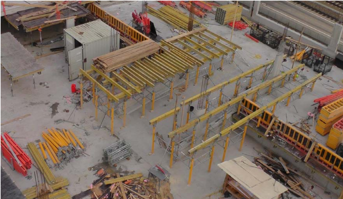
Abbildung 5-120: Aufbau der Arbeitsbühne bei Rampenträgerpaar 2 vom Standpunkt der permanenten Videoaufzeichnungen
