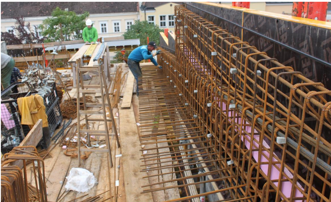
Abbildung 5-22: MN - Befestigung der Abstandshalter beim freitragenden Rampenträger
