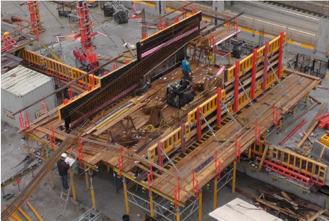
Abbildung 5-124: Bewehrungsarbeiten am Rampenträgerpaar 2 (12.09.2014)
