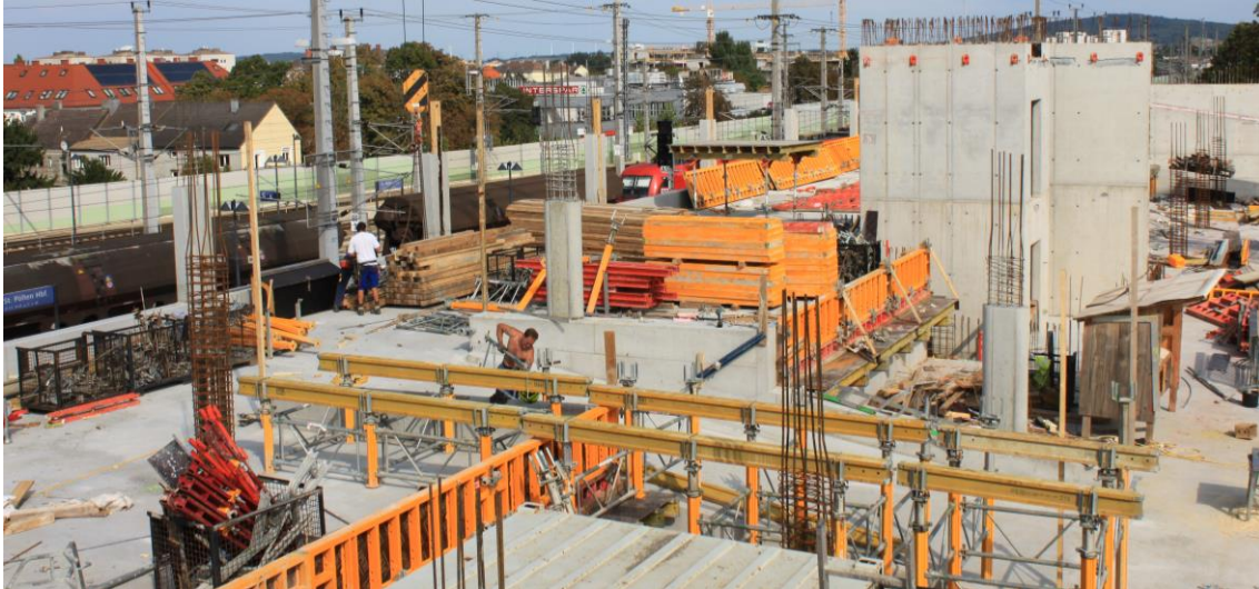
Abbildung 5-121: Aufbau der Arbeitsbühne (09.09.2014)
