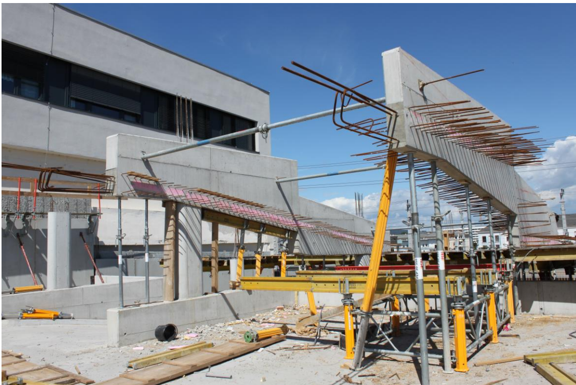
Abbildung 5-1: Ausgeschaltetes Rampenträgerpaar
