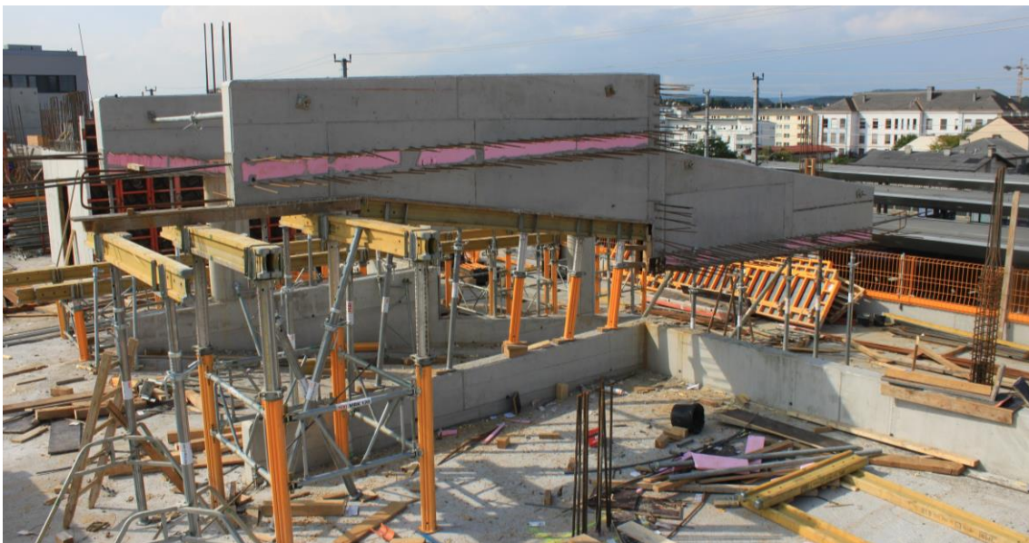
Abbildung 5-9: Unterstellungen der Rampenträger nach dem Abbau der Arbeitsbühne
