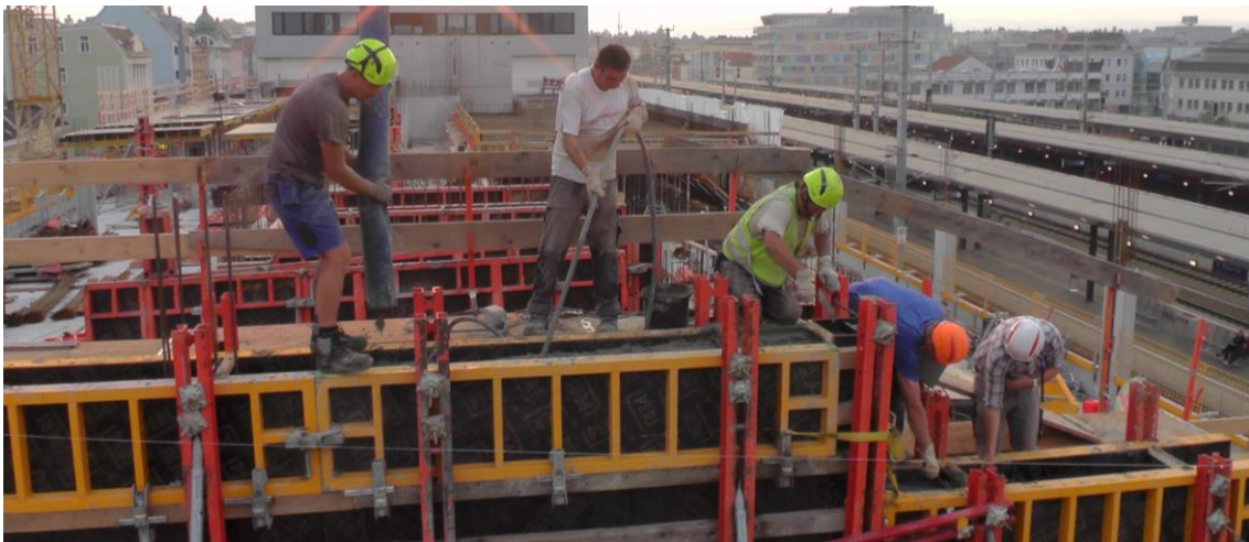
Abbildung 5-45: Betonierarbeiten beim Rampenträger auf Stützen (04.09.2014)
