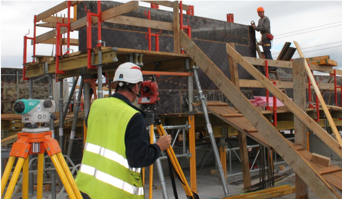
Abbildung 3-10: MN - Einmessen von Höhen und Abständen mittels Nivelliergerät
