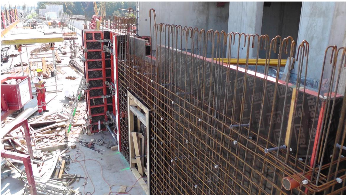
Abbildung 6-17: Umlaufende Wand Nord vor dem Schließen der Schalung
