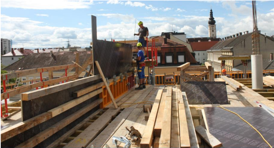
Abbildung 5-14: Herstellung der ersten Seitenschalung auf der Innenseite des Rampenträgerpaares
