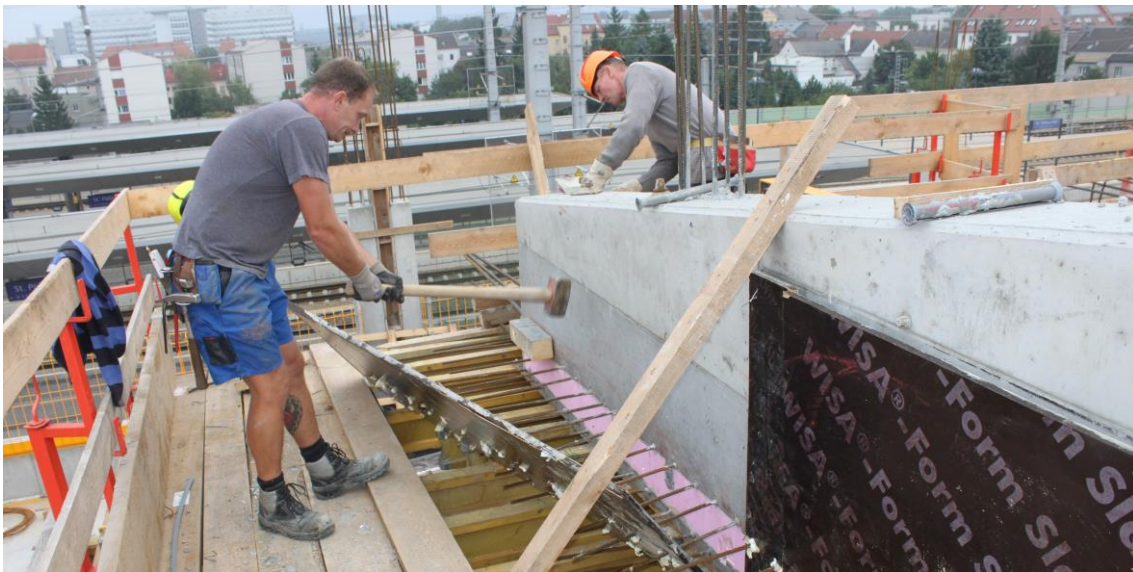
Abbildung 5-46: Ausschalen der durchbohrten Schalttafeln (08.09.2014)
