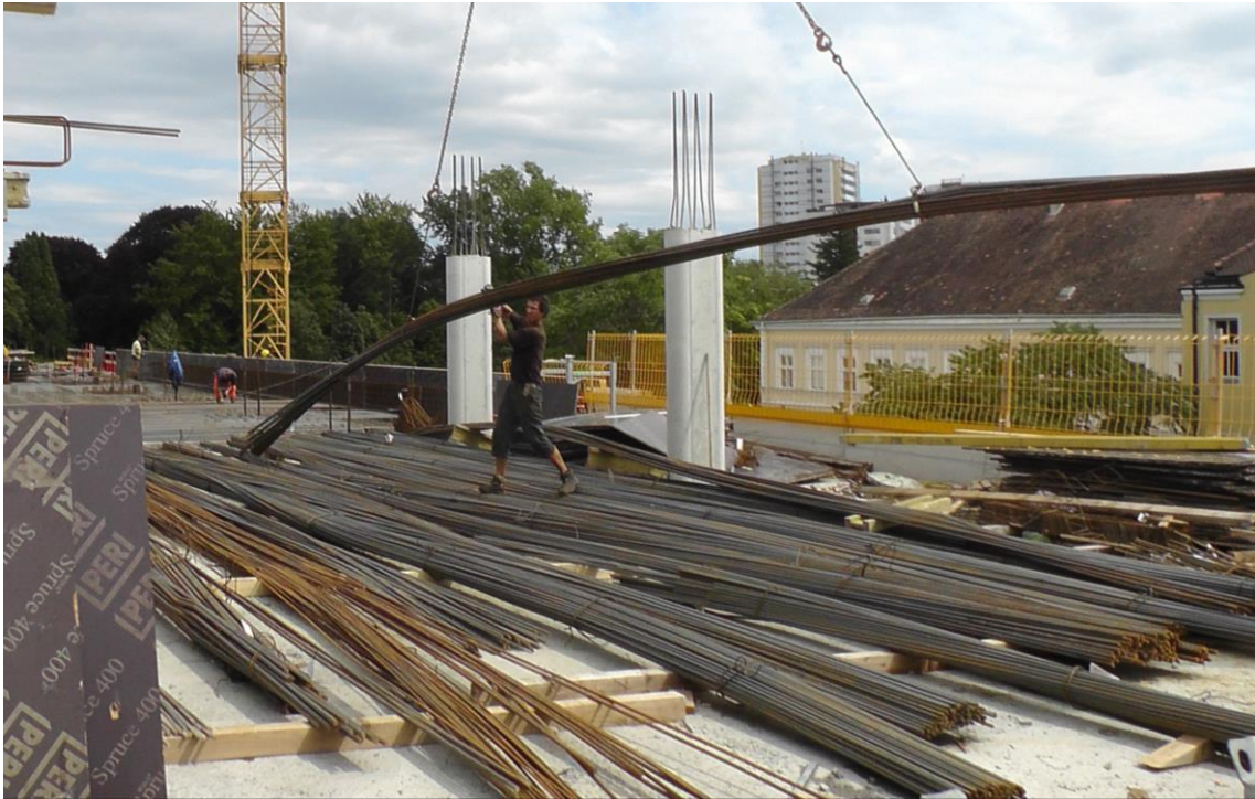
Abbildung 4-11: Antransport und Lagerung der Bewehrung
