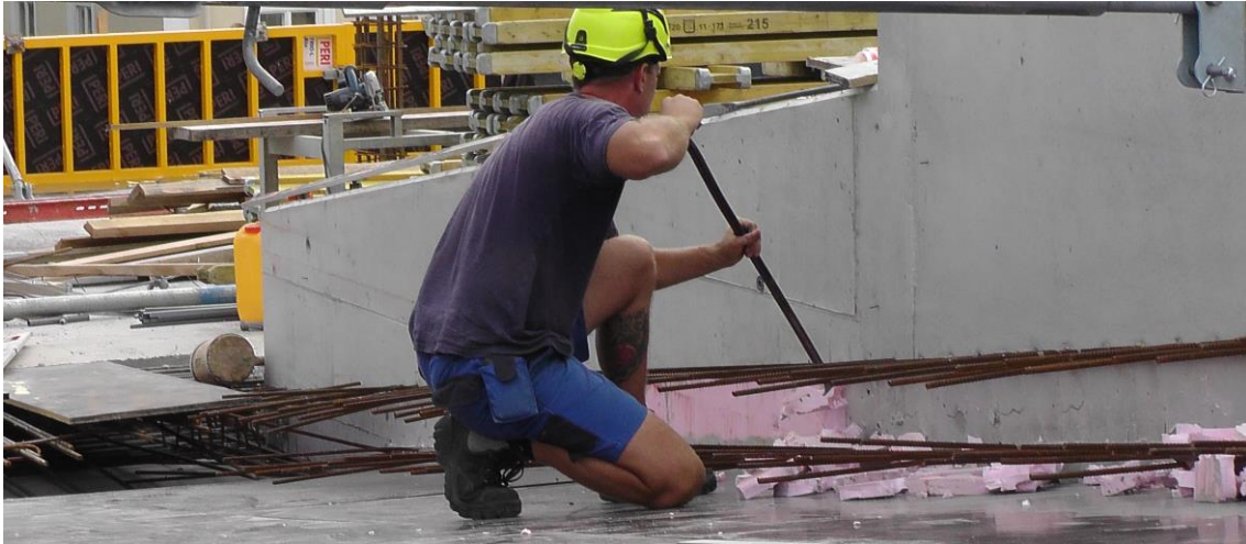
Abbildung 3-9: MH - Entfernung von Aussparungselementen (z.B.: XPS)
