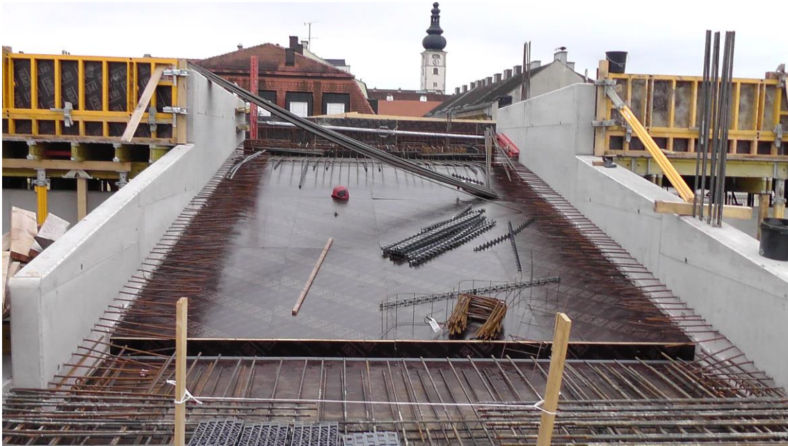
Abbildung 4-15: Geschalte Rampenplatte vor den Bewehrungsarbeiten
