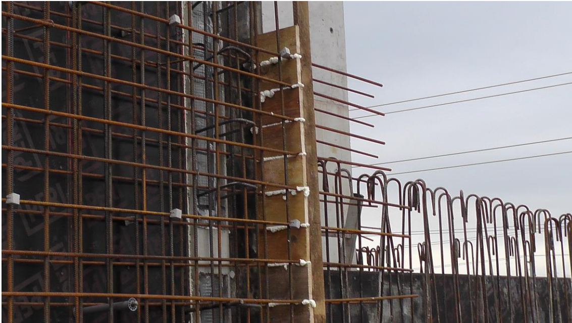
Abbildung 6-8: Stirnflächenabschalung zwischen umlaufender Wand Nord und Süd
