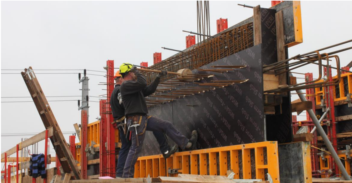
Abbildung 5-5: MH - Schließen der Schalung beim Rampenträger
