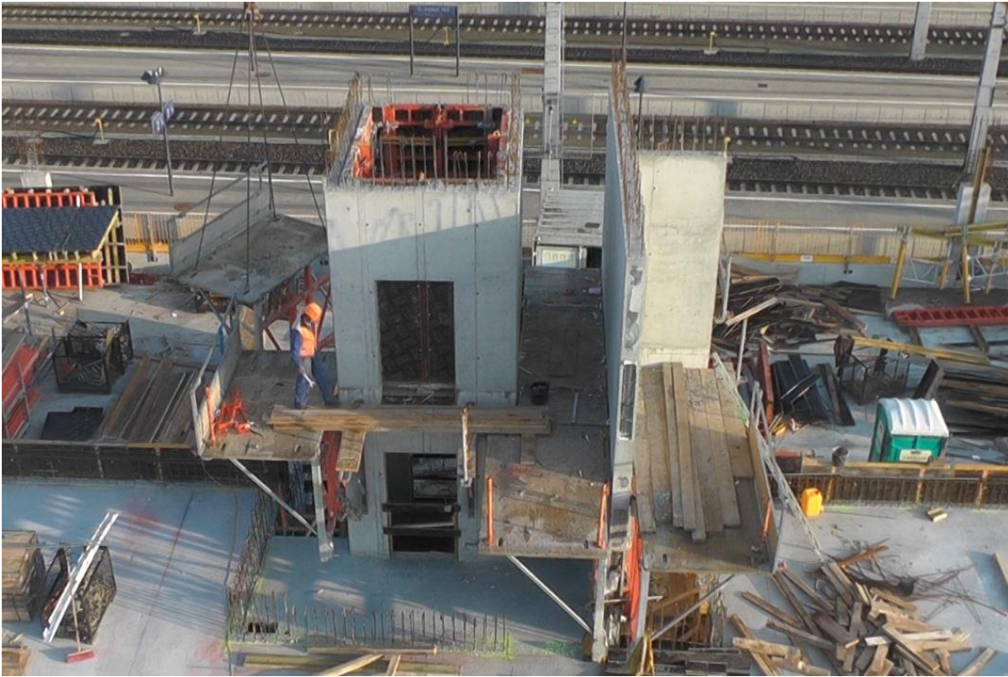
Abbildung 6-16: Abtransport der Faltbühnen der Arbeitsbühne beim Stiegenhaus: Kern mit T-Stück (06.10.2014)
