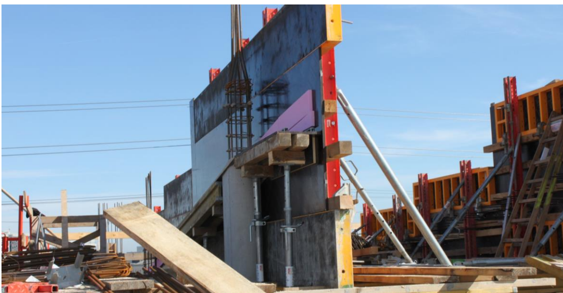
Abbildung 5-15: Abspreizungen auf der Innenseite zwischen den beiden Rampenträgern
