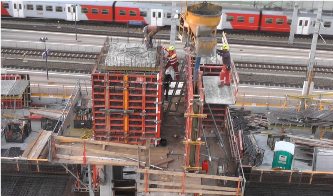
Abbildung 6-15: Betonierarbeiten beim Stiegenhaus: Kern mit T-Stück (29.09.2014)
