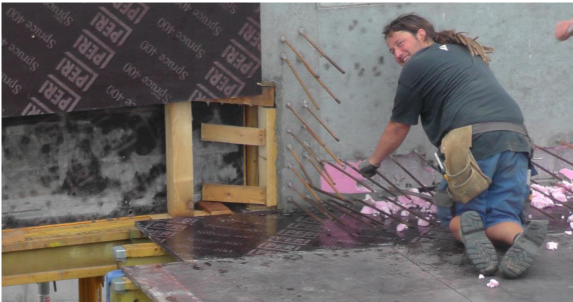
Abbildung 5-129: Entfernung von XPS-Aussparungselementen beim Anschluss der Geschoßdecken
