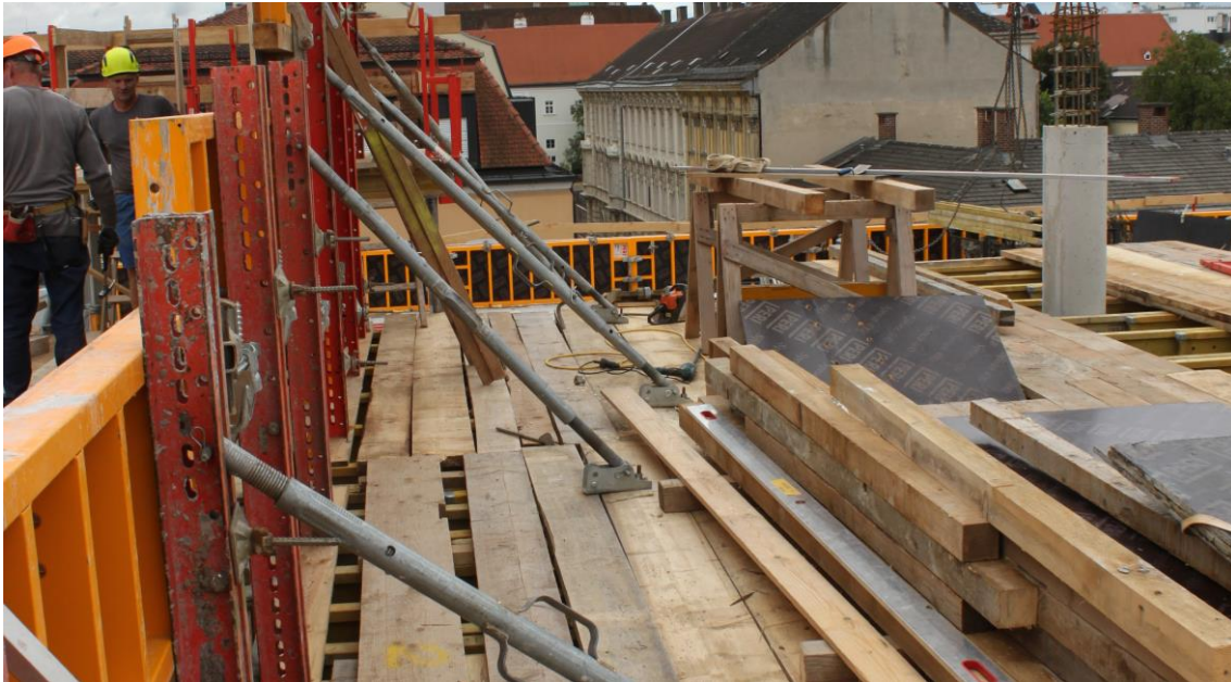
Abbildung 5-40: Anordnung der Abspreizungen der Schalung des freitragenden Rampenträgers auf der Innenseite (27.08.2014)
