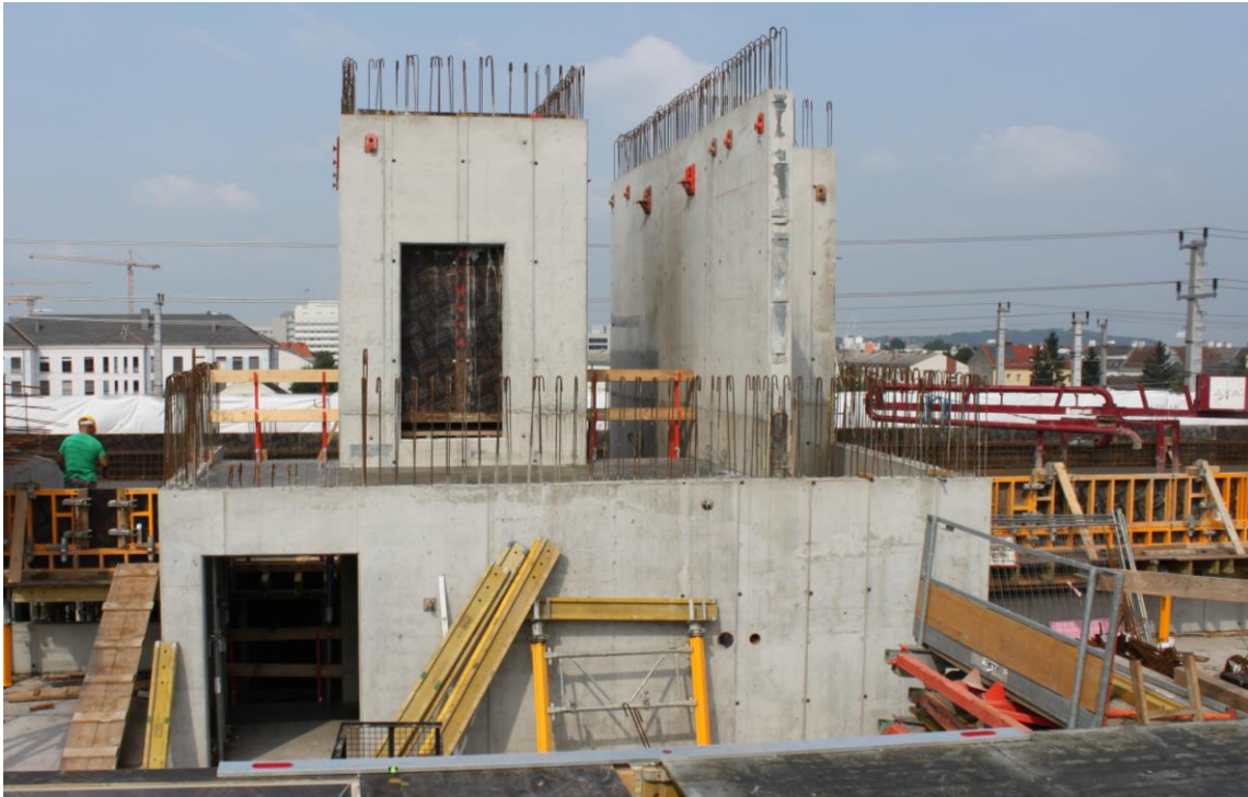
Abbildung 6-19: Stiegenhaus nach der Fertigstellung der drei Bauabschnitte bzw. vor dem Einheben der Arbeitsbühne
