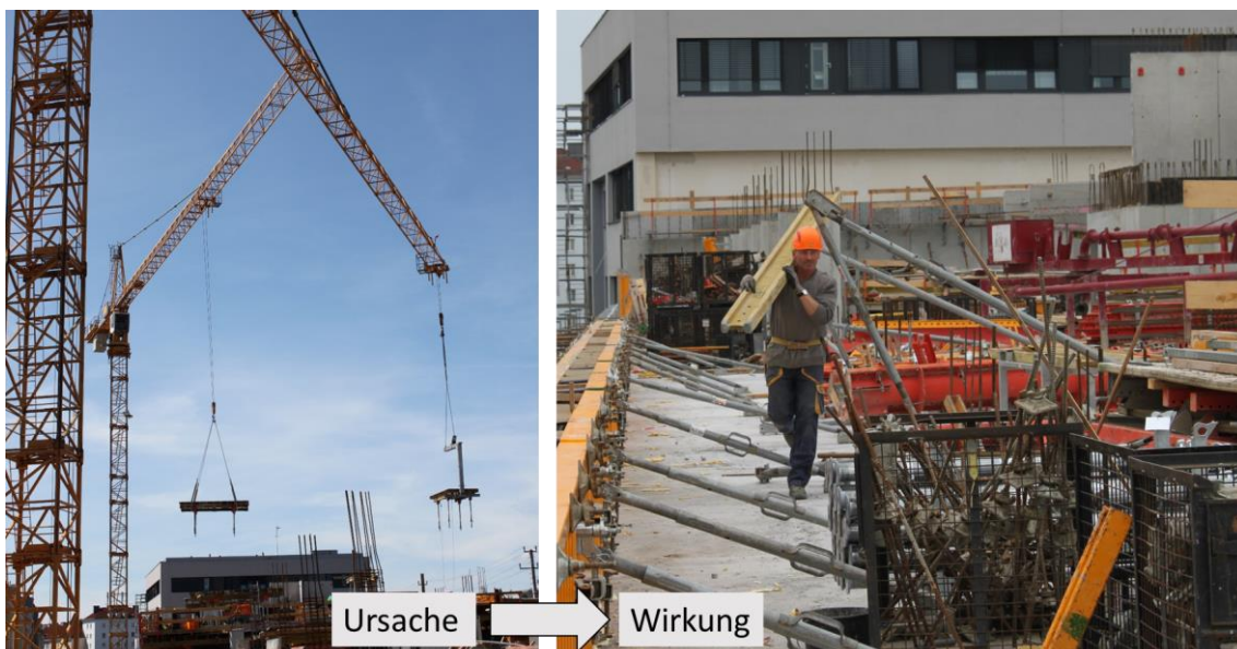
Abbildung 5-38: Aufgrund zu geringer Kranverfügbarkeit - Transport von Schalungsträgern ohne Kran
