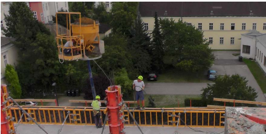
Abbildung 4-14: Betonierarbeiten bei der Brüstung auf der Südseite des Parkdecks
