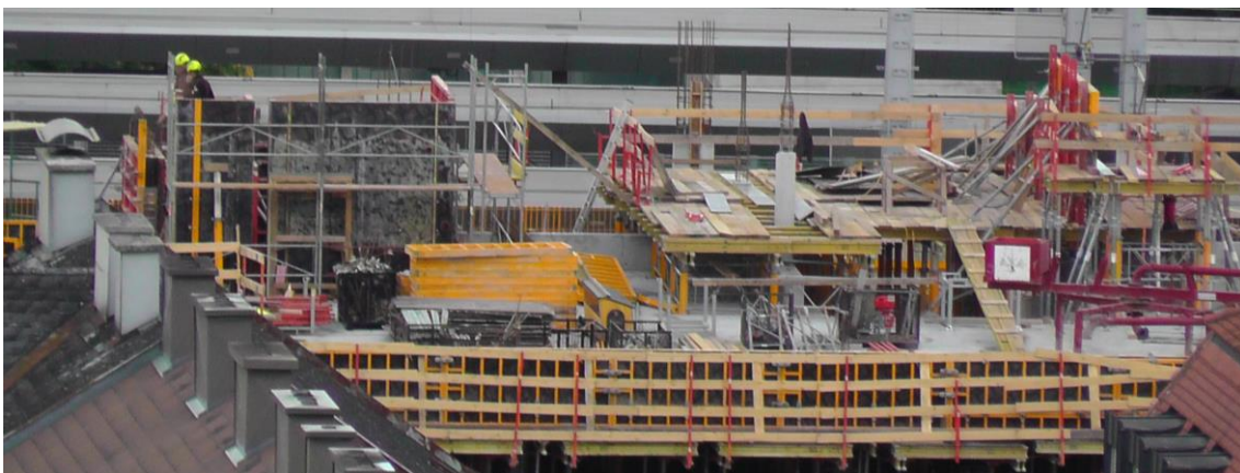
Abbildung 5-37: Stiegenhaus 2 und Rampenträgerpaar 1 vom Standpunkt der permanenten Videoaufzeichnungen
