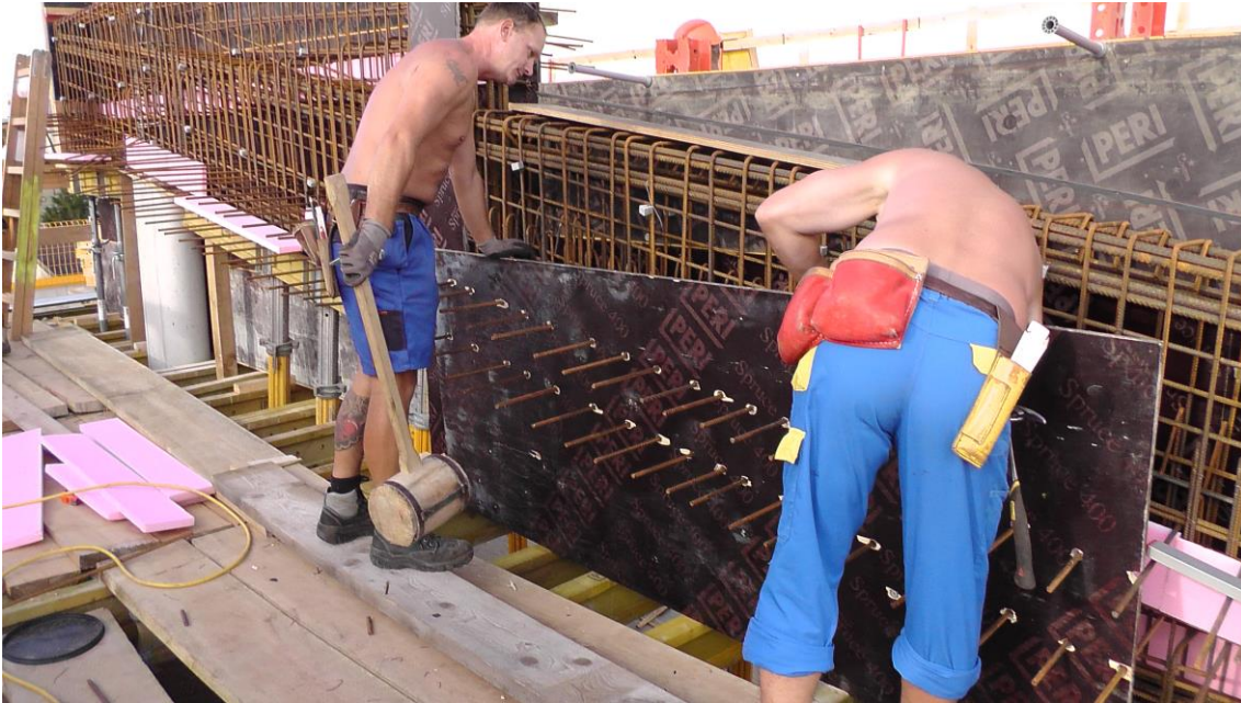
Abbildung 3-5: MH - Einbau der Seitenschalung beim Schließen der Schalung des Rampenträgers
