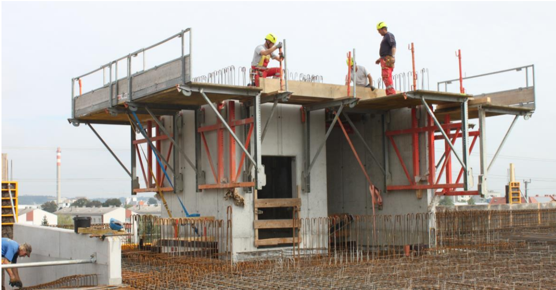
Abbildung 6-3: Aufbau der Arbeitsbühne beim Stiegenhaus – Kern mit T-Stück
