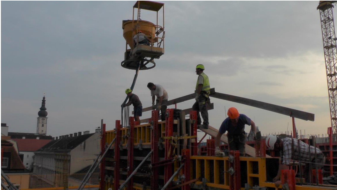
Abbildung 5-7: Betonierarbeiten am Rampenträger
