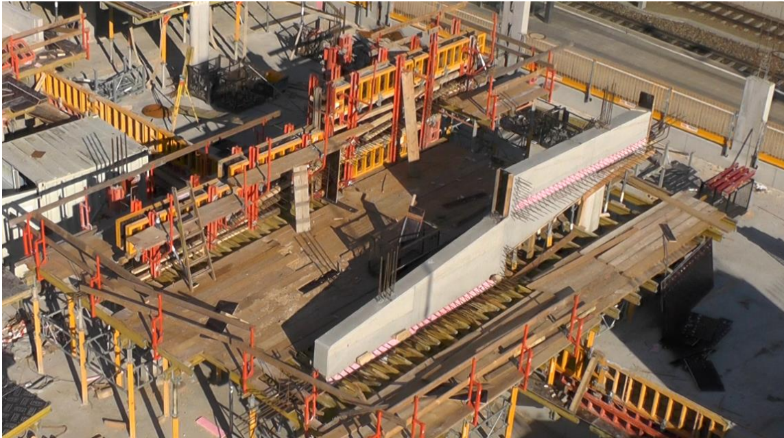
Abbildung 5-130: Ausschalen beim Rampenträgerpaar 2 (18.09.2014)
