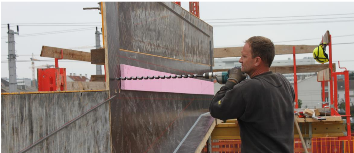
Abbildung 3-11: MN - Bohren der Löcher für die Anschlussbewehrung beim Rampenträger
