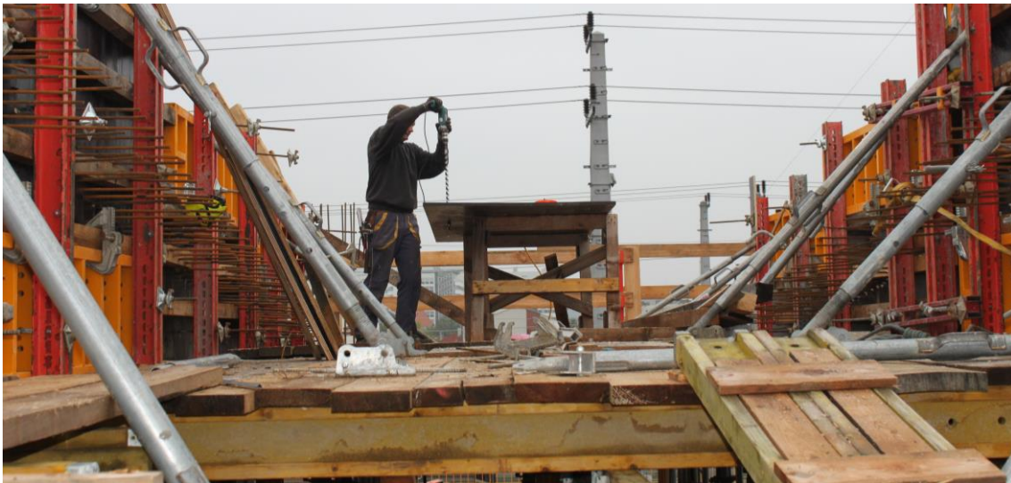
Abbildung 5-202: Arbeitsbereich der Schalungsarbeiter bei Rampenträgerpaar 1
