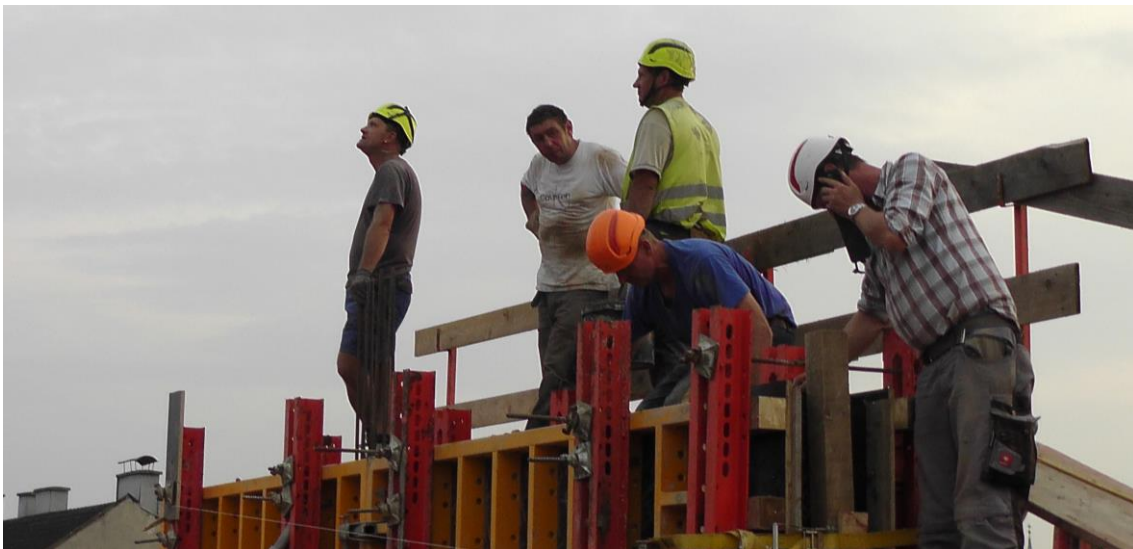
Abbildung 3-14: MA - Warten auf Kran von drei Arbeitskräften
