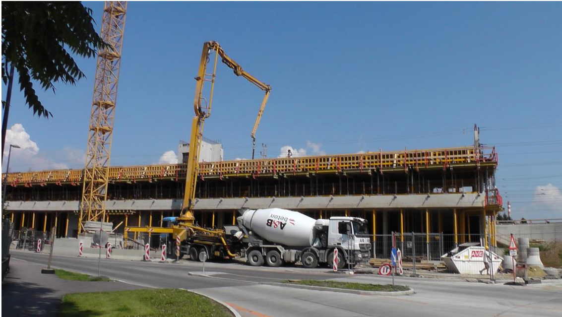
Abbildung 4-3: Autobetonpumpe und Anlieferung des Transportbetons im Ostbereich des Parkdecks
