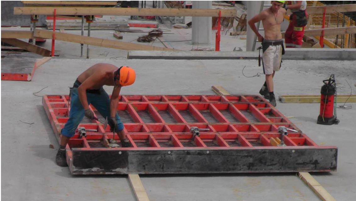
Abbildung 6-7: Auseinanderbauen der Schalungselemente auf dem Lagerplatz
