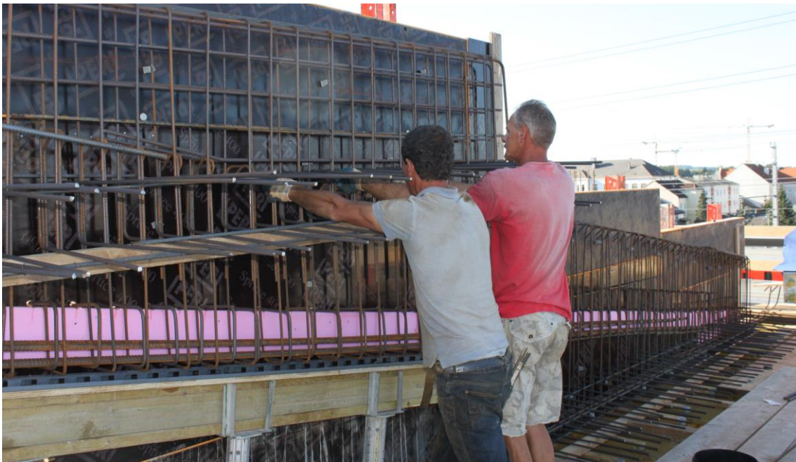
Abbildung 5-19: Einbau der Anschlussbewehrung
