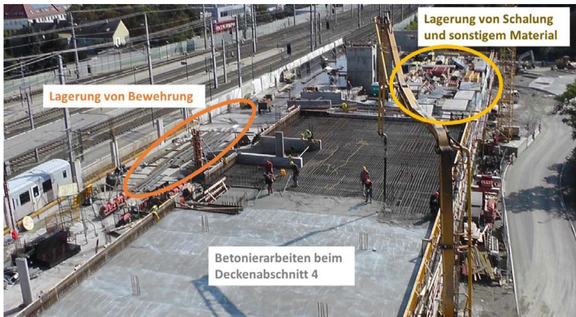
Abbildung 4-12: Betonierarbeiten beim Deckenabschnitt 4 und Lagerverhältnisse
