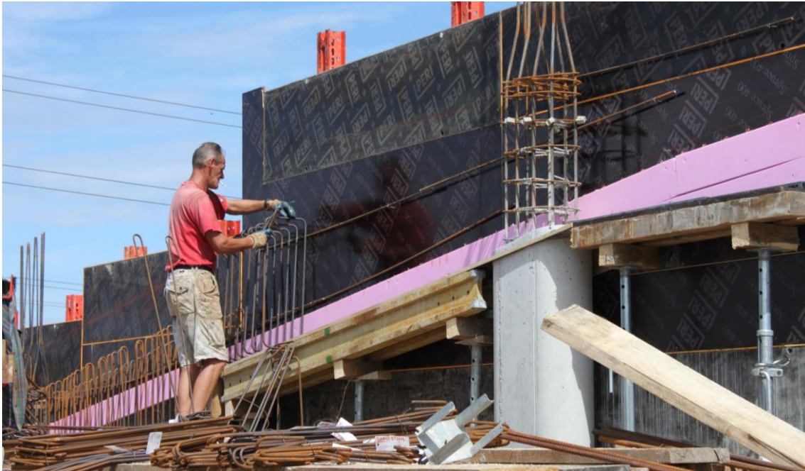
Abbildung 5-42: Einbau der Bügelbewehrung beim Rampenträger auf Stützen (29.08.2014)
