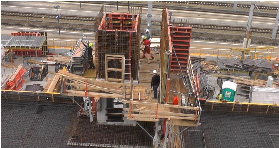
Abbildung 6-14: Abbau des Arbeitsgerüsts nach dem Abschluss der Bewehrungsarbeiten beim Stiegenhaus: Kern mit T-Stück (29.09.2014)
