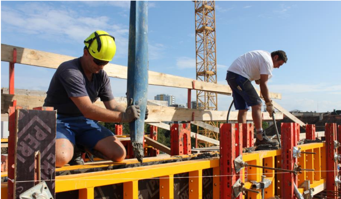
Abbildung 5-29: Betonierarbeiten beim Rampenträger
