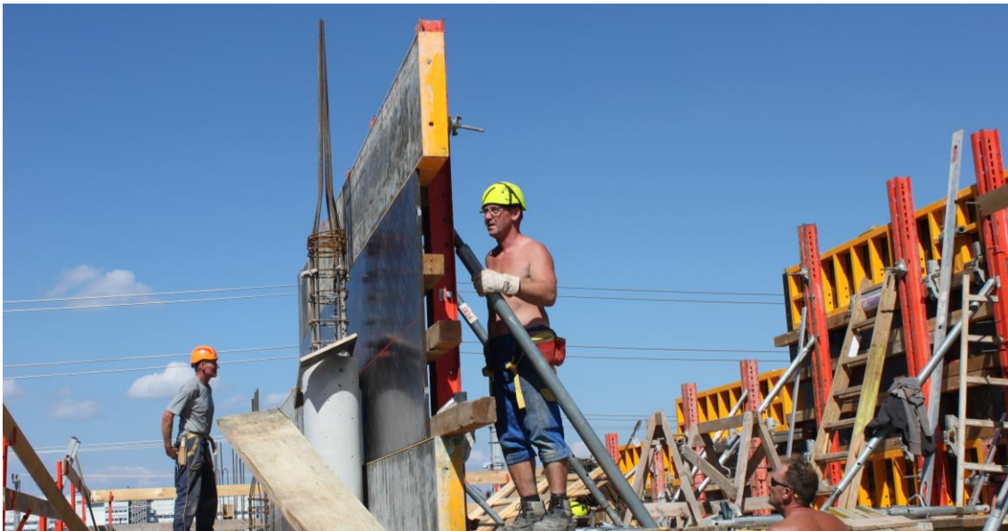
Abbildung 5-17: MH - Einrichten und Justieren der Schalung
