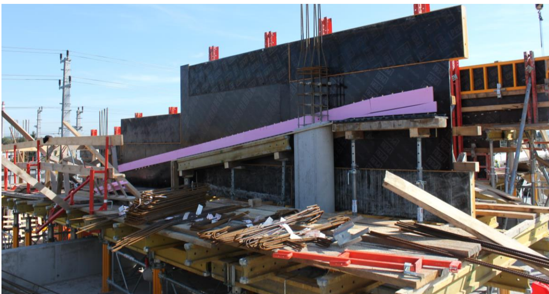
Abbildung 5-20: Lagerung der Bewehrung auf der Außenseite des Rampenträgerpaares
