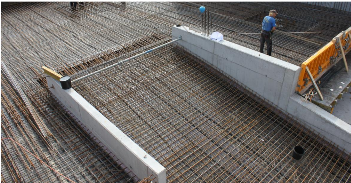
Abbildung 5-2: Rampenträgerpaar beim Anschluss der Deckenbewehrung
