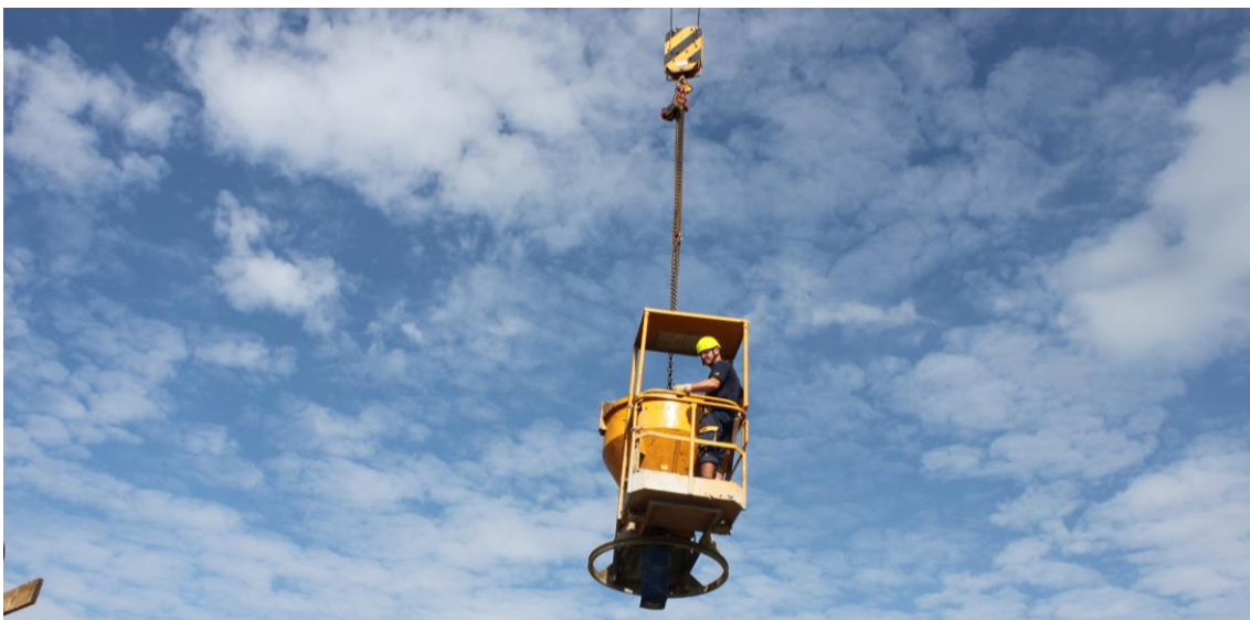
Abbildung 5-83: Arbeitskraft beim Transport des Betons mit dem Krankübel (N7)
