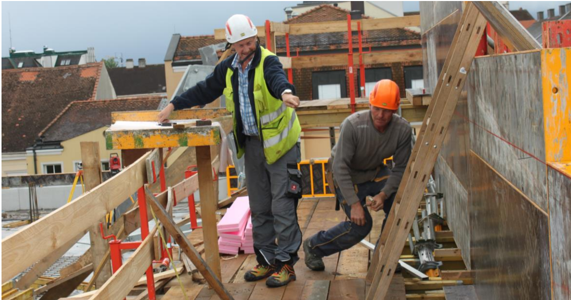
Abbildung 3-3: Tätigkeiten auf der Baustelle
