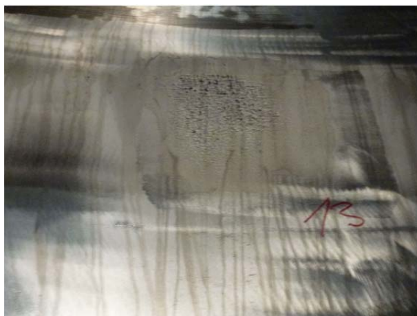
Abbildung 1-2 Kavitationsschäden am Laufradmantel
