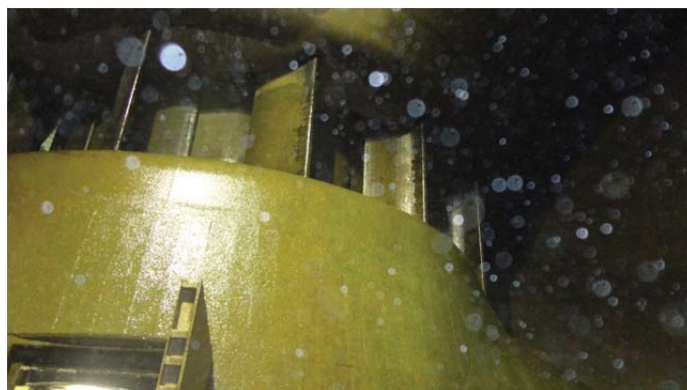
Abbildung 4-1 Aufnahme der Halbspirale bei Kraftwerksbegehung
