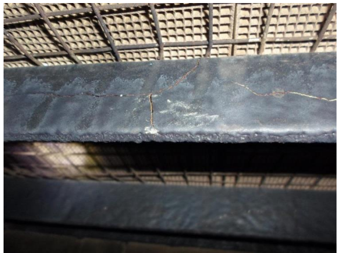
Abbildung 4-6: Dokumentierte Schäden (links: Korrosion der Rohgasleitung; rechts: Beschädigung der Beschichtung im Konus)
