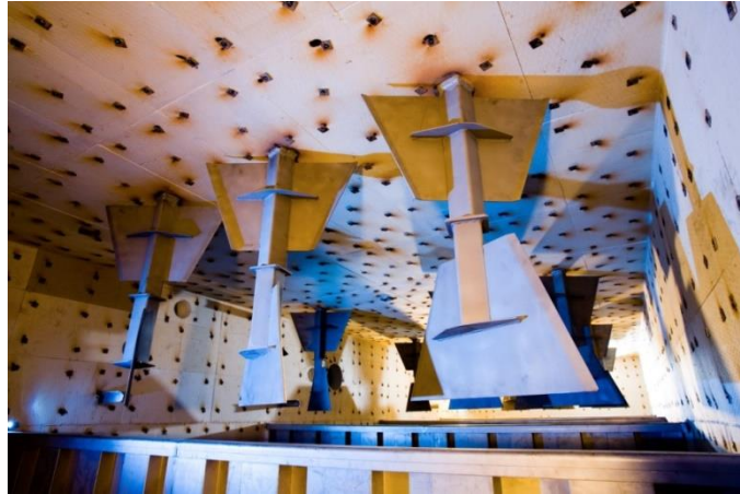
Abbildung 2-16: Eingebaute Mischerbleche (Quelle: CTP GmbH)
