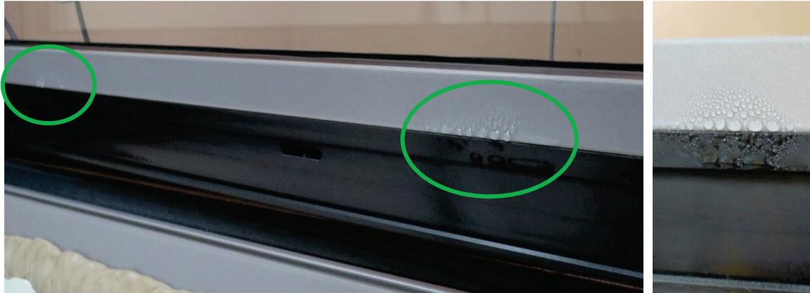
Abb. 19 C-03 F003 (links); C-02 F002 (rechts): Kondensat am Verbundflügen gegenüber der Dampfdruckausgleichsöffnungen des Hauptflügels
