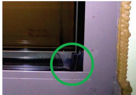
Abb. 26 D-05 (F003): Innenseitigen Glasanlagendichtung um ca. 3 cm gelöst
