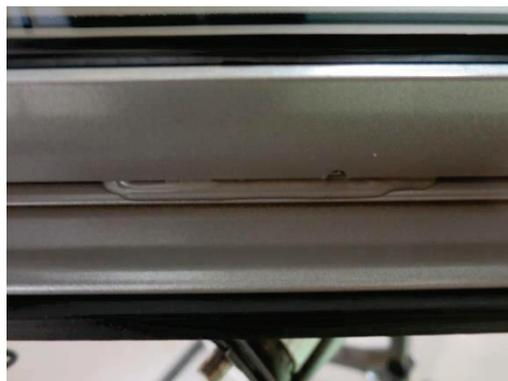
Abb. 24 D-03 (F002): Ausgetretenes Kondenswasser aus der Dampfdruckausgleichsöffnung nach dem Lösen der Abdichtung
