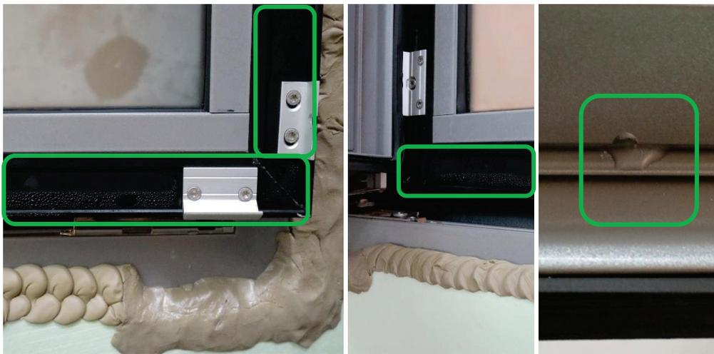
Abb. 16 B-04 - Kondensat am Verbundflügel außerhalb der Dichtebene: unterer Eckbereich schließseitig bei F002 (links) und unterer Eckbereich bandseitig beim F003 (Mitte); Kondensat bei unterer Dampfdruckausgleichsöffnung des Hauptflügels des Fensters F003 (rechts)
