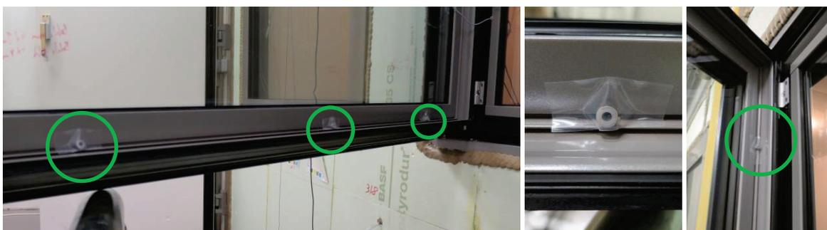
Abb. 21 D-01: Abdichtung der Dampfdruckausgleichsöffnungen (von links nach rechts): Öffnungen im unteren Bereich des Flügels; Detailansicht; bandseitige Öffnung
