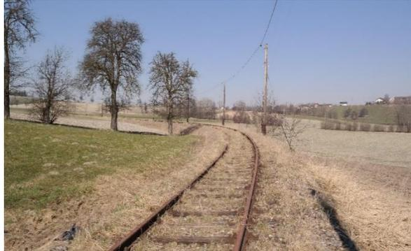
**Abbildung 4 - 1: Testmessstrecke mit starkem Bewuchs**
