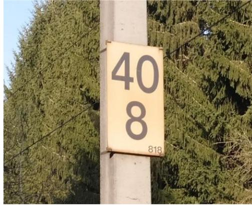
**Abbildung 2 - 6: Kilometrierungstafel am Mast auf der
