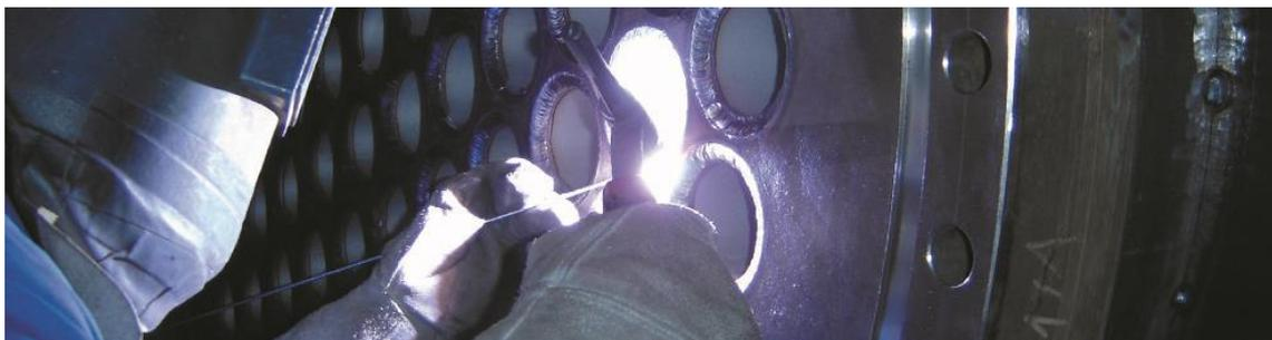
**Abbildung 32: Schweißarbeiten mit Hilfe des WIG-Verfahrens (vgl. [VOE15b])**
