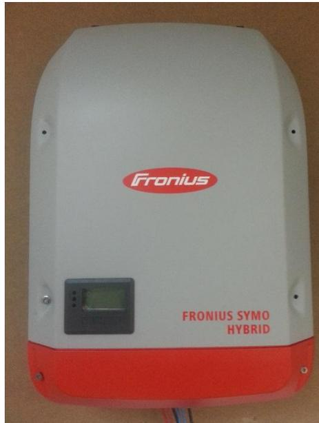
**Abbildung 4-5 Fronius Symo Hybrid 5.0-3-S Wechselrichter**
