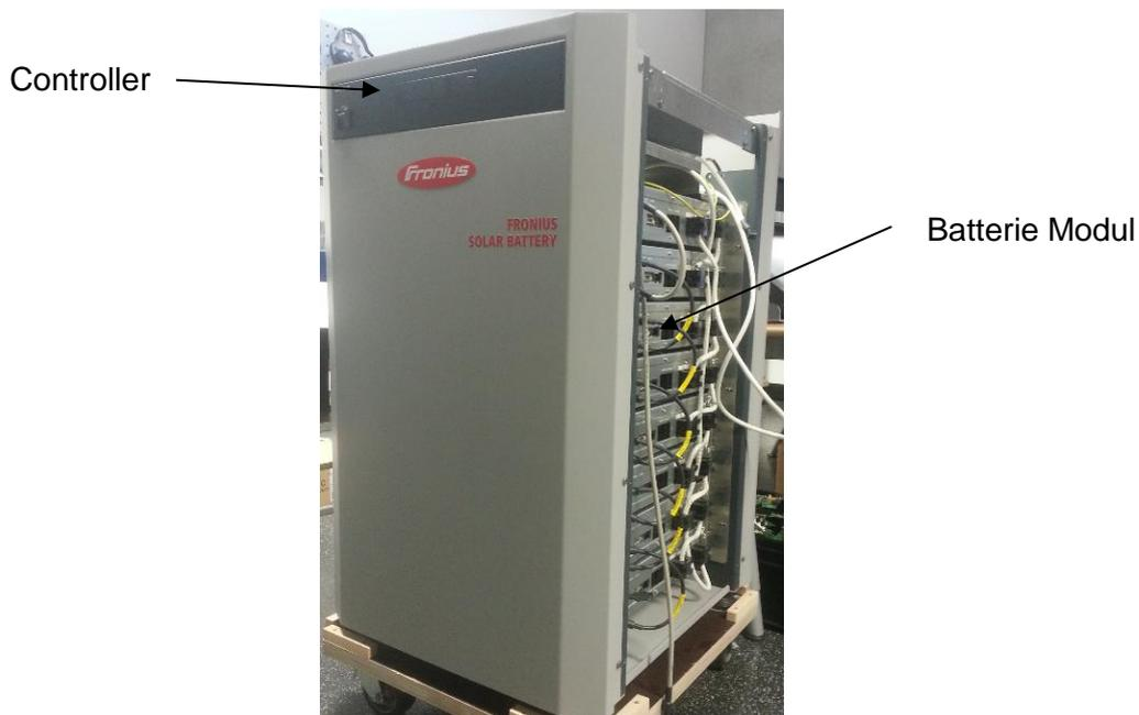
Abbildung 4-3 Fronius Solar Battery
