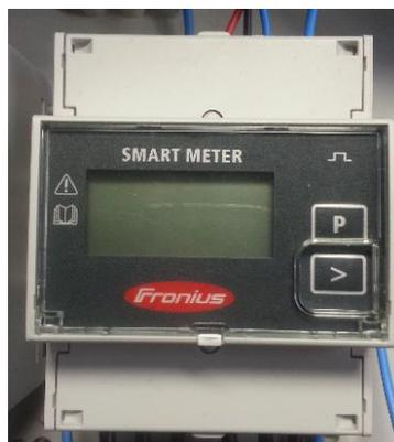
Abbildung 4-14 Fronius Smart Meter 63-1
