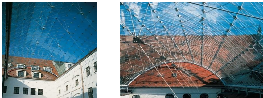
Abb. 8 Innenhofüberdachung des Maximilian-Museums in Augsburg [9]
