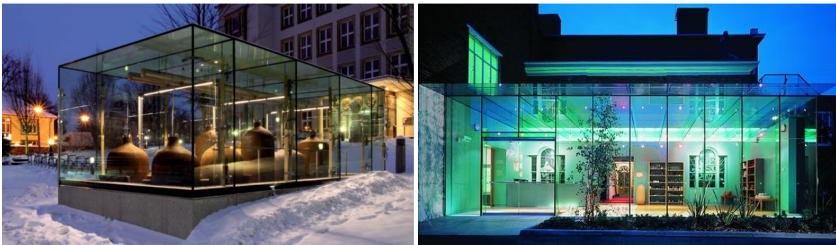
Abb. 3 Links: Ganzglashülle über den hist. Druckbehältern [4], Rechts: Glaspavillon am Broadfield House in Kingswinford [5]
