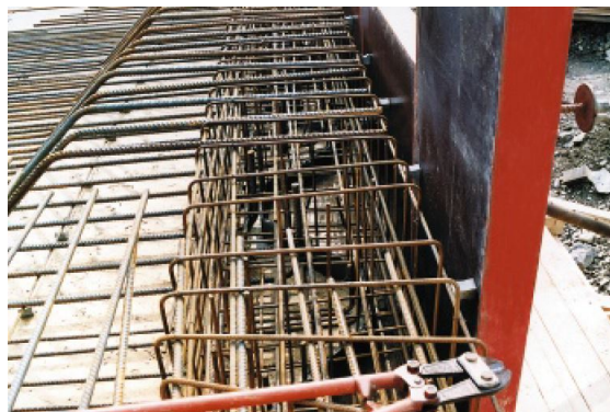
Abb. 3.1.: Beispiel für Bewehrungsführung Schneidenlagerung [7]
