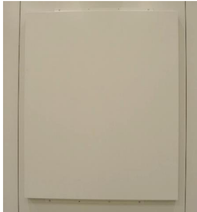
Abb. 2.9: Draufsicht, Membranabsorber
