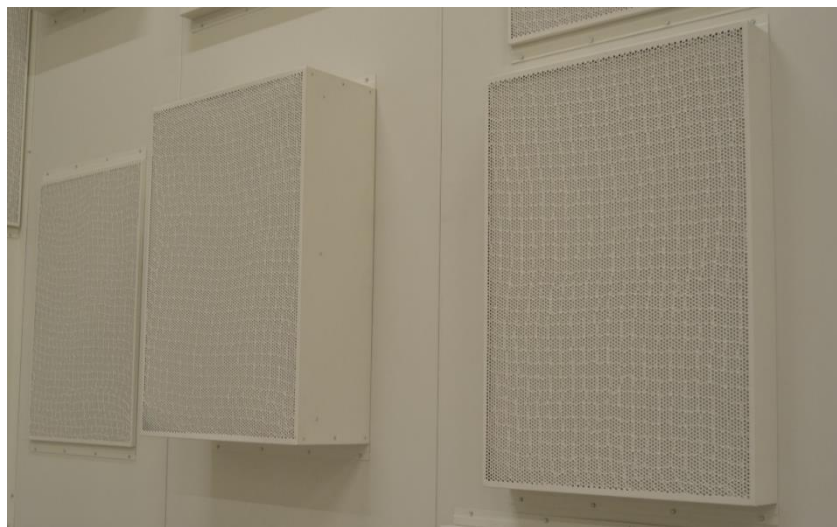
Abb. 2.8: 3 Typen von Lochplattenabsorbern
