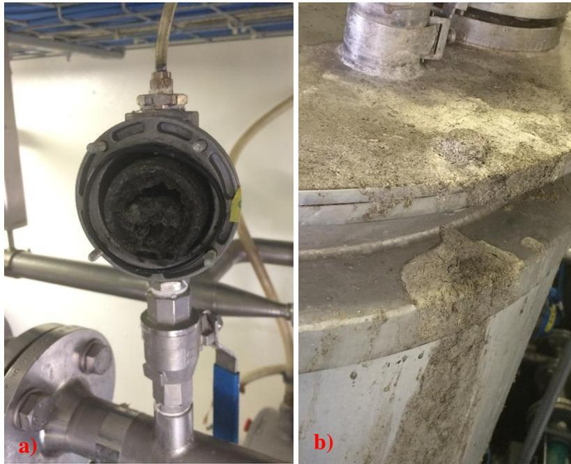
Abbildung 10: Durch das Überfüllen der Hydrolysebehälter verursachte Probleme: a) Hydrolyseschaum in der Gas-konzentrationsmessdose; b) Durch den Siphon ausgetretener Schaum an der Behälteraußenseite.
