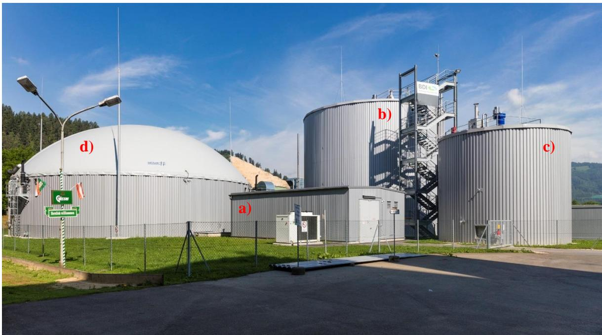
Abbildung 5: Biogasanlage der Brauerei Göss am Standort Leoben; a) Technikum, b) Fermenter, c) Hydrolyse, d) Nachfermenter mit Gasblase.
