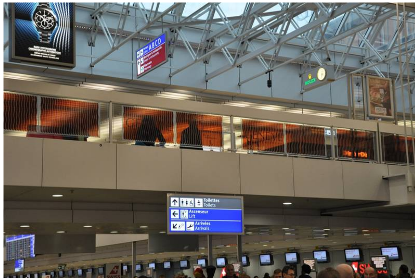
Abbildung 2.9: DSSCs als Absturzsicherung am Genfer Flughafen [5] [16]
