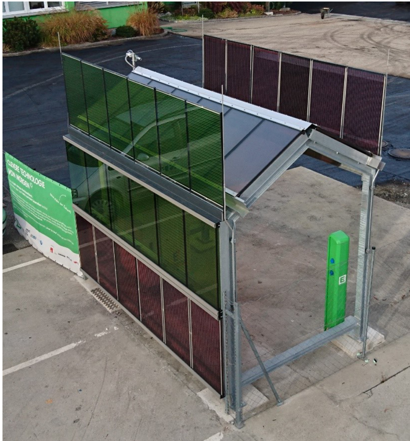
Abbildung 2.10: DSSC-Demonstrationsanlage in der Angergasse am Gelände der Energie Steiermark [3]
