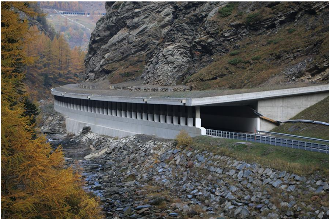
Abbildung 72: Steinschlaggalerie in Gabi, Schweiz (Simplon-Galerie) [44]
