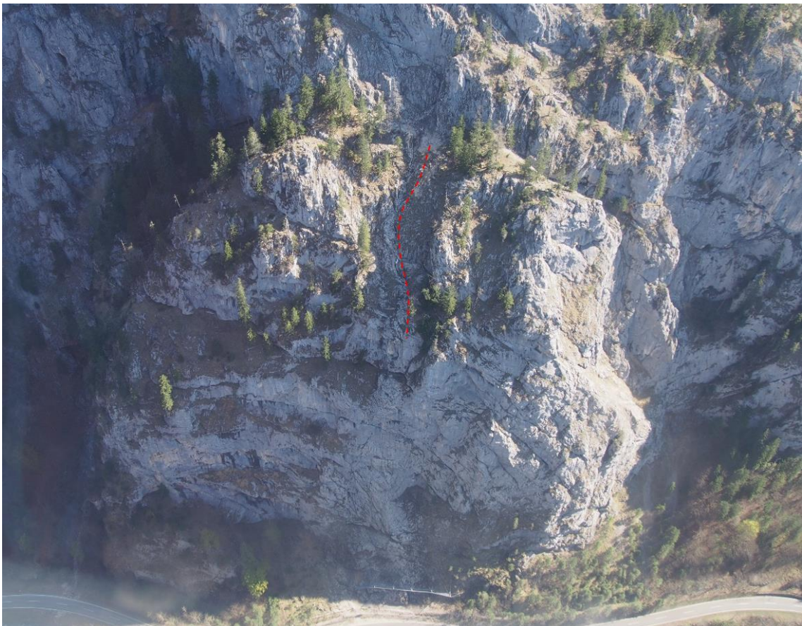
Abbildung 6: Zentraler Bereich der Felswand aus der Vogelperspektive [24]
