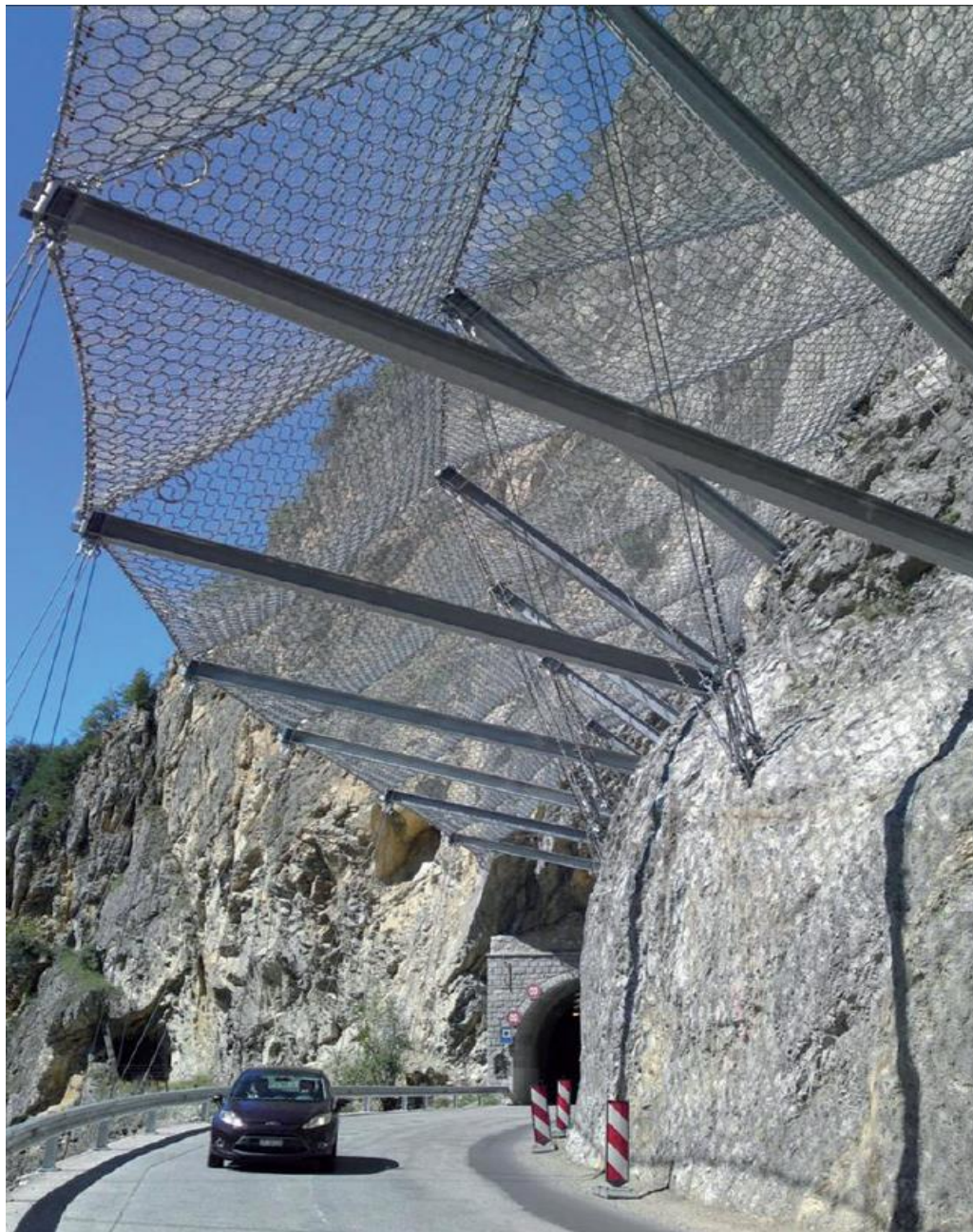
Abbildung 69: Installiertes Schutznetzsystem, Val d'Anniviers im Wallis/Schweiz [39]
