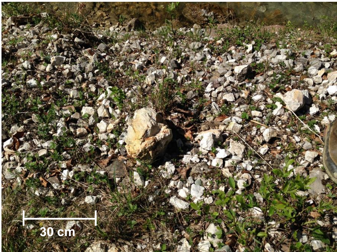
Abbildung 8: Beräumte kleinvolumige Steine am Straßenrand infolge von Steinschlagereignissen
