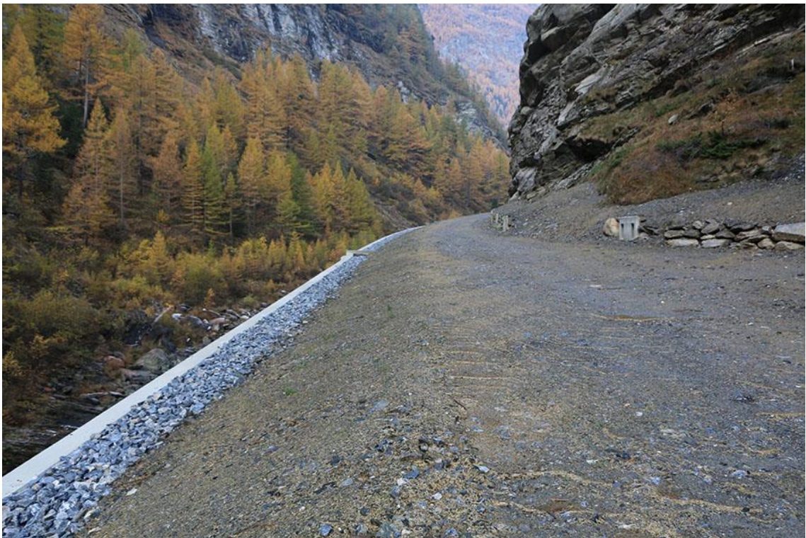
Abbildung 74: Oberste Überdeckungsschicht der Simplon-Galerie [44]
