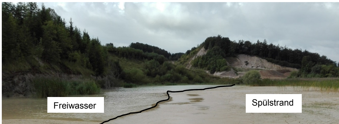
Abb. 42 Schlammteich C Übergang von Spülstrand auf Freiwasserbereich – Blick vom Damm bergwärts
