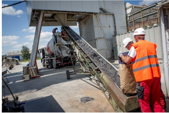
Abb. 6-2 Zugabe der Fasern in den Fahrmischer mittels eines Förderbandes
