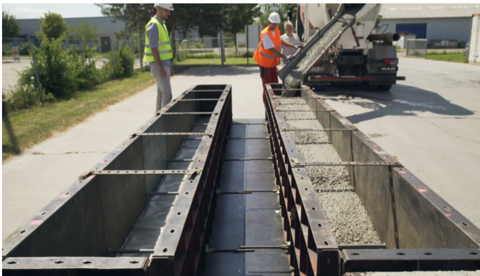
Abb. 6-5 Einseitige Befüllung des Balkens mit dem Fahrmischer
