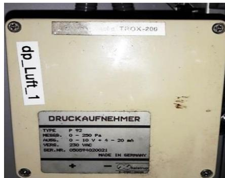
Abbildung 5-12: Luftdifferenzdruck-Transmitter "P92" von Halstrup
