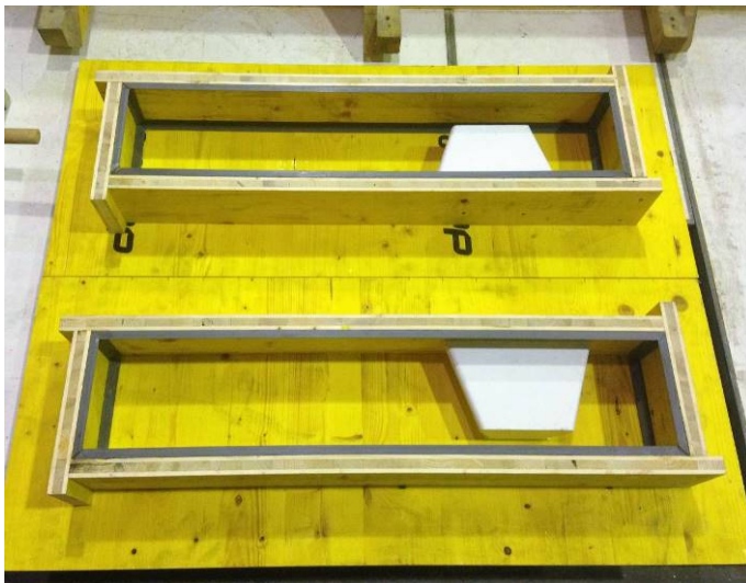
Abbildung 67: Schalung der Befestigungselemente für des Prototypen
