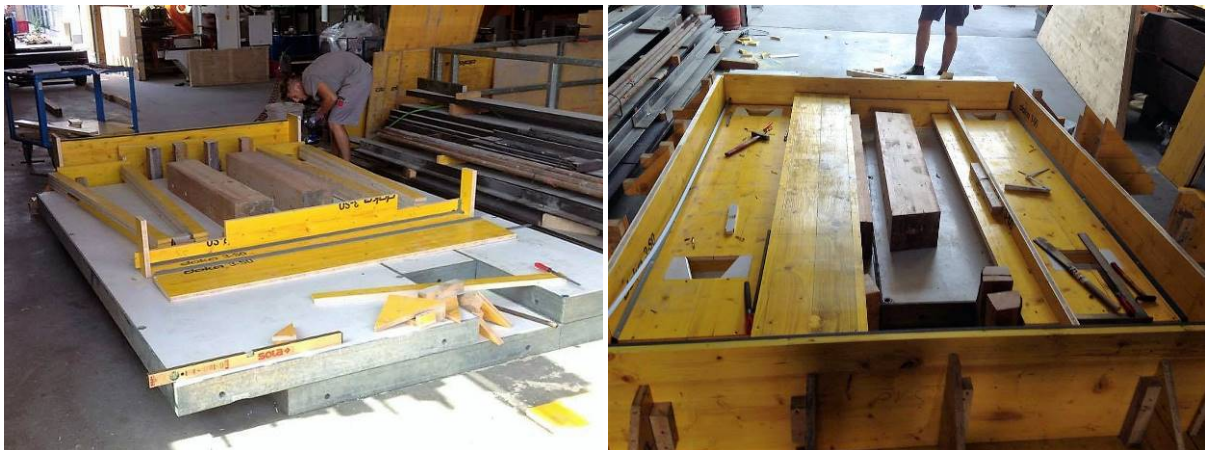
Abbildung 65: Unterkonstruktion und Schalung während des Baus
