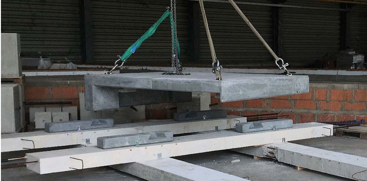
Abbildung 76: Einheben des Randbalkens und Einschieben in die zuvor montierten Befestigungselemente
