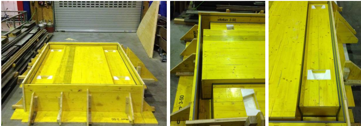
Abbildung 66: Schalung nach Fertigstellung einschl. Schalungseinsätze und Randleisten
