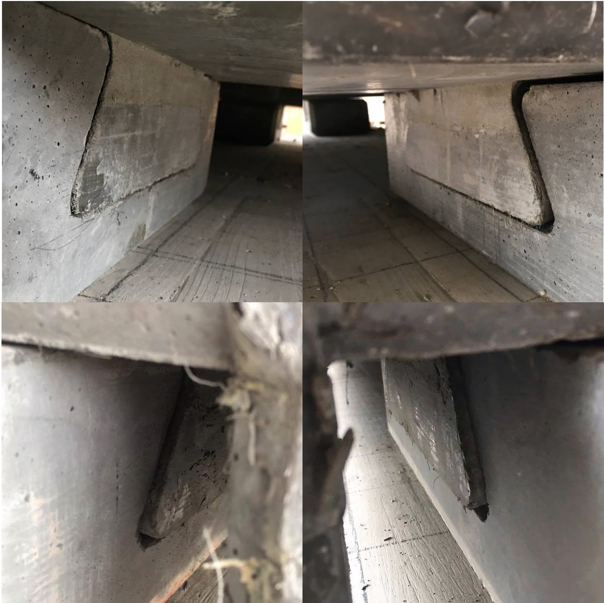
Sitz der vier Schwalbenschwanzverbindungen nach der Montage
