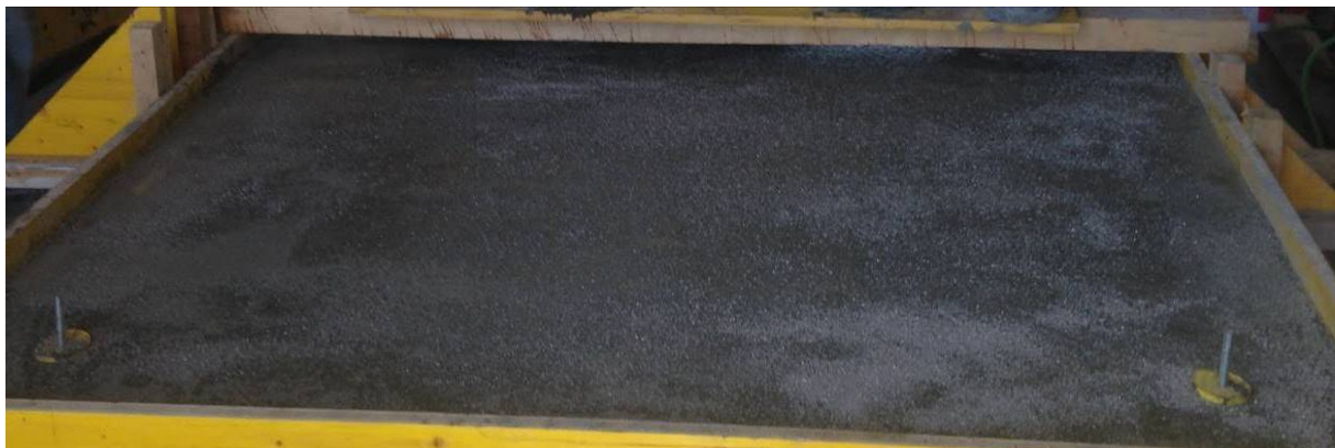
Abbildung 71: oben: Besprühen der Randbalkenoberfläche mit Wasser, darunter: das abschließende Aufbringen des Quarzsands
