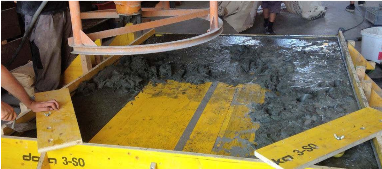
Abbildung 70: Einbau des Beton in die Randbalkenschalung
