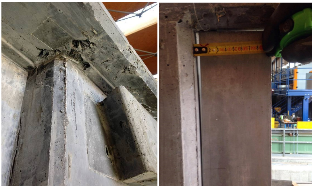
Abbildung 74: links: große Fehlstelle auf der Unterseite des Randbalkens, rechts: Prüfung der Ebenheit der Randbalkenunterseite, deutliche Abweichung erkennbar
