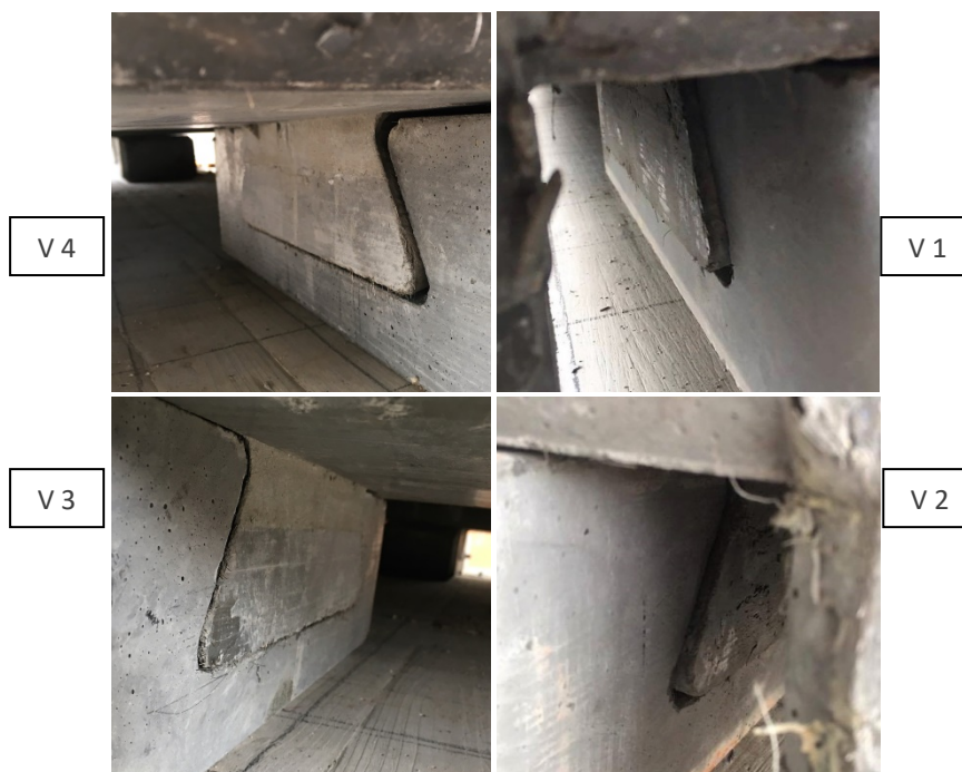
Abbildung 77: Schwalbenschwanzverbindungen nach der Montage (v.l.n.r. V2, V1, V3, V4)
