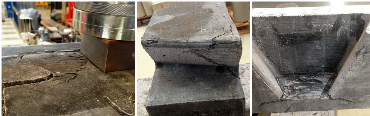
Abbildung 58: leichtes blättern der Oberfläche und Reinstanzen des Schwalbenschwanzes (links), Risse im Schwalbenschwanz (mitte), Biegerisse im Gegenstück (rechts) – Versuchskörper 2
