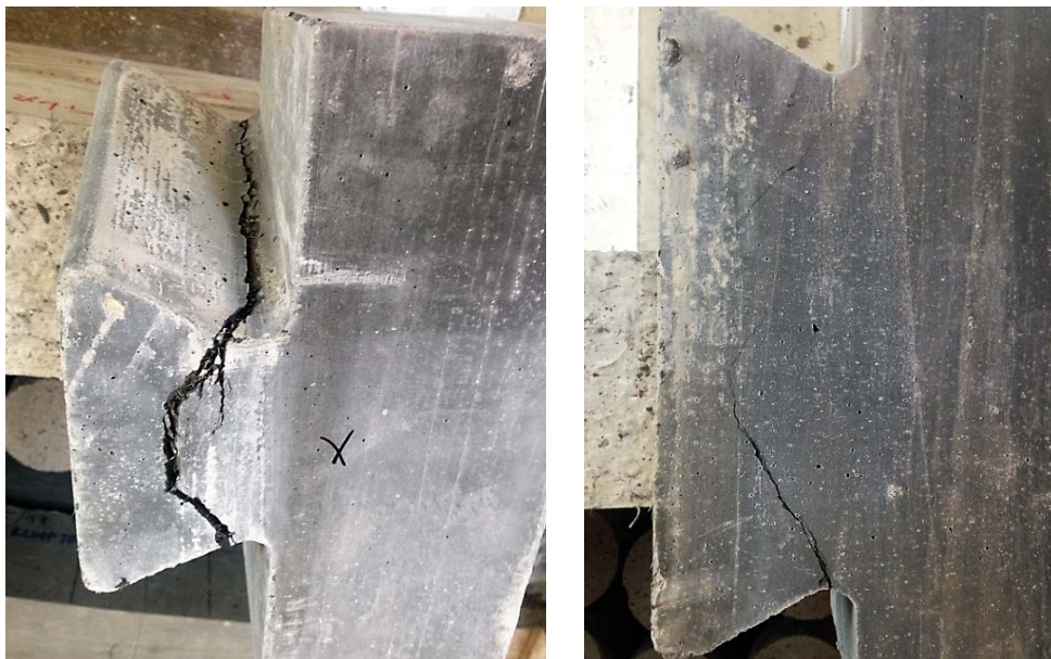
Abbildung 53: stark gerissene Rückseite (links) und kaum gerissene Vorderseite (rechts) des Schwalbenschwanzes des 3. Versuchssatzes
