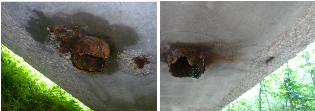
Abbildung 19: geschädigte Kragarmenden
