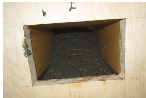
Abbildung 5.10.: Blick ins Innere des Schalungselementes des eingefüllten Betons
