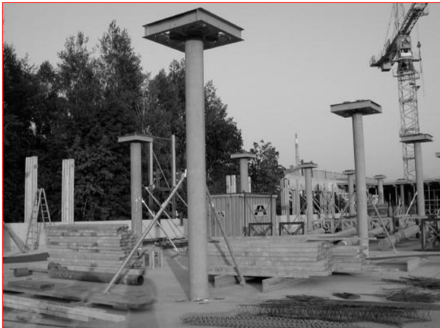
Abbildung 3.4.: Hochbewehrte Schleuderbetonstützen, UKH-Linz [Rinnhofer.2003]
