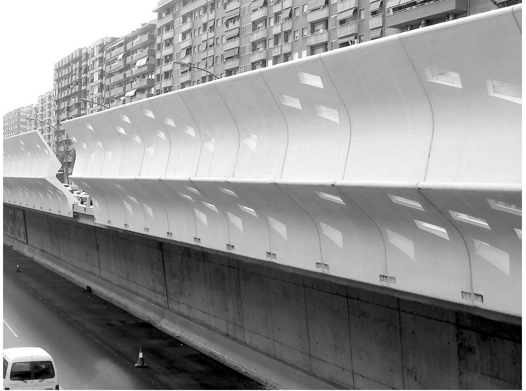
Abb. 3 | Die akustischen Paneele wurden entlang der Gran Via in Barcelona, Spanien installiert. Das Projekt wurde vom Architekturbüro Miralles Tagliabue entworfen.
