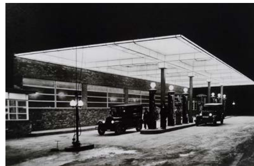
Abb. 10: Großtankstelle, Teltower Straße, Berlin um 1930
