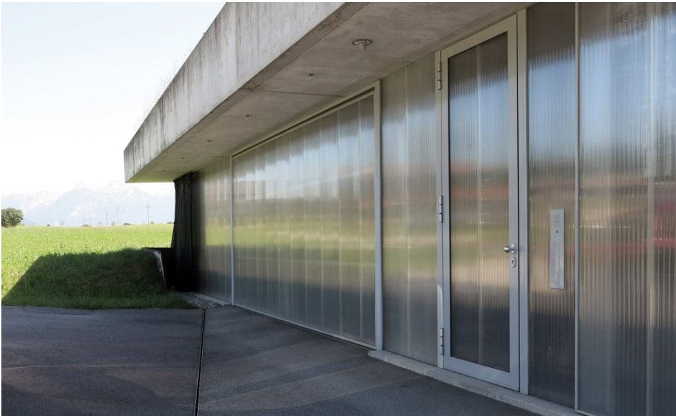
Abb. 30: Zufahrt und Eingangsbereich
