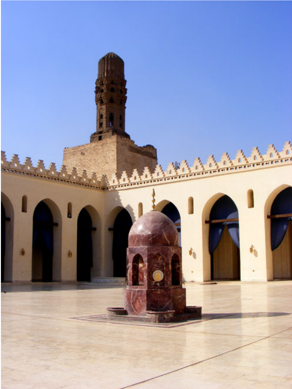
Abb. 12: Innenhof der al-Hakim Moschee in Kairo
