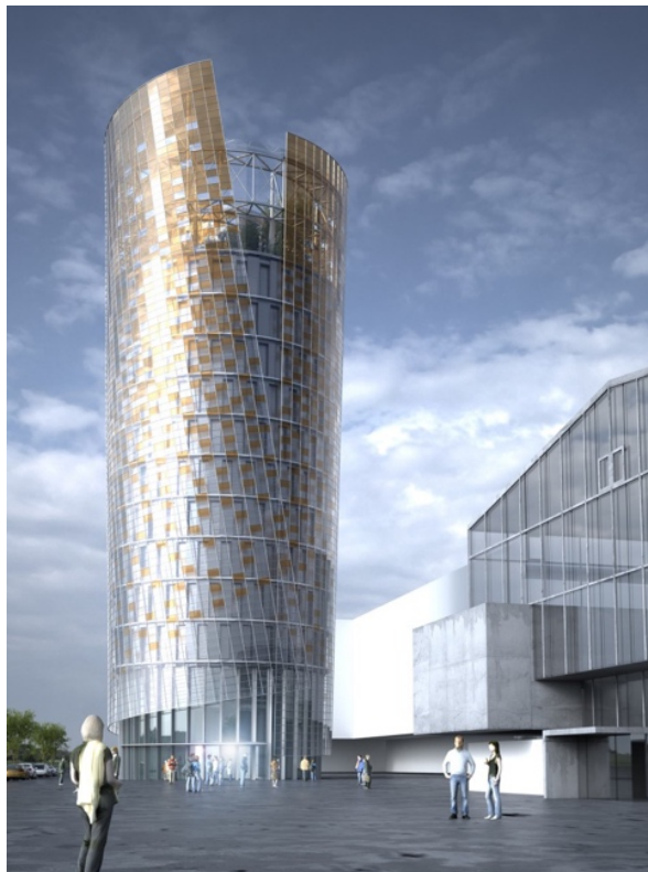
Abbildung 2-12: Fassadenintegrierte Grätzel-Zellen im Science Tower ( http://www.smartcitygraz.at/moretex-was-ist-der-science-tower-forschungsturm/ , 10.04.2016)
